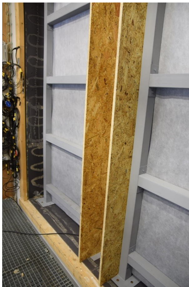
Obrázek 4 – Nosný skelet před zakrytím tepelnou izolací
