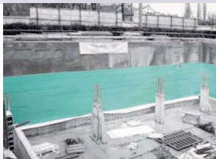
FIBRAN xps 300-L, tepelná ochrana injektovaných stěn – inverzní skladba
