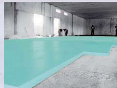
Tepelná izolace vysoce zatížených podlah s FIBRAN xps 300-L
