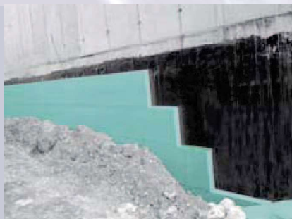
FIBRAN xps 300-L, mechanická ochrana hydroizolace a současně tepelná izolace sklepních prostorů
