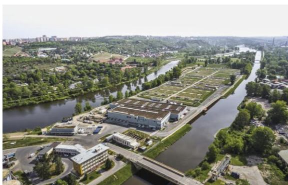
Obr. 4: ÚČOV – pohled na novou vodní linku [29]
