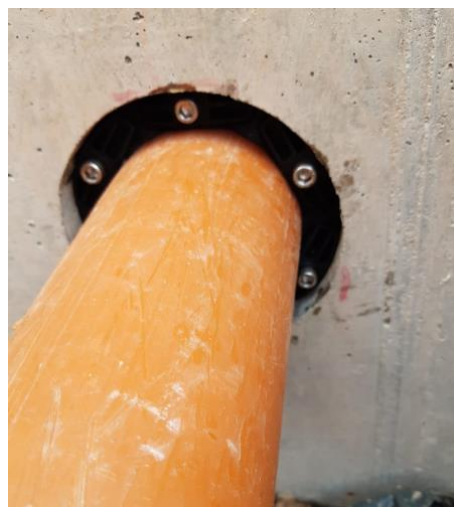
Obr. 71: Utěsnění prostupu
