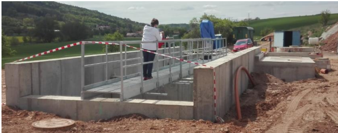
Obr. 74: Stavba ČOV Kamenice
