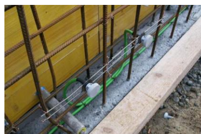
Obr. 66: Injekt. hadička ukončená injekt. Pakry[28]
