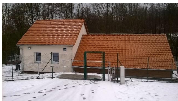
Obr. 10: ČOV v Malečově – pohled zvenku
