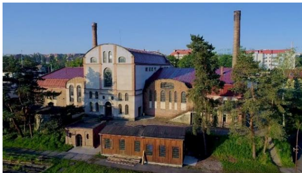
Obr. 1: ČOV Praha-Bubeneč pohled z exteriéru [35]
