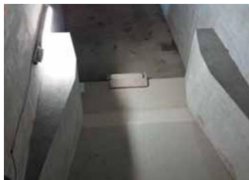
Obr. 5: Parshallův žlab [18]
