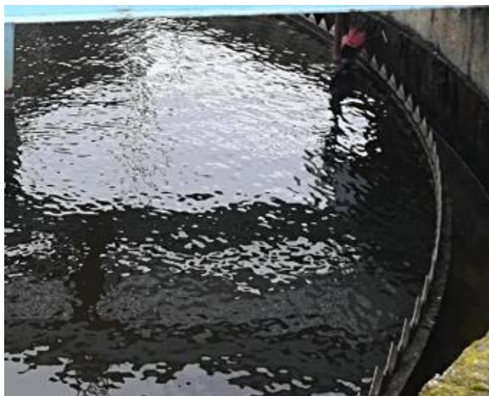
Obr. 21: Detail přepadové hrany
