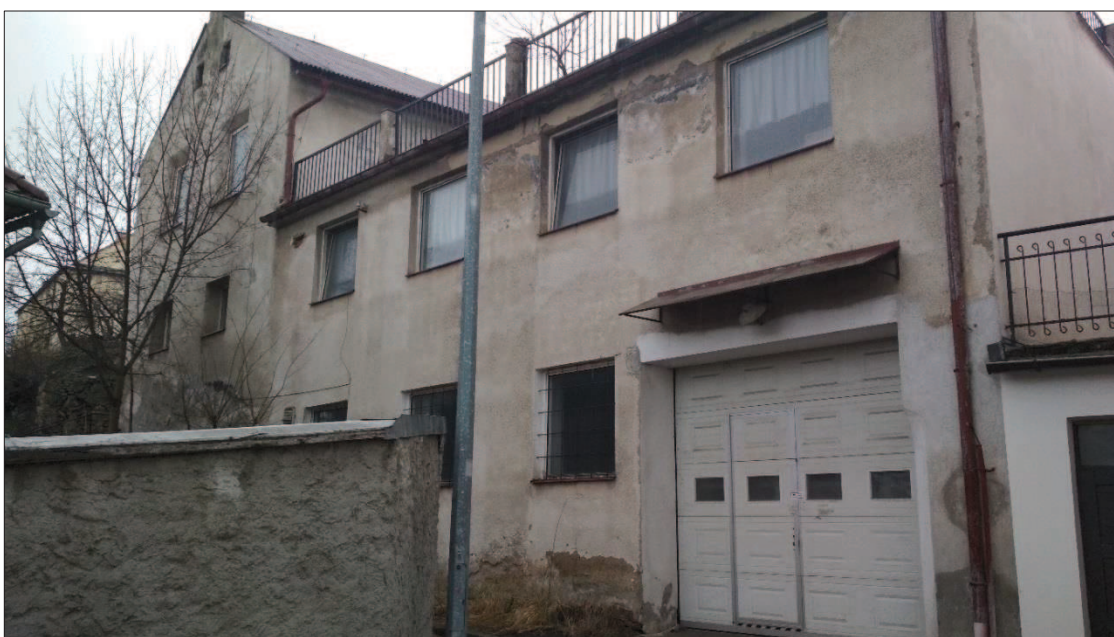
Obrázek 5: Stávající objekt, pohled z ulice V Domcích.
