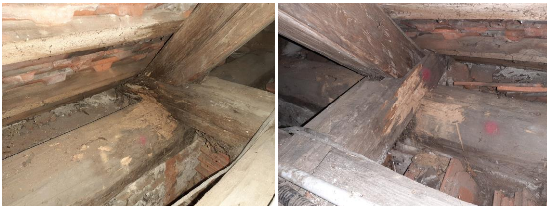
Obr. 68 Foto K1.5.1. pozednice a vazný trám
