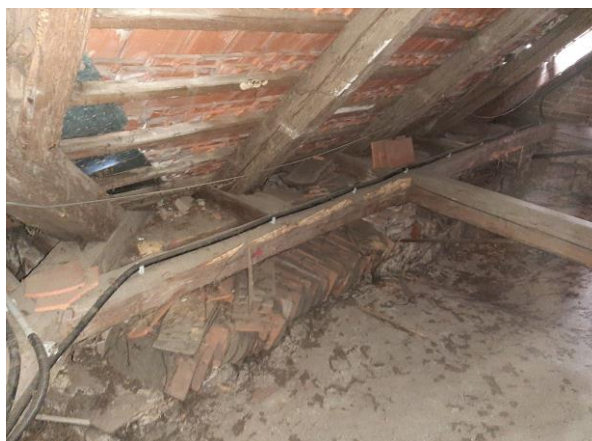
Obr. 78 Foto K1.11.1. výměna
