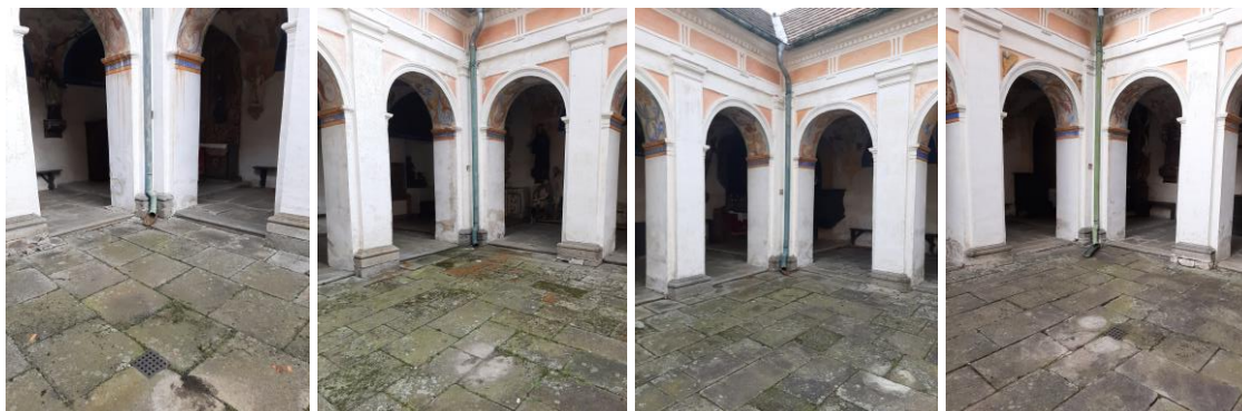
Obr. 23 Foto V.3.1. - severovýchodní svod (vpust')
