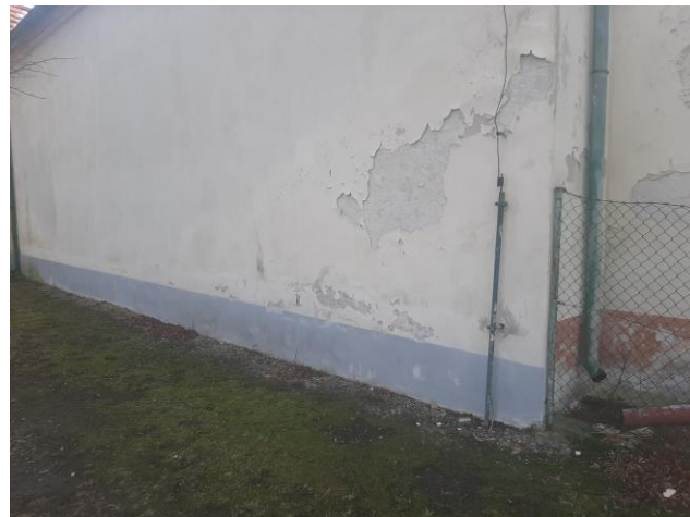
Obr. 15 Foto V.1.4. - severozápadní roh objektu
