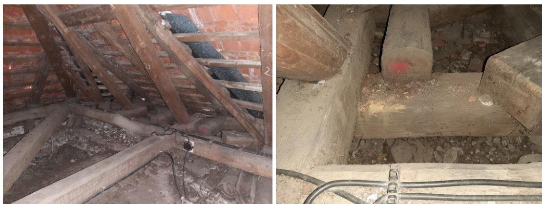
Obr. 64 Foto K1.3. a Obr. 65 Foto K1.3.1. pozednice
