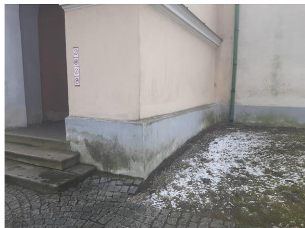
Obr. 13 V.1.3. - strana věže 2
