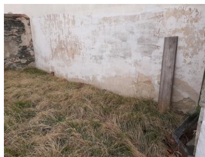
Obr. 20 Foto V.1.9. - vlhkost v ex.
