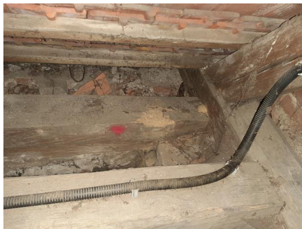
Obr. 77 Foto K1.10. pozednice
