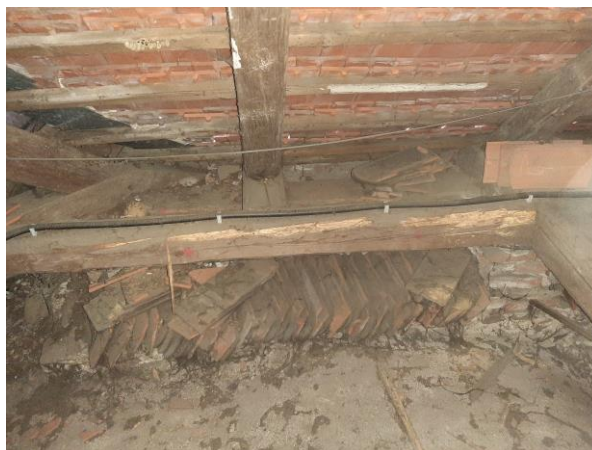
Obr. 79 Foto K1.11.2. výměna
