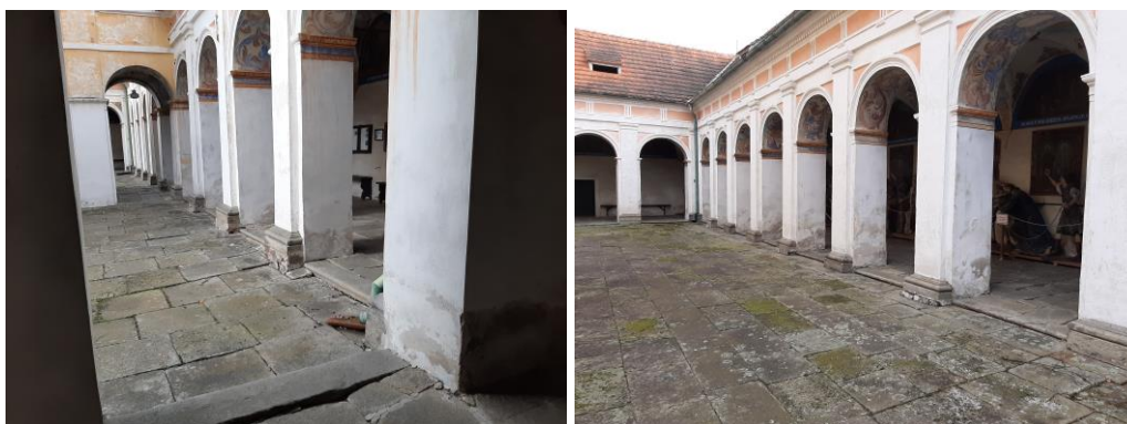
Obr. 27 Foto V.3.5. Obr. 28 Foto V.3.6. Obr. 29 Foto V.3.7. Obr. 30 Foto V.3.8. - sloupy ambitů
