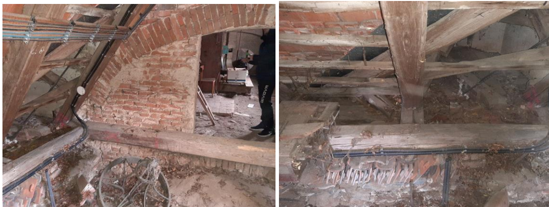
Obr. 62 Foto K1.2. a Obr. 63 Foto K1.2.1. pozednice
