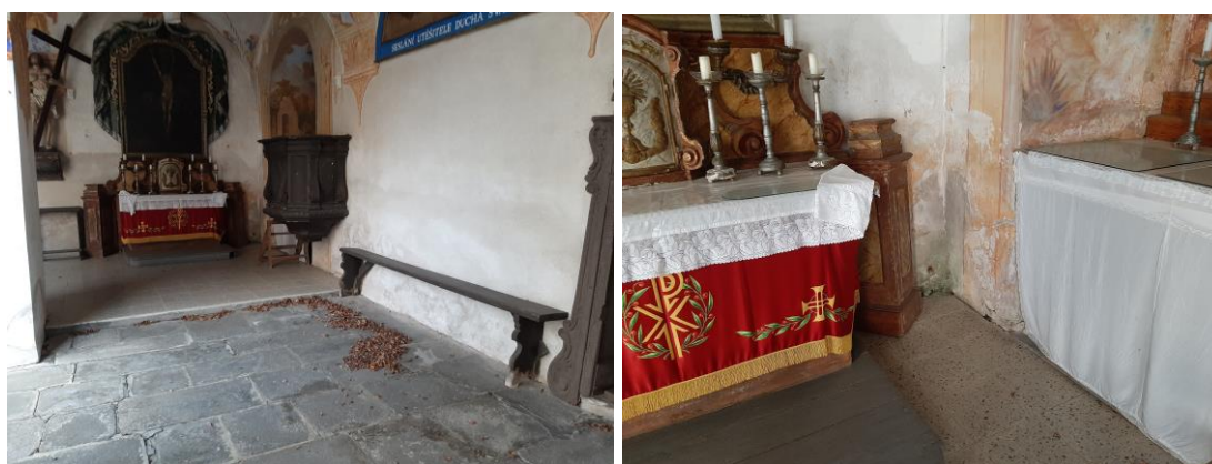
Obr. 37 Foto V.3.15. a Obr. 38 Foto V.3.15.1. - stěny ambitů
