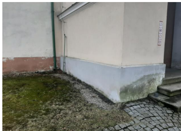
Obr. 12 Foto V.1.2. - strana věže 1
