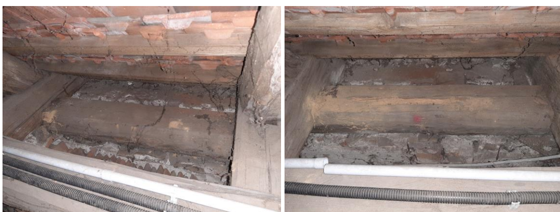
Obr. 66 Foto K1.4. pozednice
