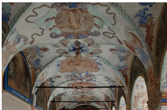
Obr. 44 Foto T.1.4. - klenba ambitu
