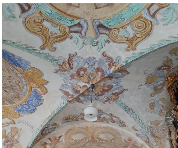
Obr. 45 Foto T.1.5. - klenba ambitu
