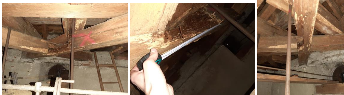
Obr. 54 Obr. 55 Obr. 56 trámy věže
