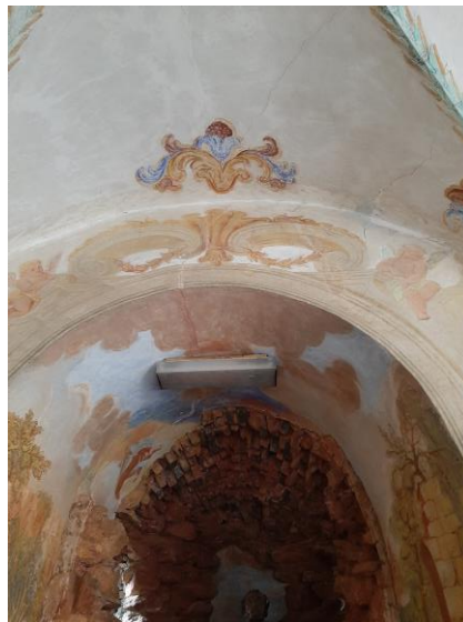
Obr. 51 Foto T.1.9. - klenba ambitu
