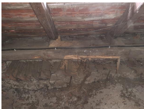
Obr. 80 Foto K1.11.3. výměna
