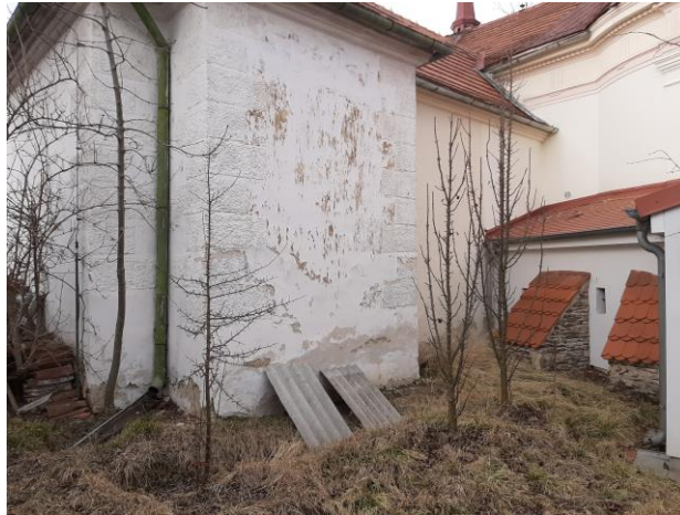
Obr. 93 Foto V.1.13. - vlhkost v ex.
