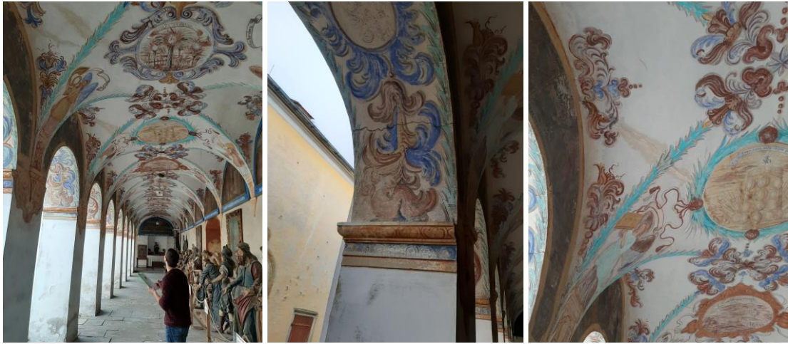
Obr. 47 Foto T.1.7. Obr. 48 Foto T.1.7.1. Obr. 49 Foto T.1.7.2. - klenba ambitu
