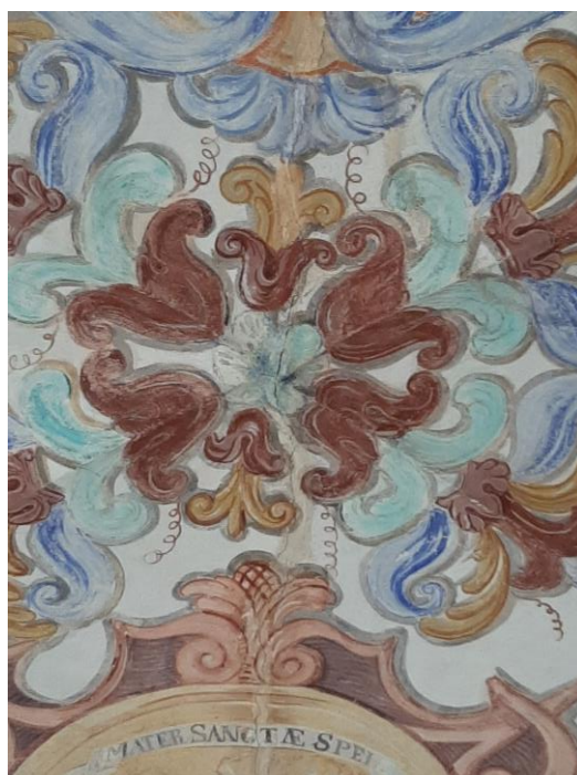
Obr. 46 Foto T.1.6. - klenba ambitu
