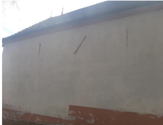
Obr. 11 Foto T.1.1. - klenbové kleště (závlače)
