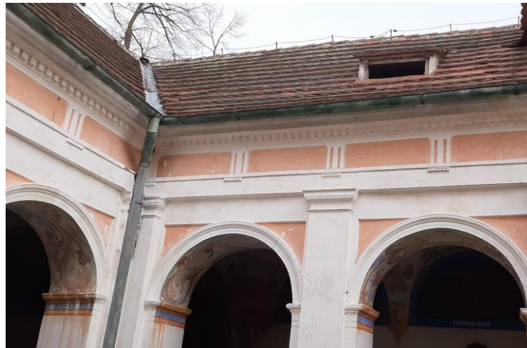
Obr. 50 Foto T.1.8. - klenba ambitu
