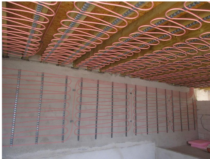
Obrázek č. 20: Kombinace stěnového a stropního vytápění [34]
