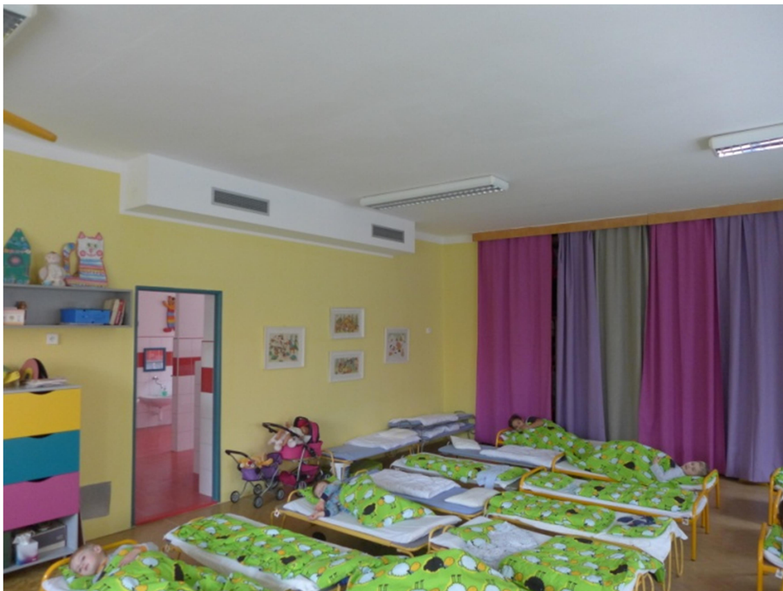
Instalace větrání při rekonstrukci MŠ u Dubu v Týništi nad Orlicí. [24]
