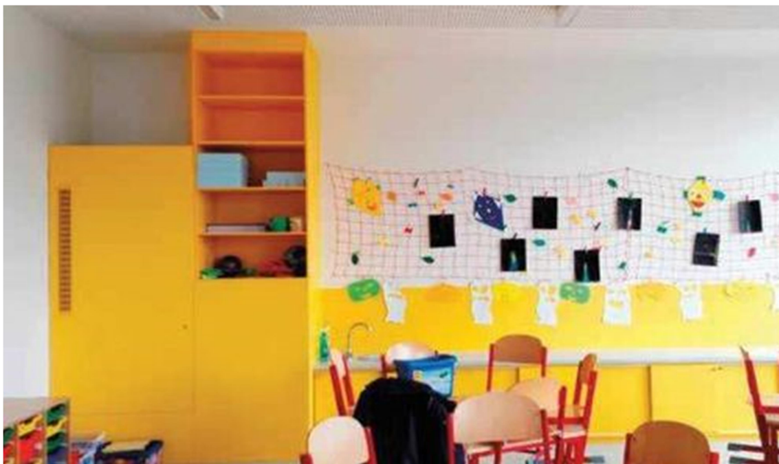
V ZŠ a MŠ Nezamyslice mají rekuperační rovnotlakou lokální větrací jednotku přímo ve třídách. [28]
