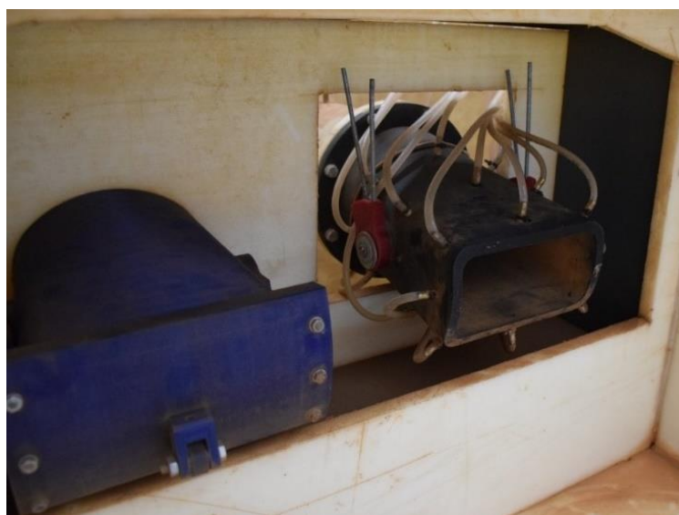
Obrázek 43 Horní nádrž a přívod vody - jiný pohled
