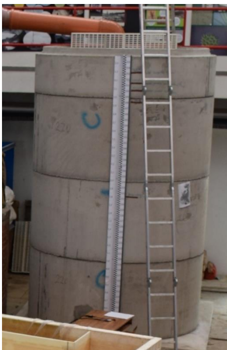
Obrázek 6 Horní nádrž - pohled z vnějšku
