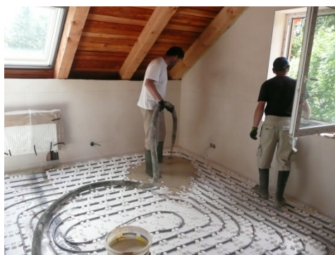
Obr. 21 - Lití anhydritového potěru
