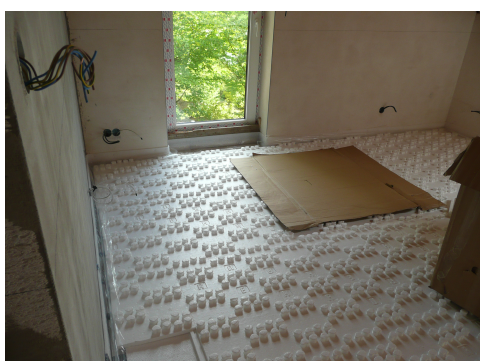
Obr. 4 - Systémová deska s nopy uložena na kročejové izolaci
