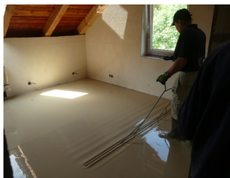
Obr. 22 - Urovnávání anhydritového potěru
