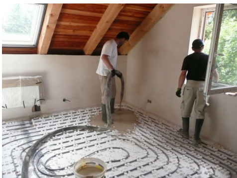
Obr. 7 - Lití anhydritového potěru
