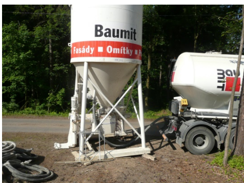
Obr. 9 - Doprava suché směsi potěru
