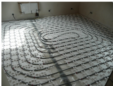
Obr. 6 - Uložené potrubí
