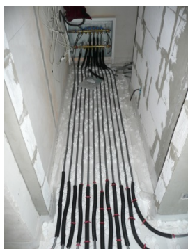
Obr. 12 - Nástěnný rozdělovač, chráničky potrubí v místě průchodu konstrukcí
