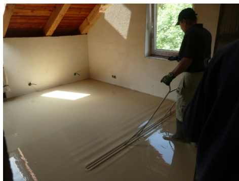
Obr. 8 - Urovnávání vylitého potěru speciálním přípravkem
