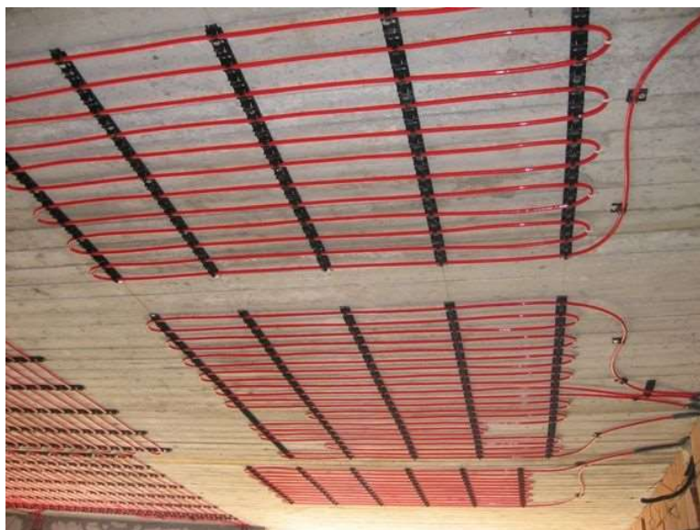
Obrázek 13: Stropní vytápění [8]
