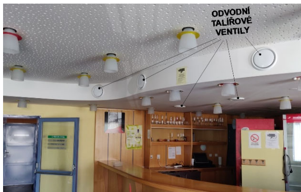
Obr. 1.26: Odvodní talířové ventily v místě baru na spodním patře [autorská tvorba]
