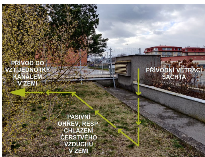
Obr. 1.17: Přírodní větrací šachta pro VZT jednotku [autorská tvorba]
