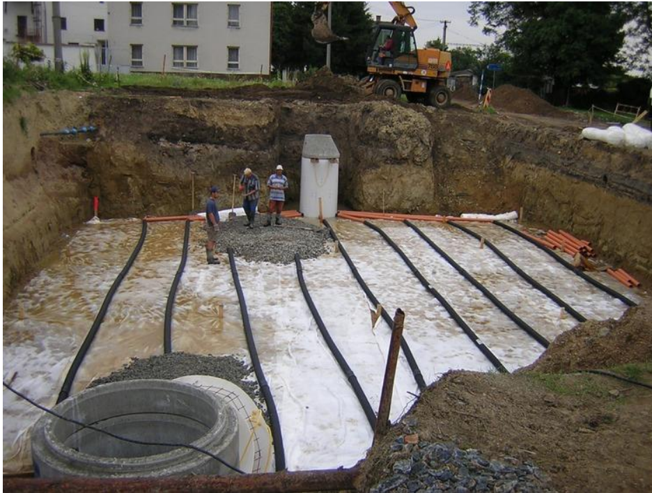
Obr. 6 Drenážní vsakovací systém
