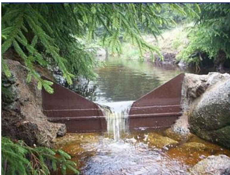
Obr. 6. Foto přelivu POR (Šanda, 2007)
