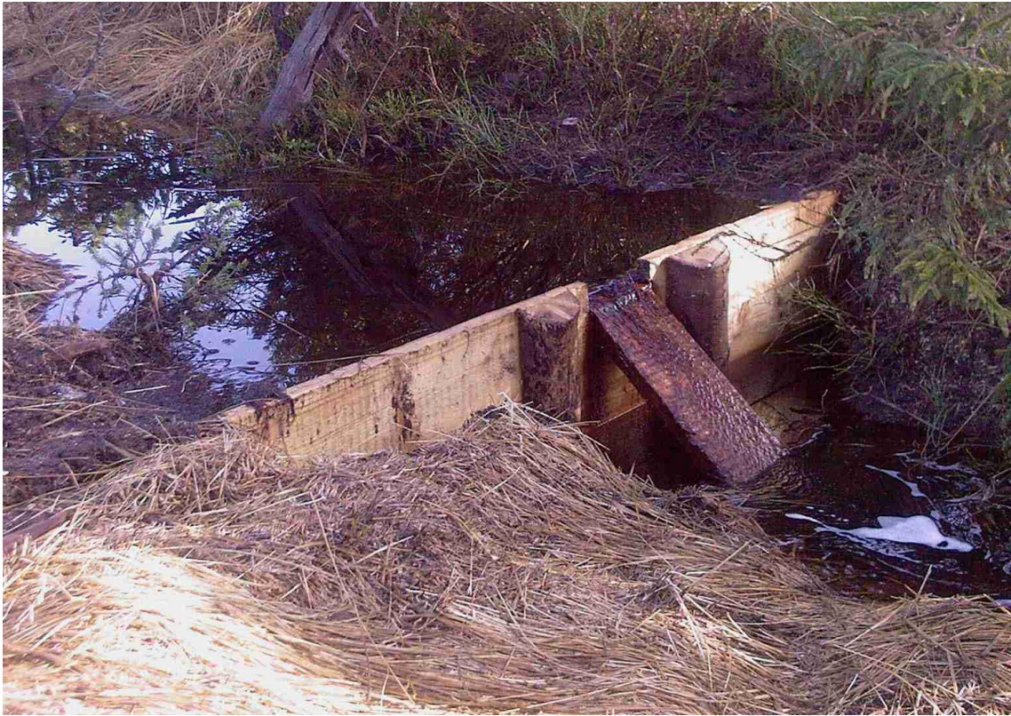
Obrázek 5 – Hradící konstrukce na odvodňovacím kanále na rašeliništi Klugeho louka. [24]
