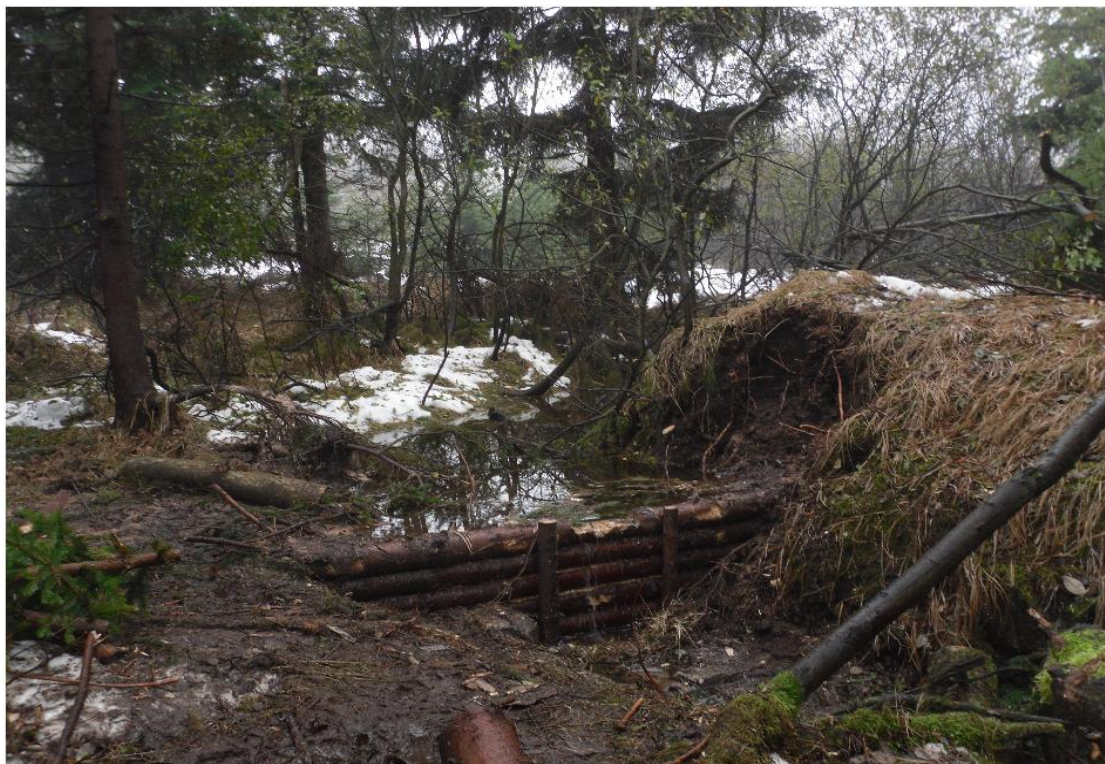
Obrázek 4 – Hradící konstrukce na odvodňovacím kanále na rašeliništi Cínovecký hřbet. [35]
