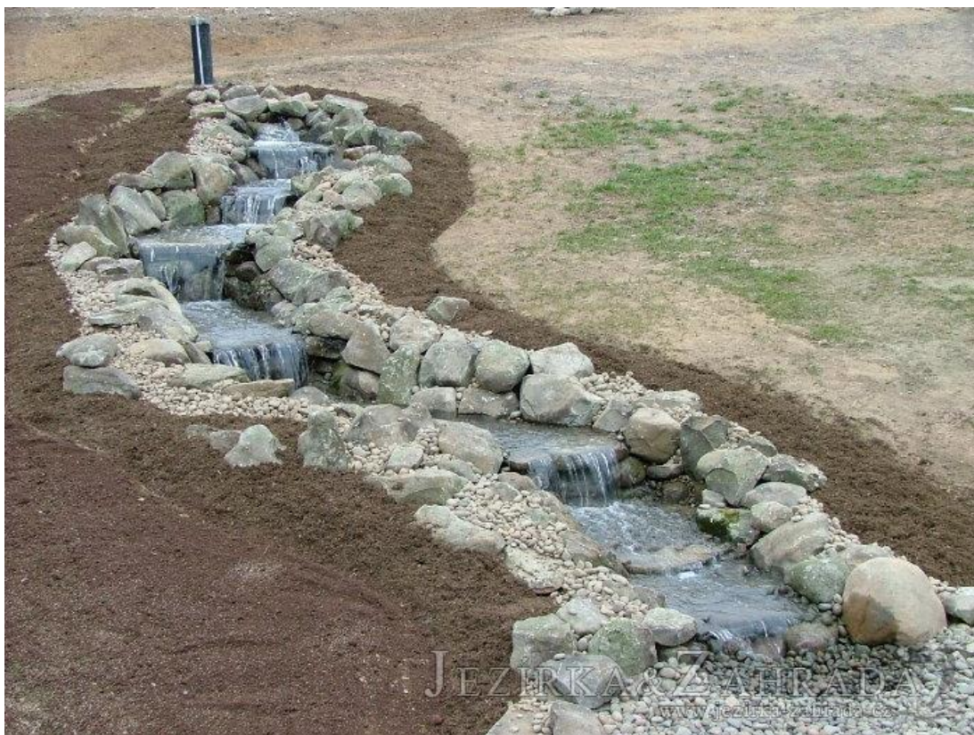
Obr. 9: Zdařilá realizace stavby potůčku (Zdroj: http://www.jezirka-zahrada.cz/admin/img_fotogalerie/holidaymtn.jpg )
