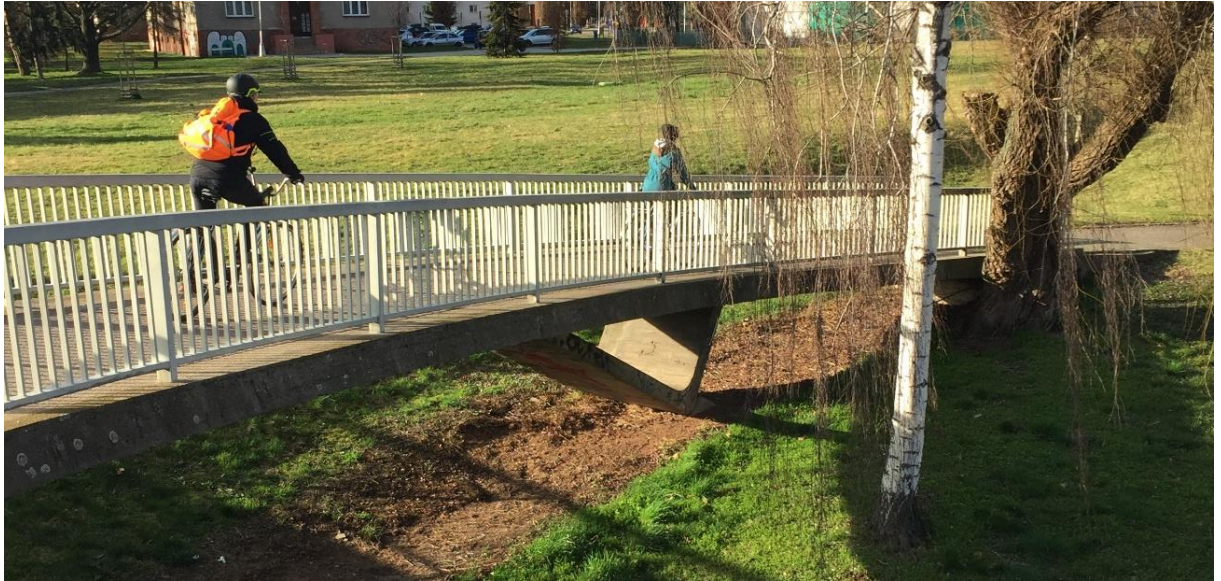
Obr. 38 Lávka spojující přilehlou stezku a mostní objekt
