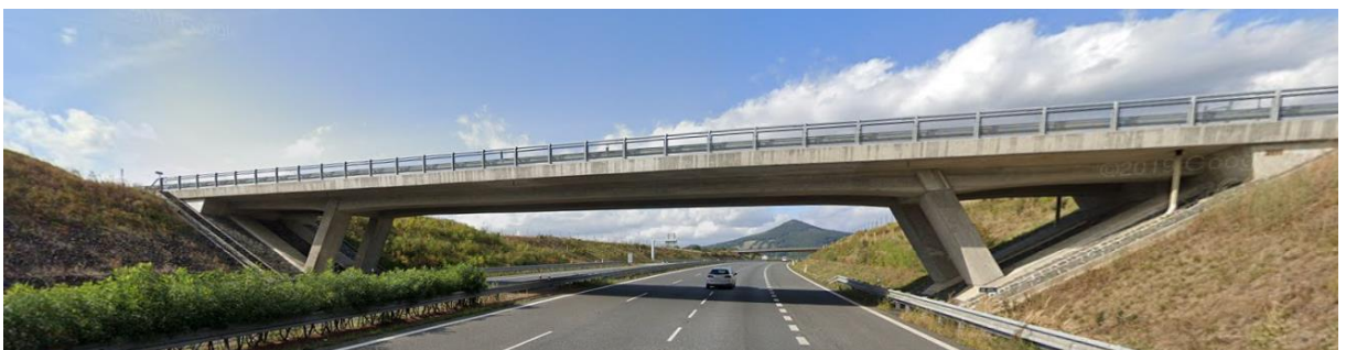
Obr. 39 Pohled na MÚK Bílinka [10]
