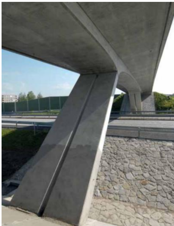
Obr. 40 Šikmé vzpěry z vysokopevnostního betonu [12]
