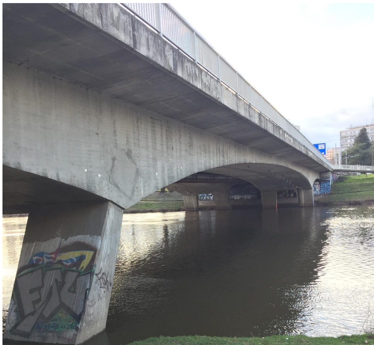
Obr. 37 Pohled na spodní hranu nosné konstrukce a na šikmé vzpěru u mostu U soutoku
