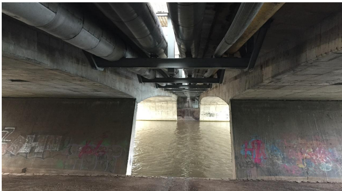
Obr. 33 Pohled na spodní stranu nosné konstrukce a na šikmé vzpěry u Labského mostu
