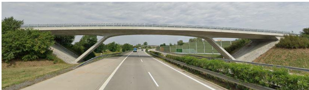
Obr. 41 Nadjezd nad dálnicí D35 v Olomouci-Neředíně [10]
