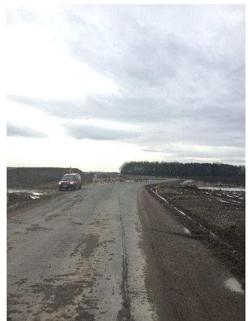
Obr. 3 Přeložka silnice II/298
