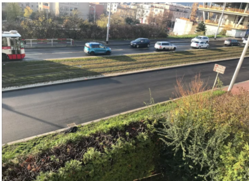
Obr. 11 Ulice Evropská po rekonstrukci [16]
