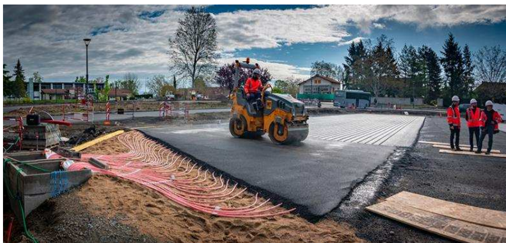
Obrázek 3 - realizace vozovky typu power-road, zdroj: [15]
