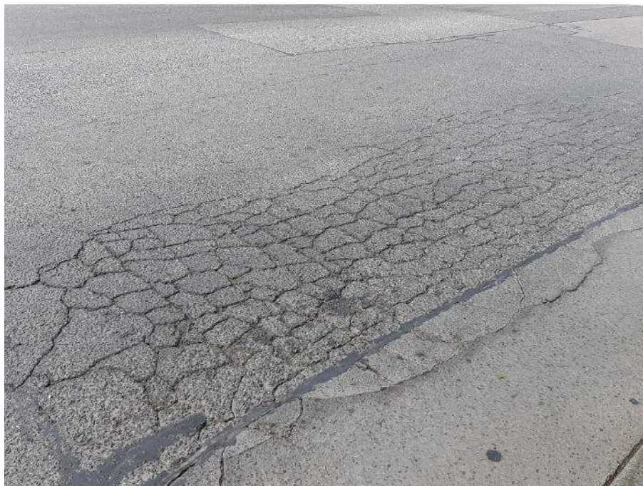
Obrázek 1 - Příklad poruchy vozovky (trhliny), zdroj: archiv autora
