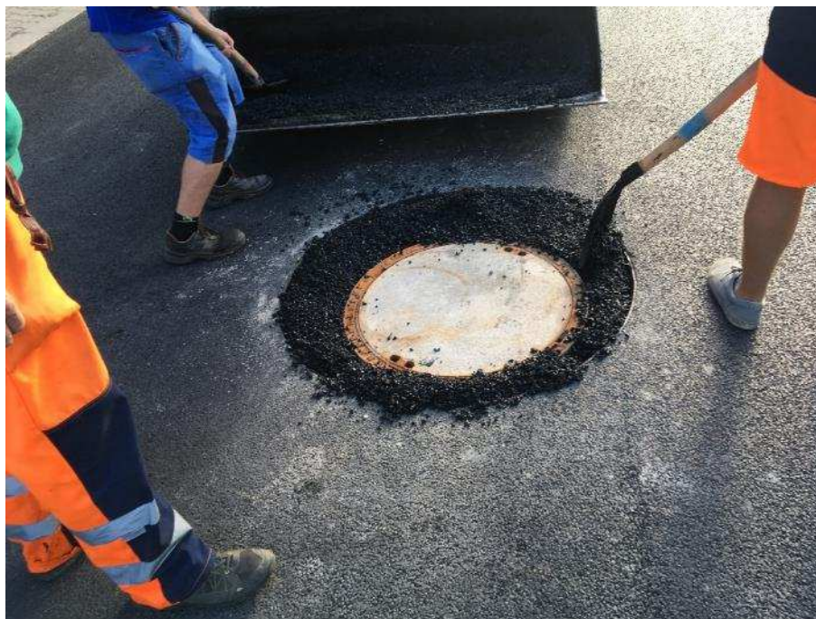
Obrázek 2 - Příklad běžné údržby - rektifikace poklopu, zdroj: archiv autora
