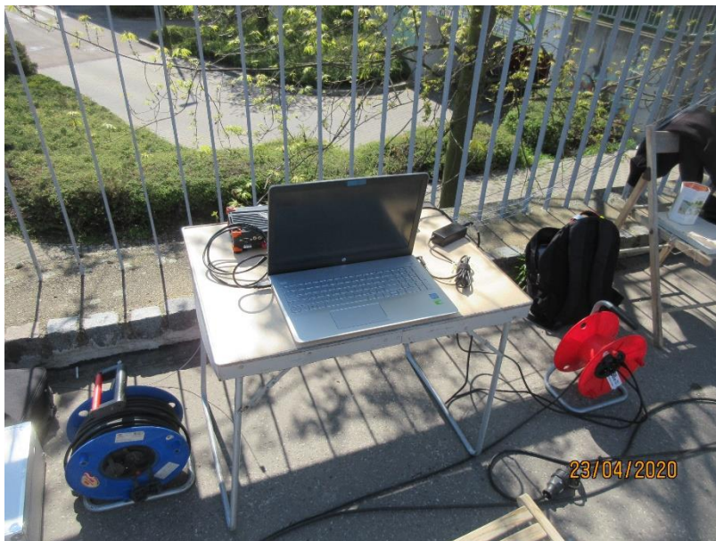
Obr. 016 Provizorní kalibrovaná měřicí linka na lávce X – 528 se softwarem potřebným k vyhodnocování získaných údajů
