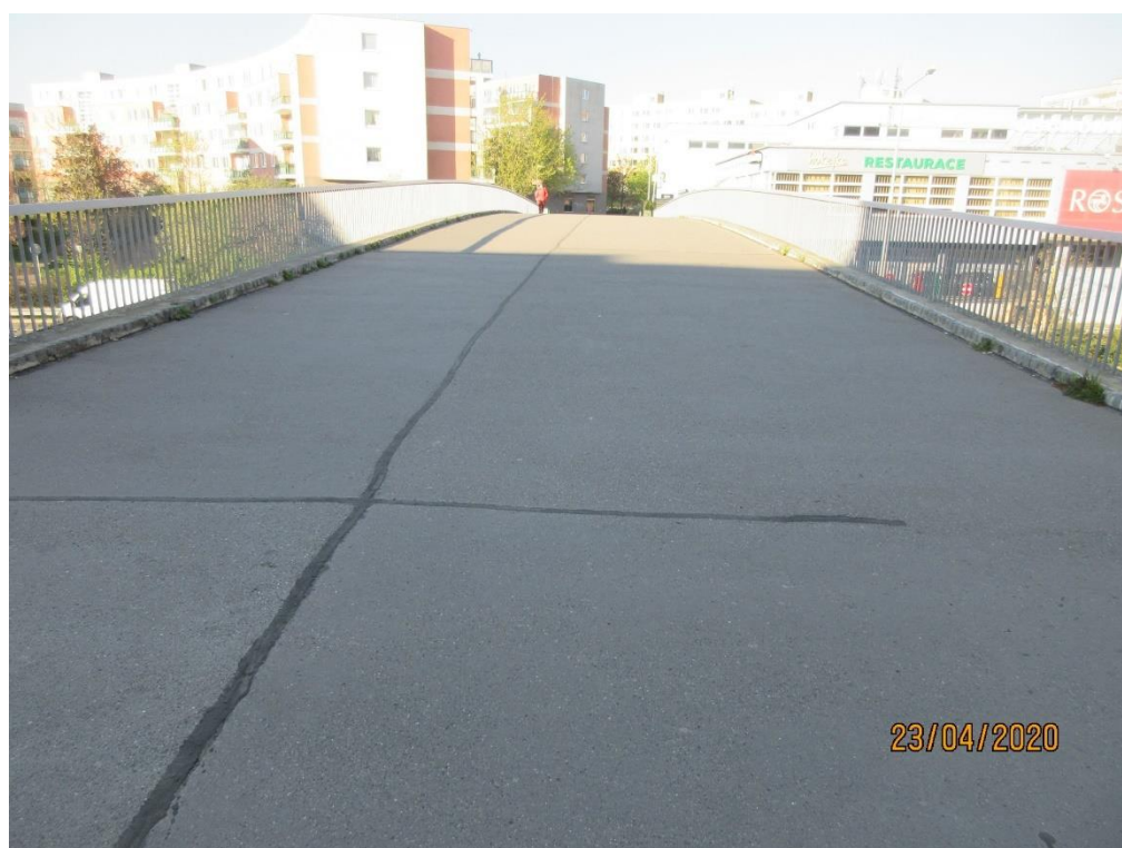
Obr. 012 Stávající situace na lávce X – 528, pohled od Opěry OP04
