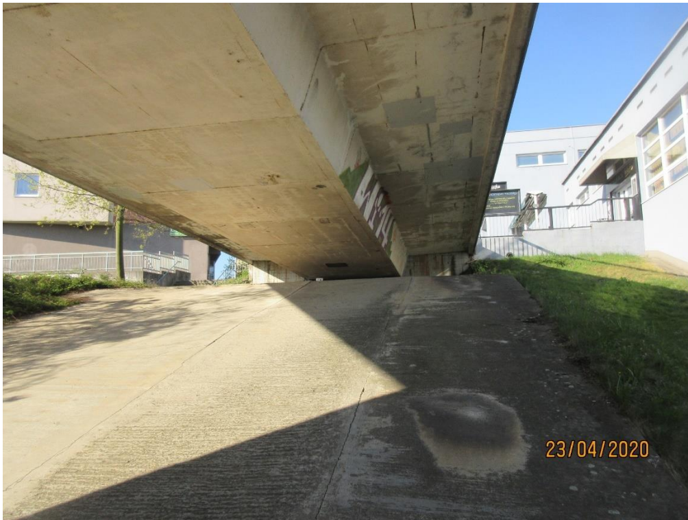
Obr. 004 Pohled na Opěru OP01
