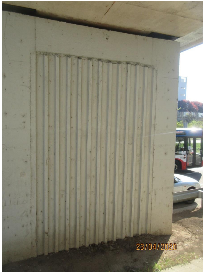
Obr. 007 Pohled na Pilíř P03: detail pohledové úpravy dříku
