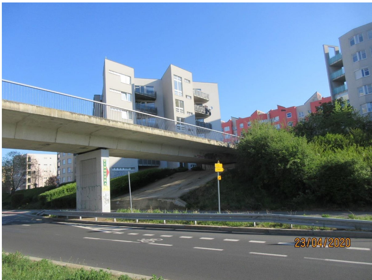
Obr. 002 Boční pohled na pravou stranu lávky X-528: \frac{1}{4} rozpětí hlavního pole lávky, pilíř P03, třetí pole lávky / druhé krajní pole lávky
