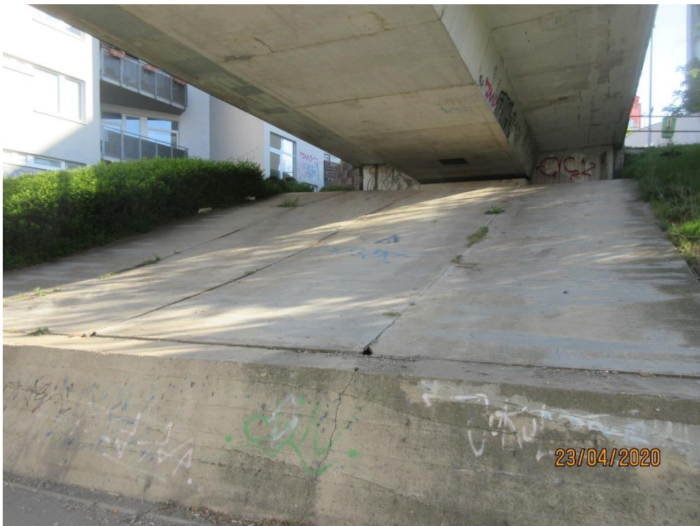
Obr. 005 Pohled na Opěru OP04
