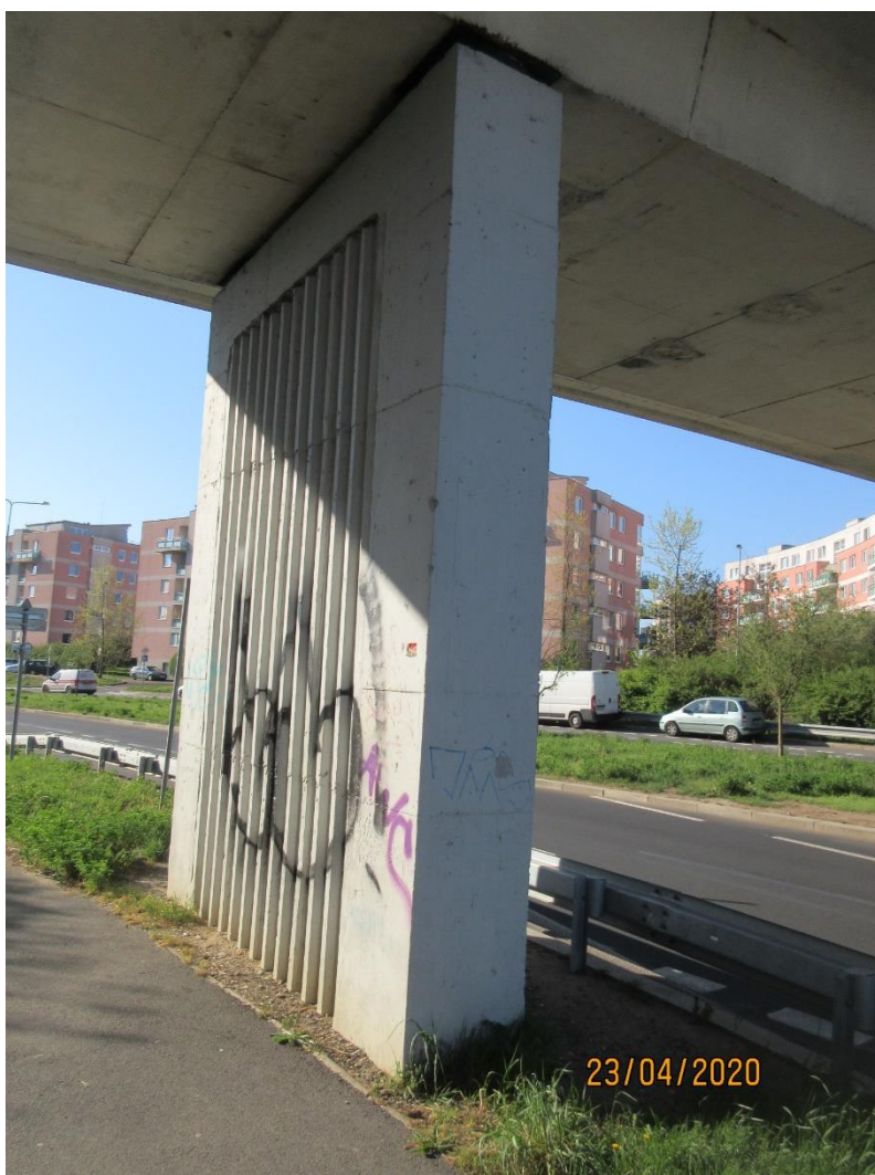
Obr. 006 Pohled na Pilíř P03, levá strana vnitřní podpěry
