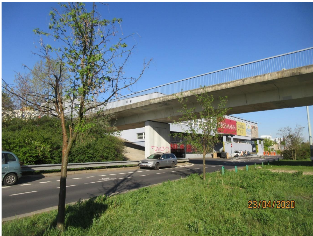
Obr. 001 Boční pohled na pravou stranu lávky X-528: první krajní pole, pilíř P02, \frac{1}{2} rozpětí hlavního pole lávky
