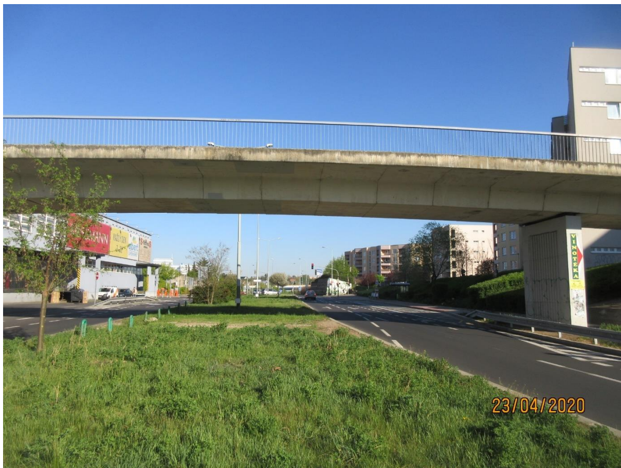
Obr. 003 Boční pohled na pravou stranu lávky X-528: hlavní pole lávky, dopravní situace pod mostním objektem, pilíř P 03
