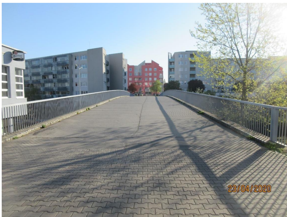
Obr. 011 Stávající situace na lávce X – 528, pohled od Opěry OP01
