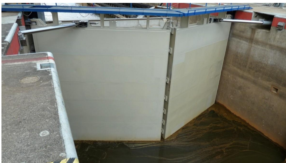
Obrázek 3: Ukázka vzpěrných vrat, VD Roudnice nad Labem[7]
