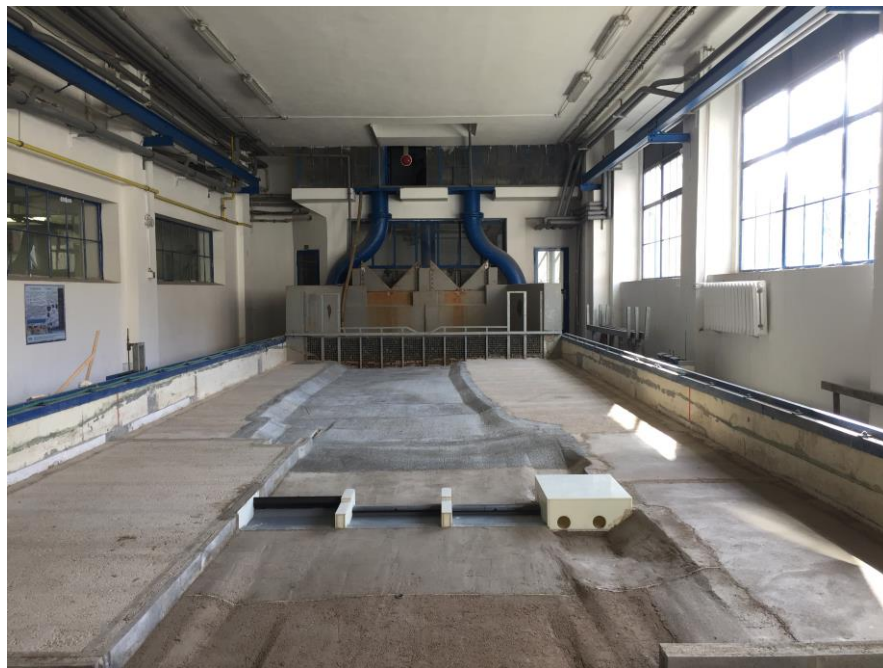
Obrázek 11: Hotová Betonáž včetně natření koryta horní vody cementovou mazaninou.
