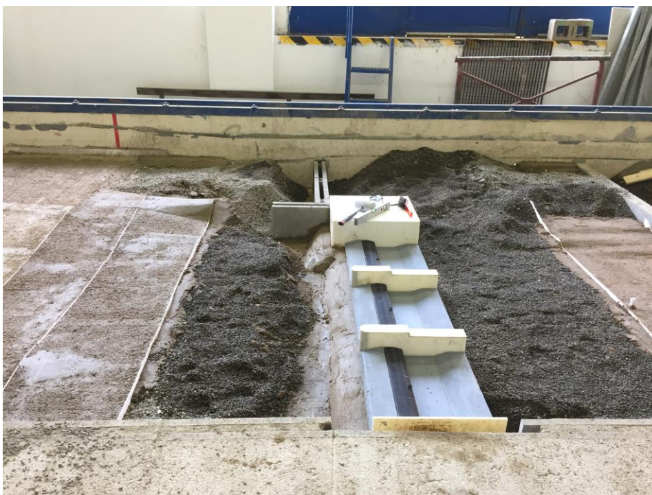
Obrázek 10: Osazení jezu společně s MVE
