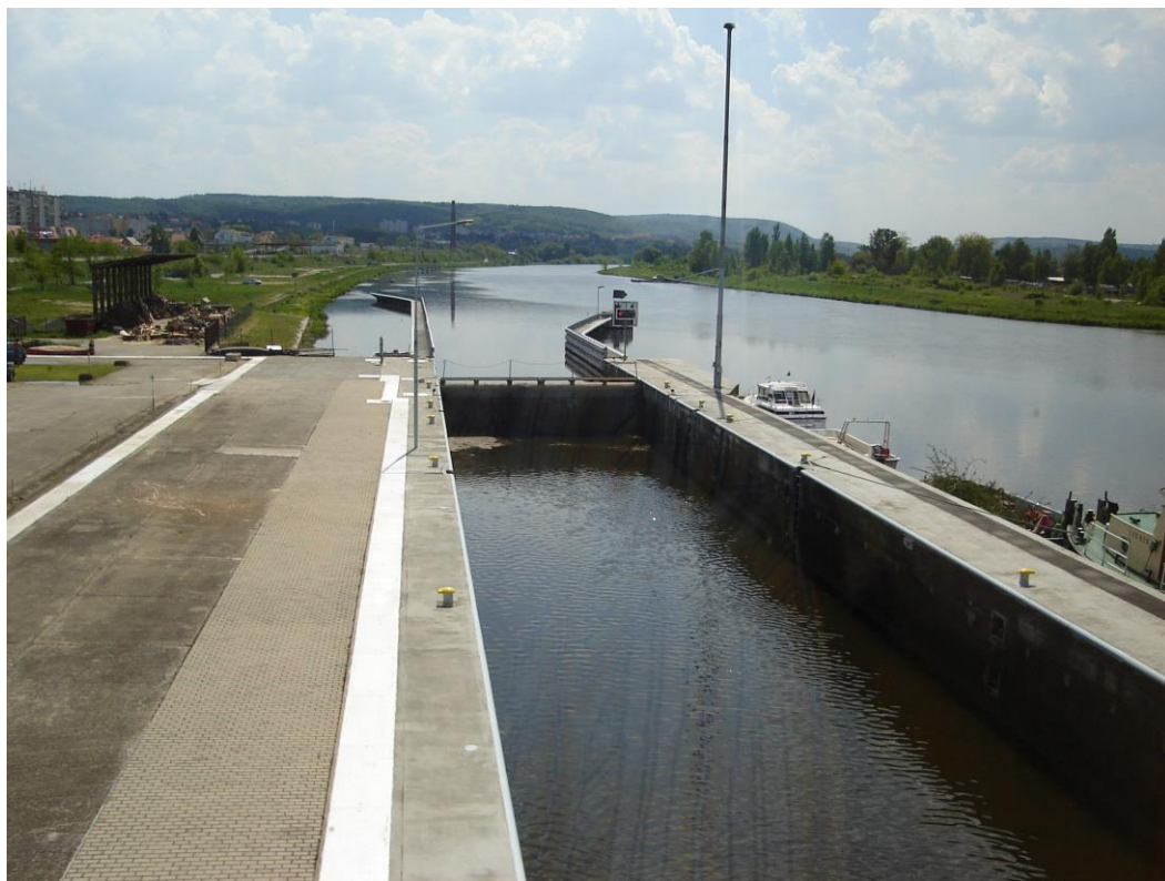
Obrázek 4: Pohled na horní rejdou plavební komory Modřany – Manipulační řád, příloha fotodokumentace [3]
