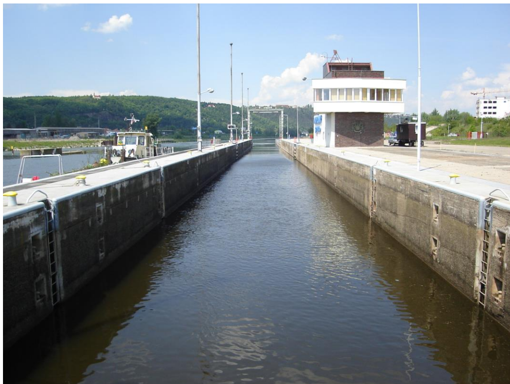
Obrázek 3: Plavební komora Modřany – pohled z vrat horního ohlaví – Manipulační řád, příloha fotodokumentace [3]
