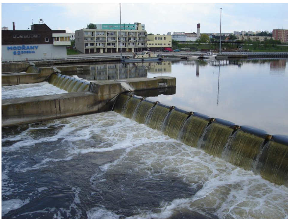
Obrázek 2: Objekt jezu – Manipulační řád, příloha fotodokumentace [3]
