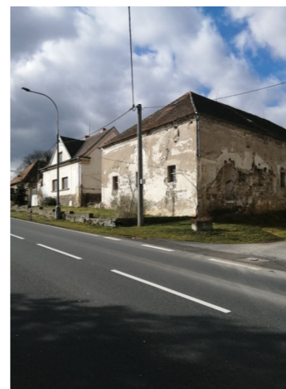
Obrázek 1 - Dvůr je v zanedbaném stavu, a jeho funkce není na první pohled vůbec zřetelná.
