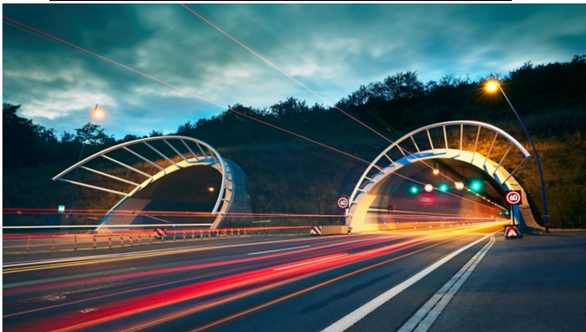
Obrázek č.86: SNÍŽENÍ ENERGETICKÉ NÁROČNOSTI STRAHOVSKÉHO A ZLÍCHOVSKÉHO TUNELU (zdroj: https://www.smartprague.eu/projekty/snizeni-energeticke-narocnosti-strahovskeho-a-zlichovskeho-tunelu )
