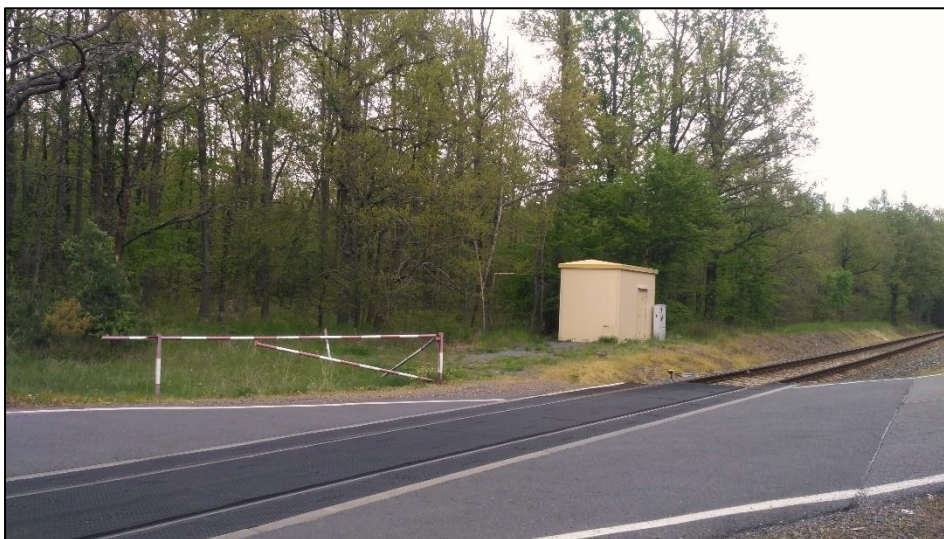
Obr. 51 – budoucí nájezd na trať N 10, foto: autor
