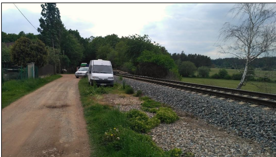
Obr. 69 – budoucí nájezd na trať N 28, foto: autor
