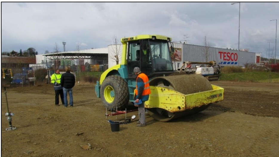
Obr. 6 – Ammann ASC 150 při statické zatěžovací zkoušce, foto: autor
