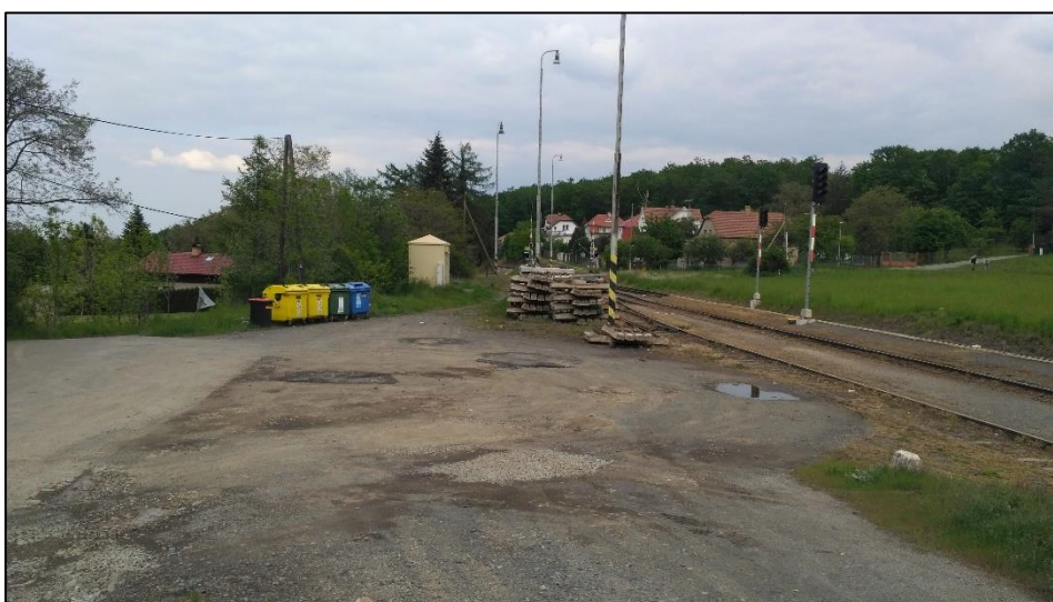
Obr. 41 – plocha, na které bude umístěno zařízení staveniště ZS 10 část II, foto: autor
