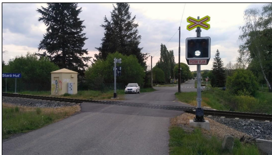
Obr. 43 – nájezd na trať SN 2, foto: autor
