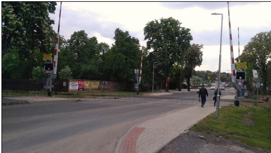
Obr. 42 – nájezd na trať SN 1, foto: autor
