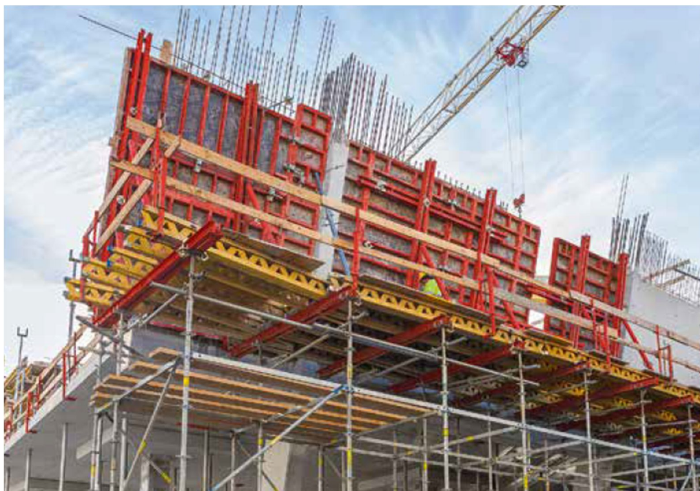
Obrázek 6.14 Bednění šikmé stěny včetně podpěrné konstrukce; Obchodní centrum IGY2 České Budějovice [25]
