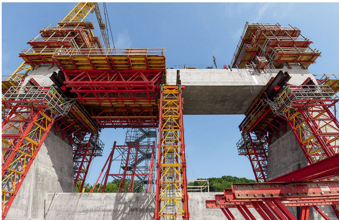
Obrázek 6.25 Podepření pylonů v Ohio pomocí VARIOKIT systému doplněnými modulovým lešením PERI UP ROSETT a šplhavým bedněním. [29]
