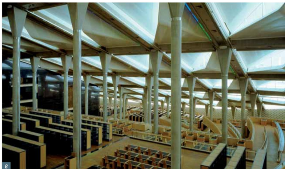
Obrázek 2.9 Šikmá stropní konstrukce galerie egyptské knihovny v Alexandrii [6]
