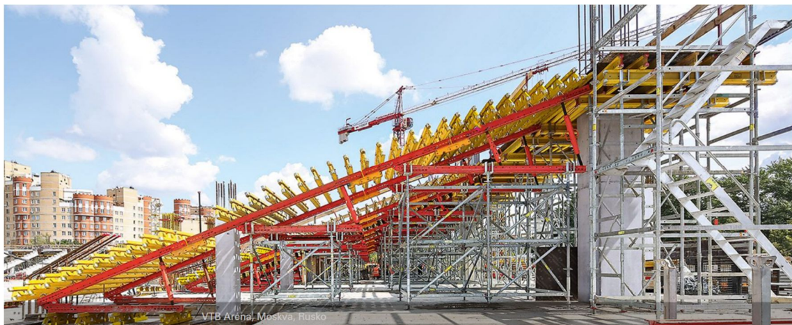
Obrázek 6.24 Bednění tribuny pomocí systému VARIOKIT A PERI UP ROSETT, VTB arény v Moskvě
