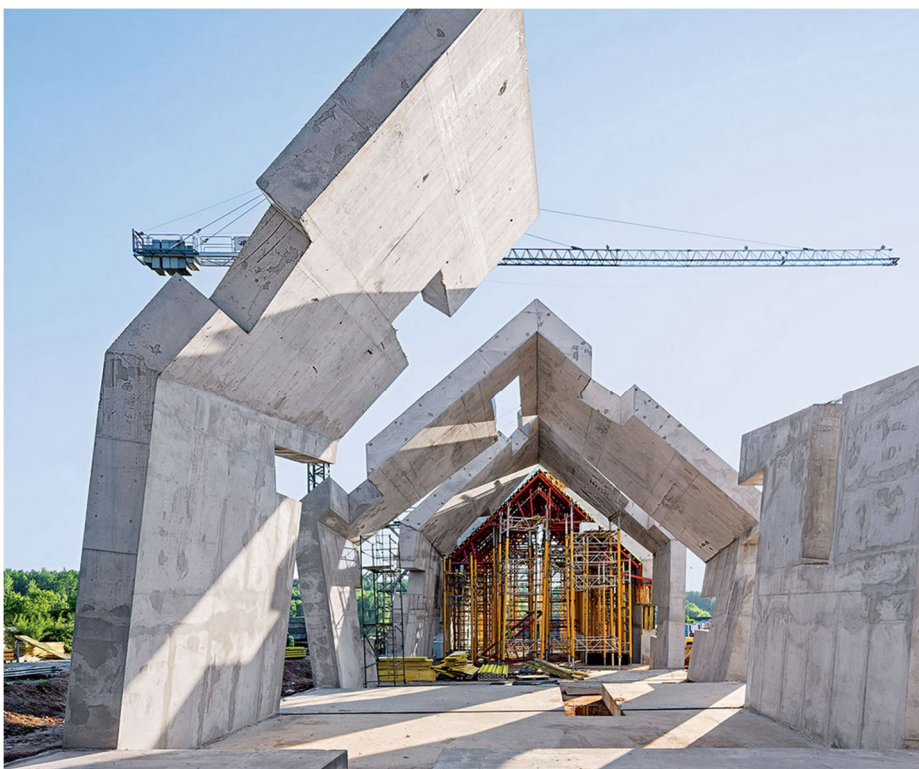
Obrázek 2.11 Atypická stavba připomínající rozpadající chalupu [9]
