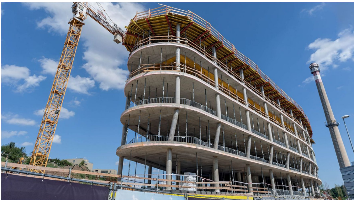
Obrázek 2.6 Administrativní budova Dynamica v Praze se šikmými sloupy [4]
