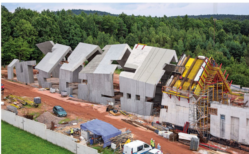
Obrázek 2.12 Pohled na stavbu s bedněním šikmých střešních ploch [9]
