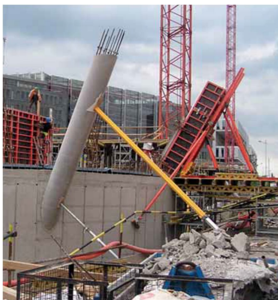
Obrázek 2.1 Šikmý sloup procházející stěnou Main point Karlín, pohled na šikmé bednění a zabetonovaný sloup [1]
