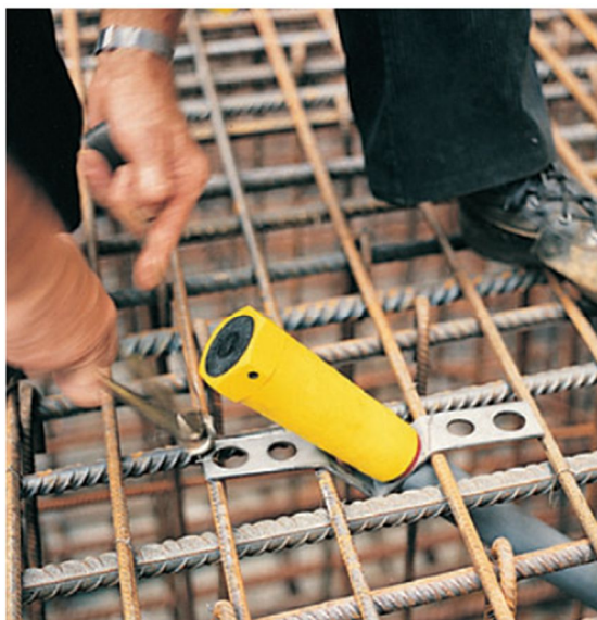
Obrázek 6.8 Uchycení kotevních V držáku k výztuži základové desky a manipulace s montážními kónusy, po sundání montážních kónusu se připojí pomocí šestihránné matice druhá část kotvení [24]
