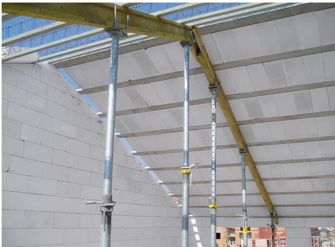
Obrázek 2.15 - Montážní podepření střešní konstrukce Ytong Komfort [11]
