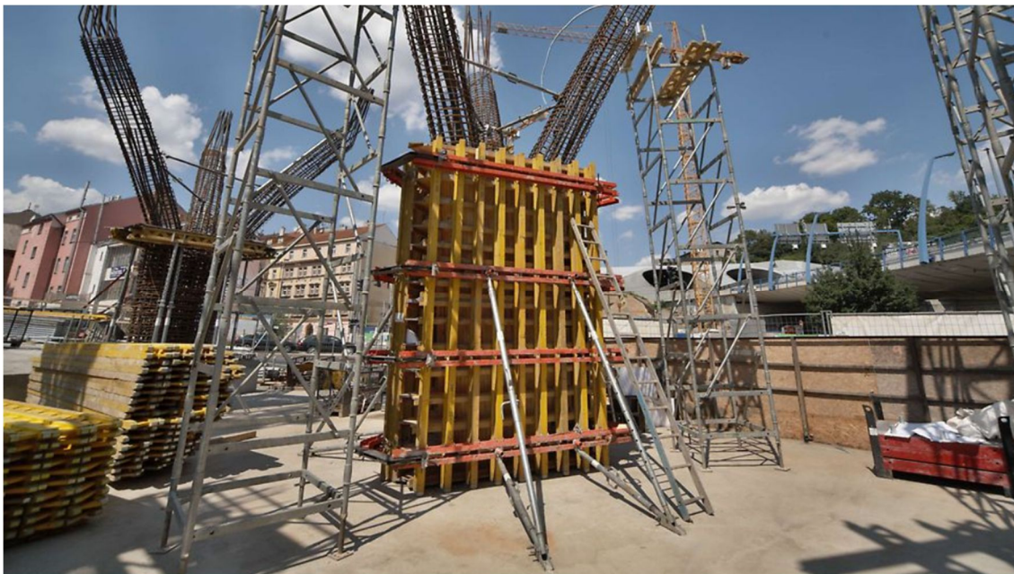
Obrázek 2.5 Nasazení speciálního bednění na společnou část trojsloupů. [3]
