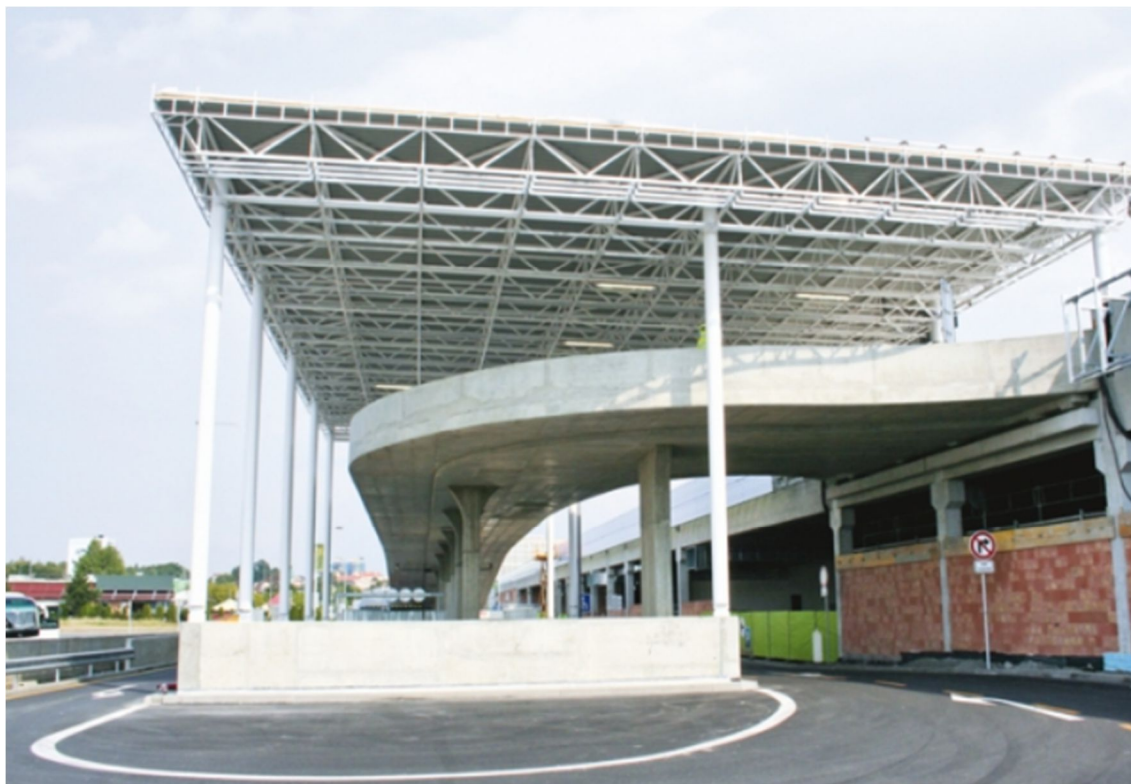
Obrázek 2.17 Severní nadzemní rampa, centrum Černý Most [13]
