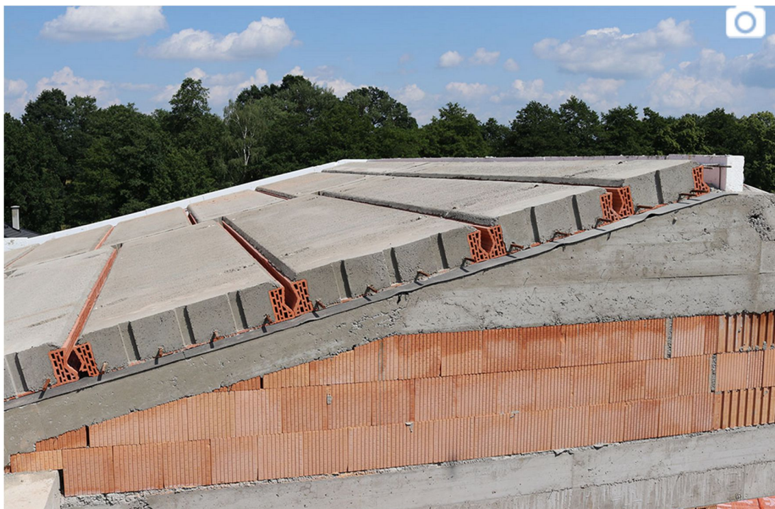
Obrázek 2.13 Řešení sedlové střechy pomocí keramobetonových panelů [10]
