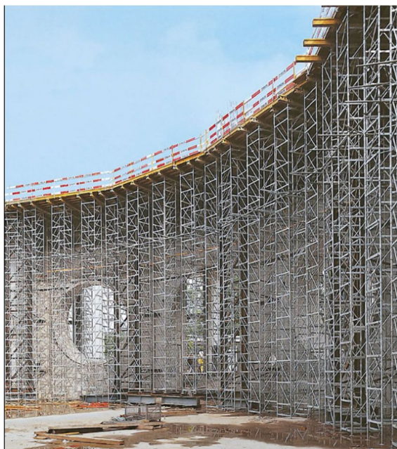
Obrázek 6.21 Stropní bednění vysoké konstrukce řešené pomocí věží ST 100 [26]
