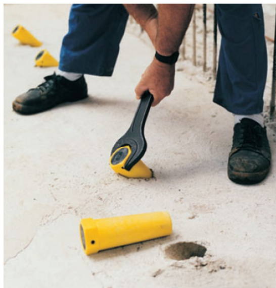
Obrázek 6.8 Uchycení kotevních V držáku k výztuži základové desky a manipulace s montážními kónusy, po sundání montážních kónusu se připojí pomocí šestihránné matice druhá část kotvení [24]
