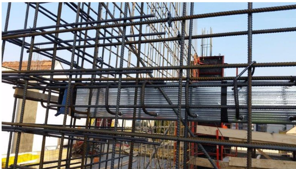
Obrázek 4.3 Vylamovací lišta, připevnění k bedně [16]
