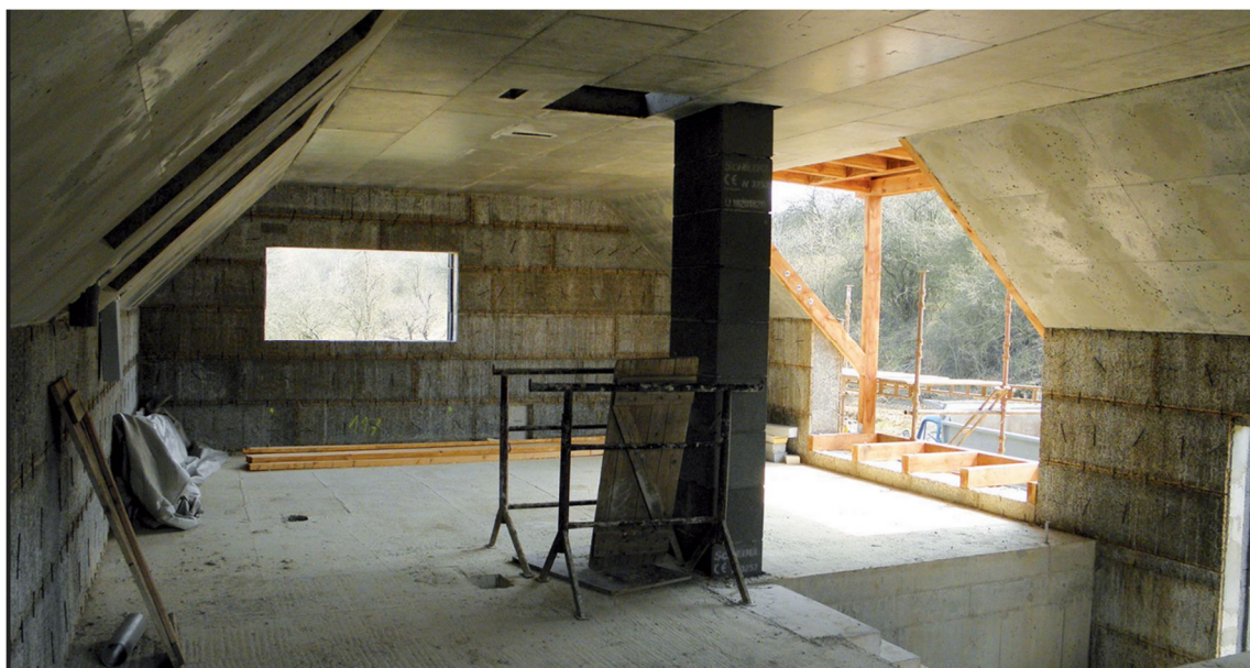
Obrázek 2.10 - Železobetonová střecha rodinného domu v Otvovicích [7]
