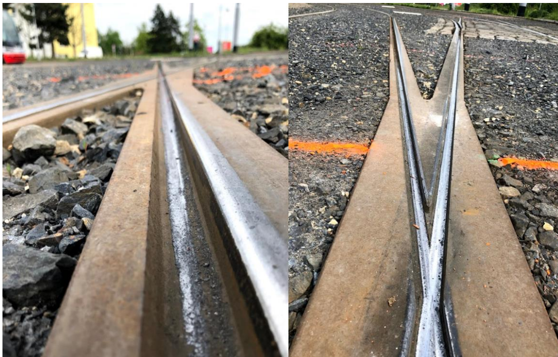
Obr.36-Spojovací č.1 – rozjezdový hrot a náběh žlábků v odbočném směru – konec monitoringu. V levé části obrázku je zobrazen náběh žlábků v odbočném směru. V pravé části obrázku je zobrazen rozjezdový hrot srdcovky.
