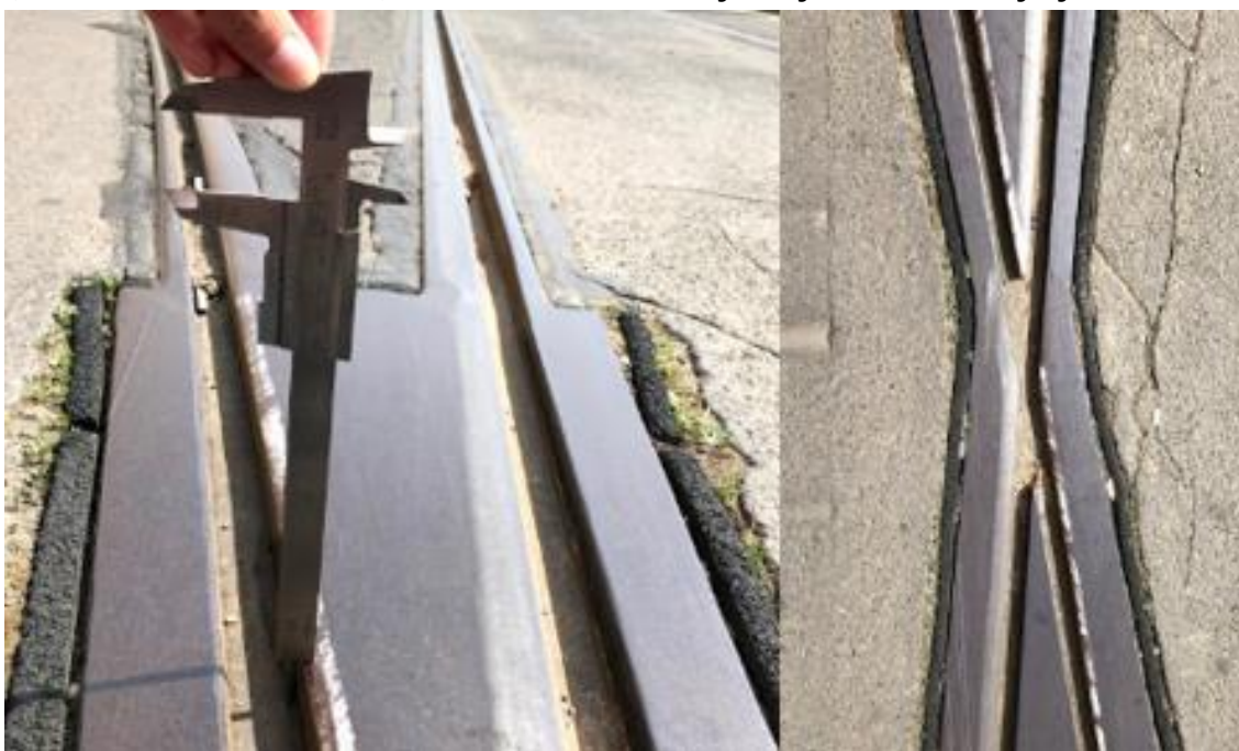
Obr.15-Srdcovka s hlubokým žlábkem (hloubka žlábků měřená posuvným měřítkem činí 25 mm)
