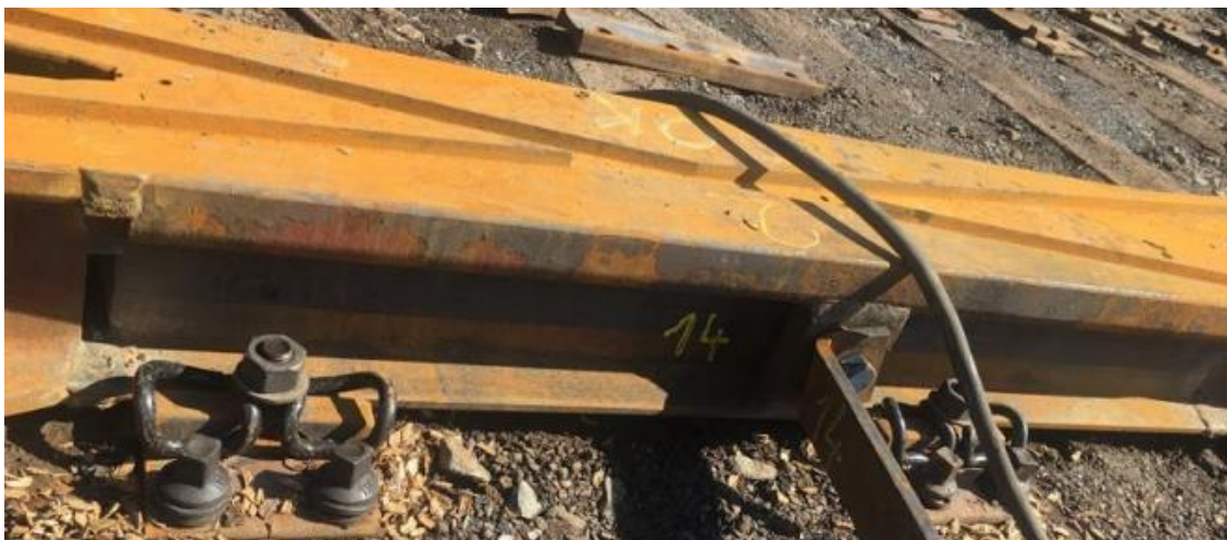
Obr.24-Srdcovka a její upevnění ve druhé rozjezdové výhybce
