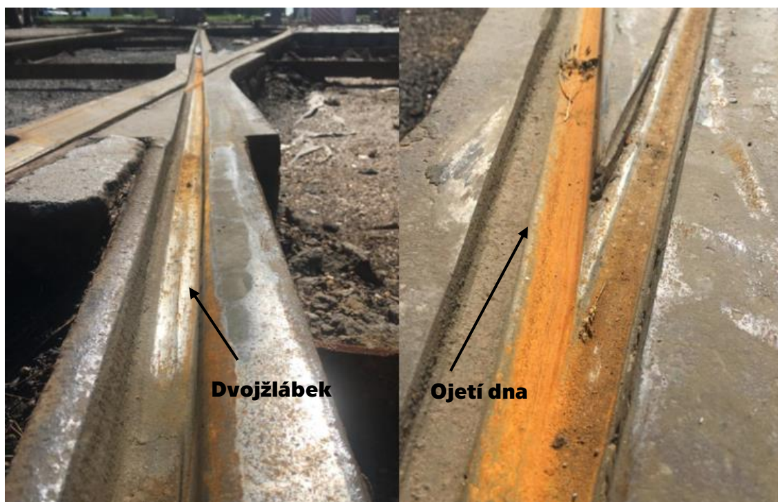
Obr.34-Počáteční stav srdcovky Spojovací č.1 s vyznačeným dvojžlábkem a ojetím dna žlábků
