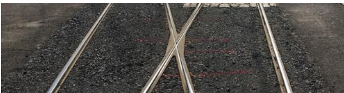
Obr.8-Tramvajová srdcovka
