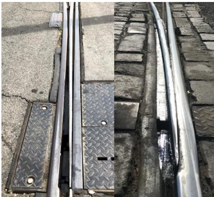
Obr.7-V levé části obrázku je zobrazen pružný jazyk. V pravé části obrázku je zobrazen čepový jazyk.
