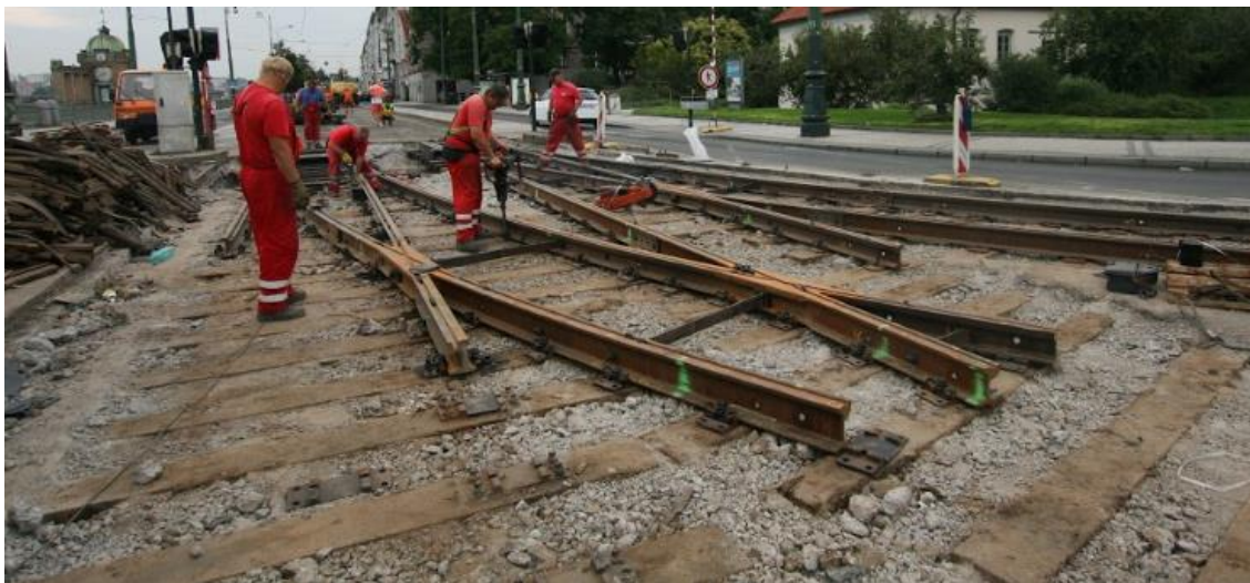
Obr.25-Křižovatka Výtoň během rekonstrukce
