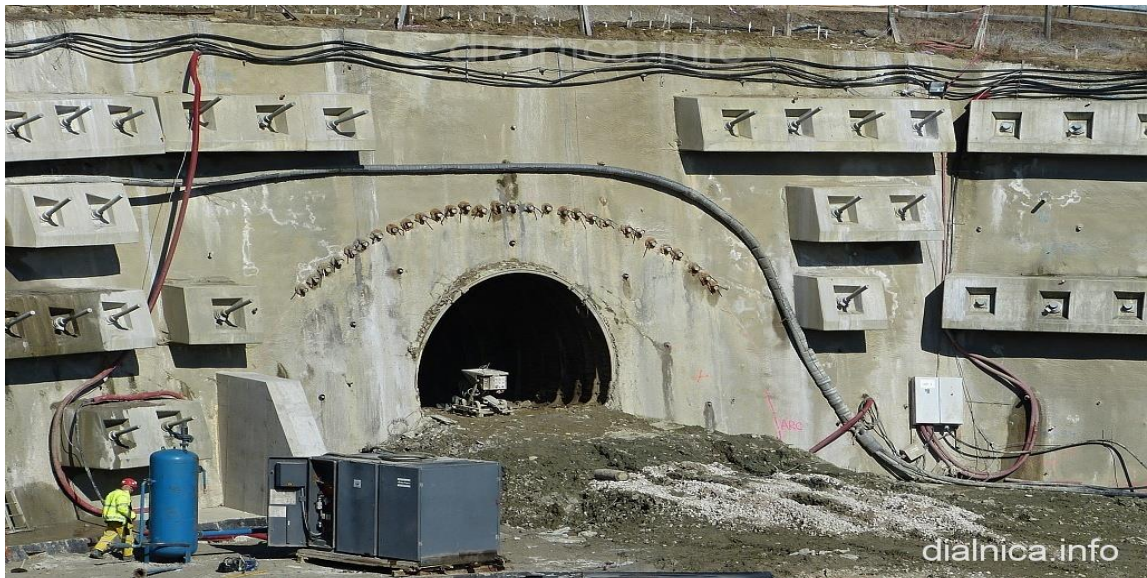
Obr. 13 Pohľad na zrealizovaný MP ochranný dáždnik pred začiatkom razenia tunela [27]
