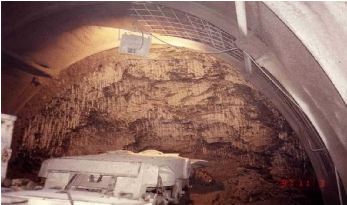
Obr. 18: Pohľad na čelbu a raziaci stroj AM 50 (Alpine) [33]
