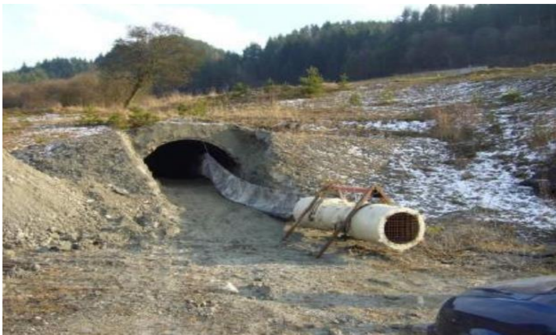
Obr. 20: Západný portál - odčistenie zasypania a odvetrávanie štôlne pred obhliadkou [21]
