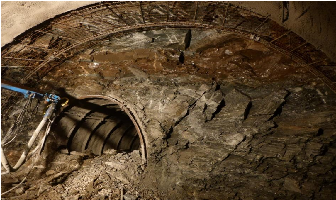
Obr. 17: STR pohľad na čelbu pred nástrekom striekaného betónu - možnosť vidieť prvky vstrojenia [31]
