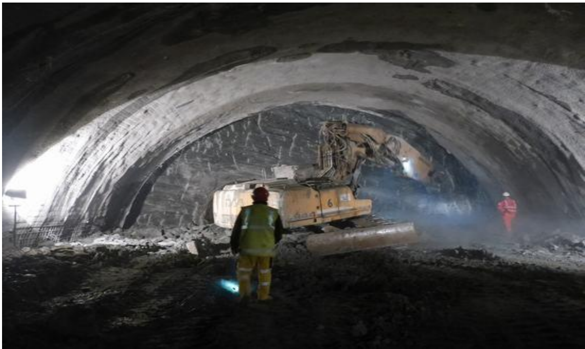
Obr. 15: Severná tunelová rúra - ražba kaloty [29]
