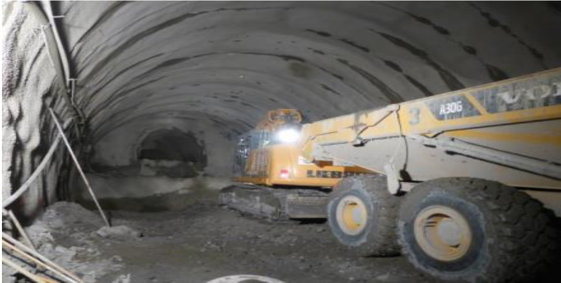
Obr. 16: Nakladanie rúbaniny pomocou tunelbagra z oblasti dna [30]
