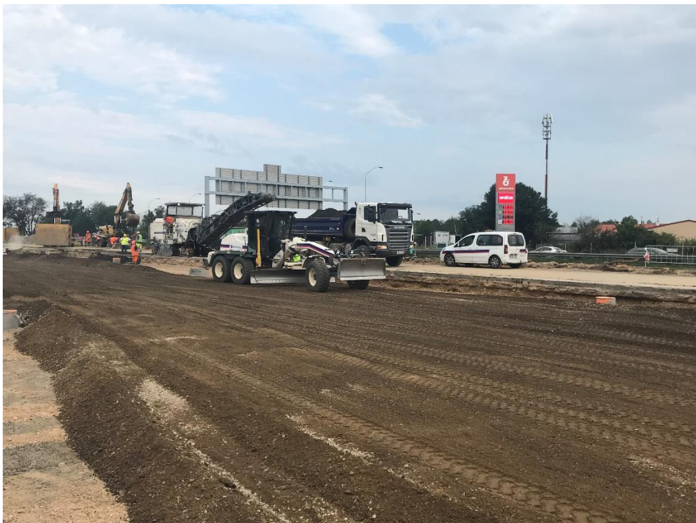
Obr. 28: Pohled na staveniště a stavební stroje (Zdroj: vlastní)
