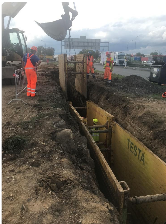
Obr. 30: Ukládání pažení (Zdroj: vlastní)
