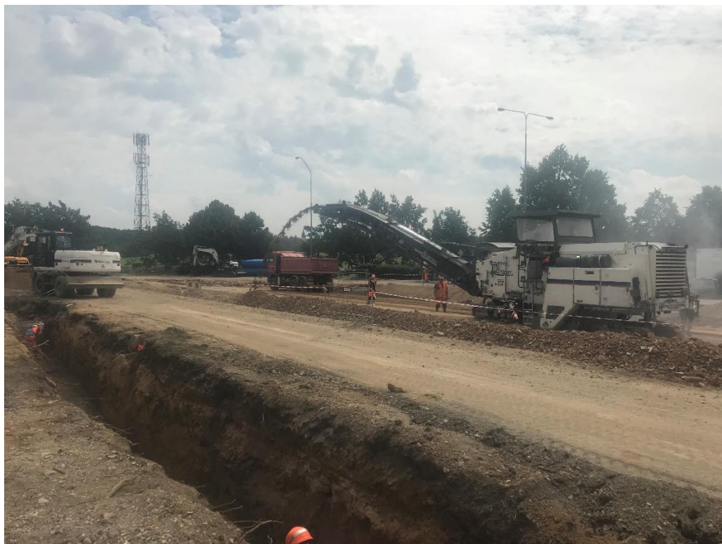
Obr. 29: Pohled na staveniště a stavební stroje (Zdroj: vlastní)
