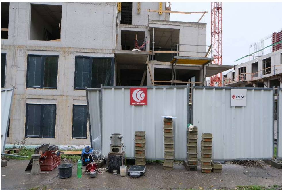
Obrázek 24: Stanoviště měření přímo na stavbě.
