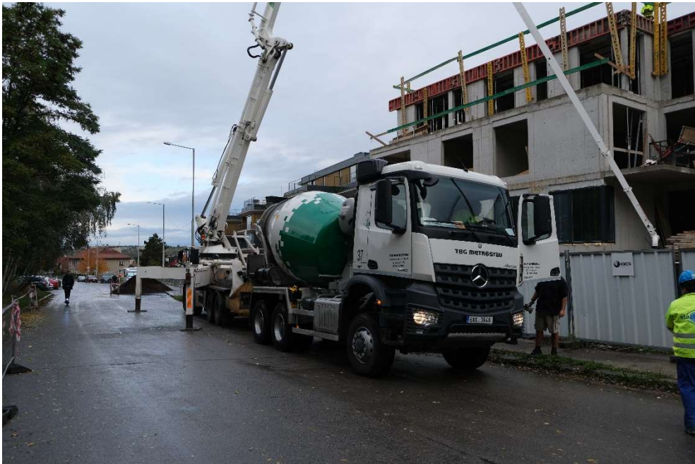
Obrázek 23: Autodomíchávač na stavbě s čerpadlem v pozadí.
