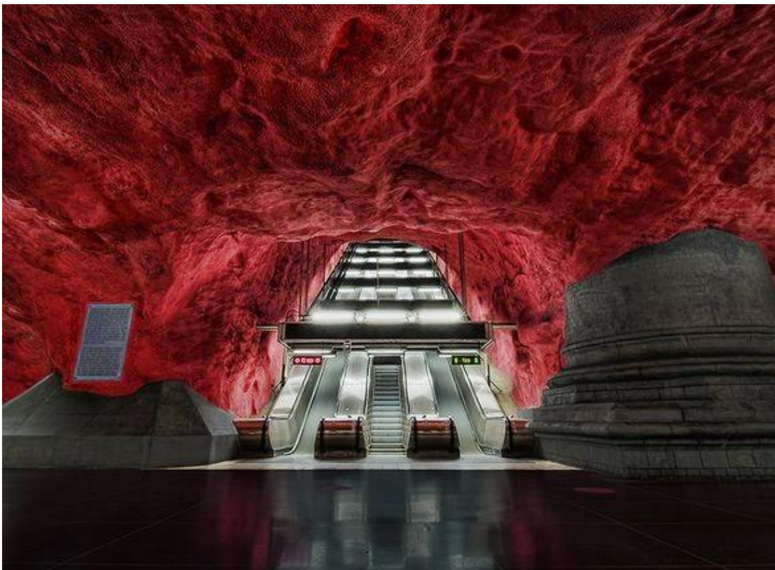
Obr. 24 Metro ve Stockholmu – použití vláknobetonu [9]
