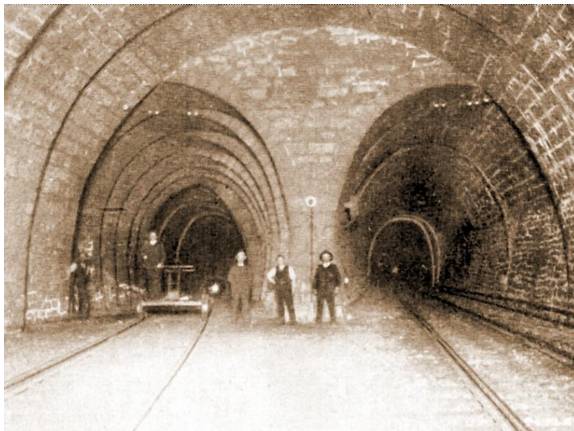
Obr. 4 Ostění z opracovaného lomového kamene v Simplonském tunelu [7]
