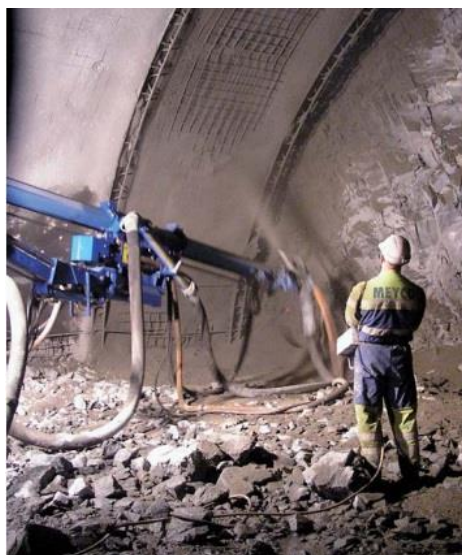
Obr. 20 Kombinace betonu s ocelovými sítěmi [8] Obr.21 Nároky na počáteční pevnost betonu [6]
