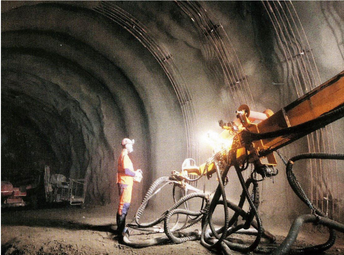
Obr. 25 Dokončená a ještě nezastříkaná výztužná žebra [6]
