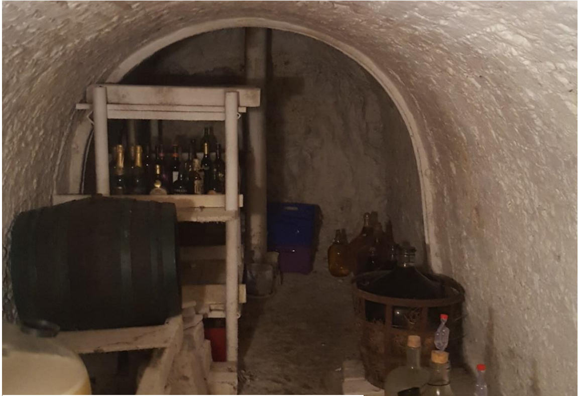
Obr. 9 Vinný sklep s korýtkovou důlní výztuží [Foto autor]
