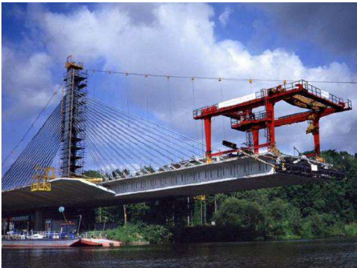
Obrázek 3.7: Letmo betonovaný zavěšený most [4].
