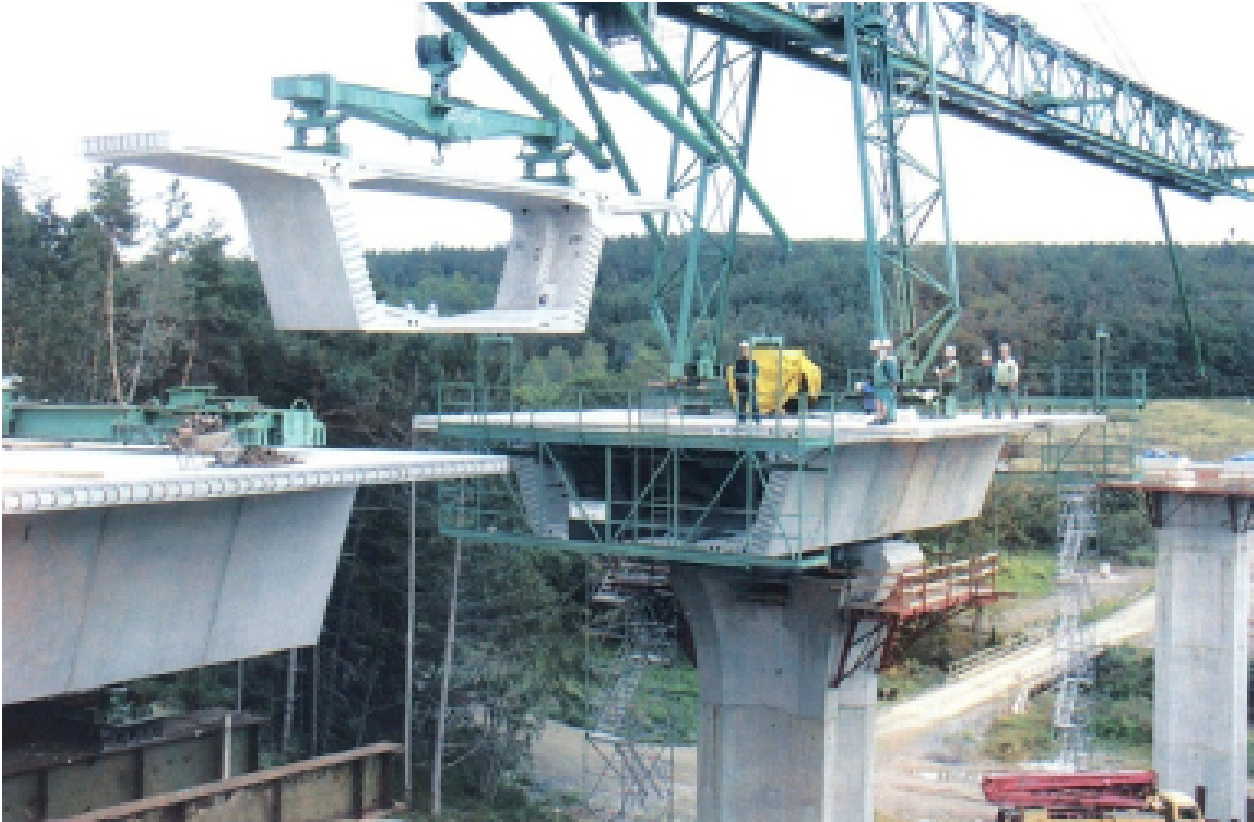
Obrázek 3.8: Foto z letmé montáže [2].
