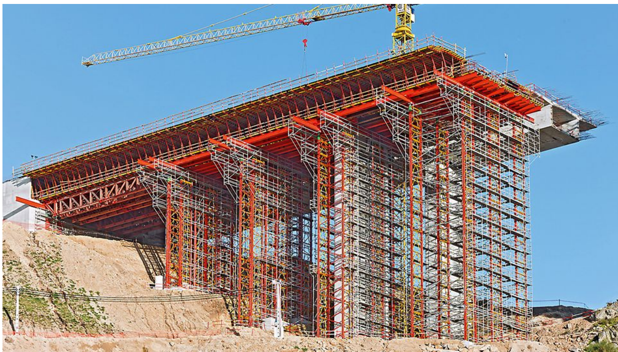
Obrázek 6.1: Pevná skruž dálničního mostu přes Rio Sordo [19].
