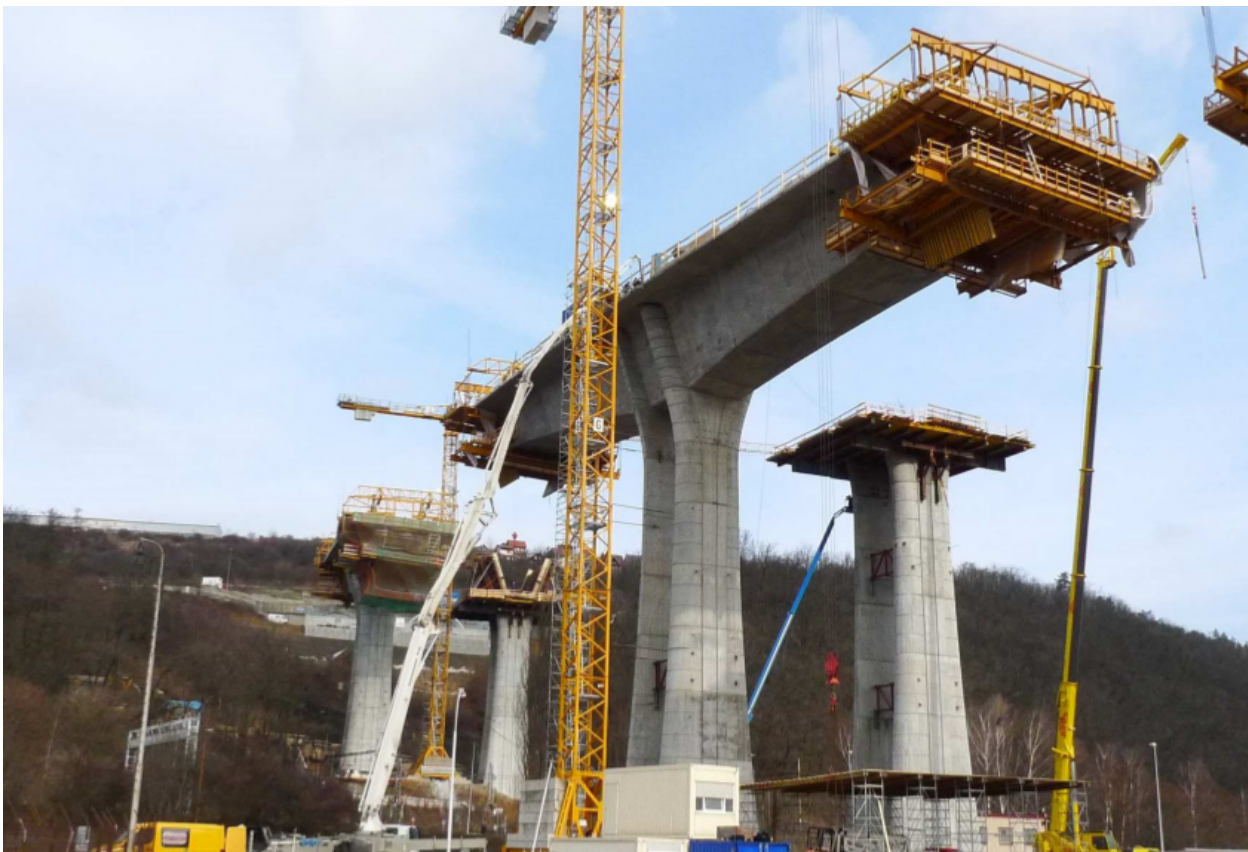
Obrázek 3.1: Zárodek s lamelami a betonážním vozíkem [5].
