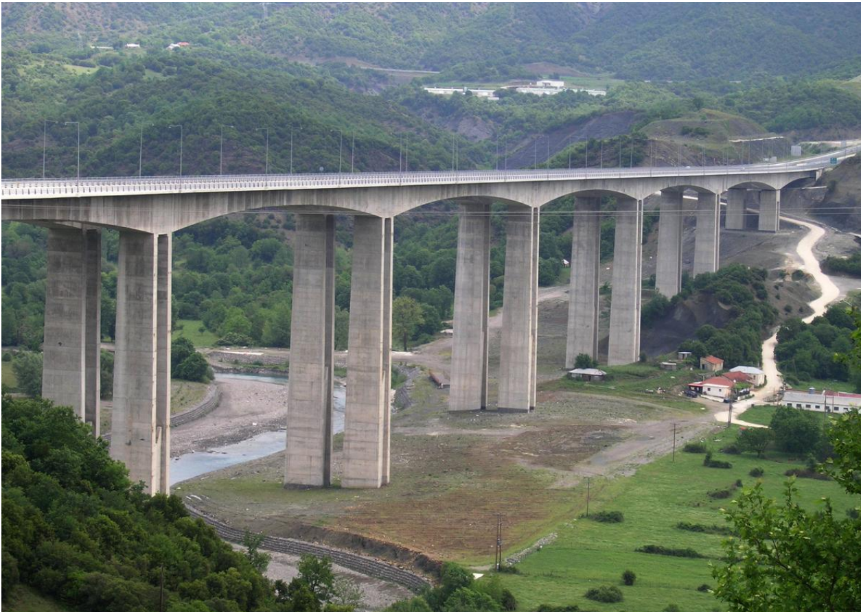
Obrázek 3.4: Dokončený most - Arachthos Bridge, Řecko [20].
