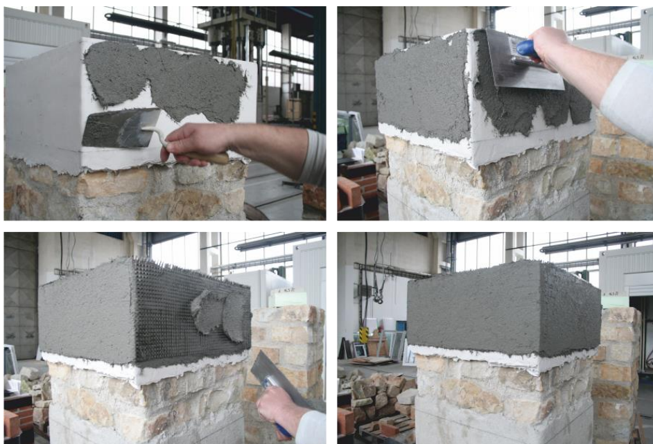
Obrázek 29: provedení technologie TRM v případě kamenného pilíře P_K 18.
