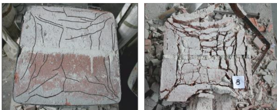
Obrázek 55: Průřez ve střední třetině výšky pilíře P54b a P55 (8. ložná spára shora). Charakteristický průběh trhlin po průřezu.
