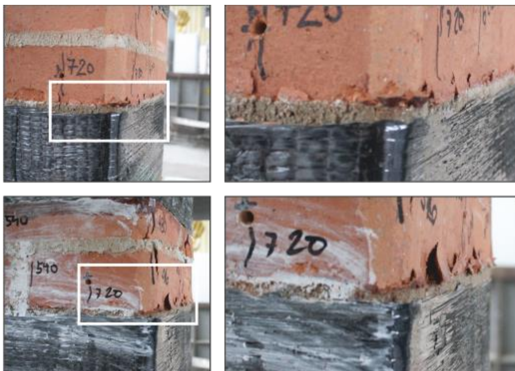
Obrázek 72: Porušování kontaktní spáry na rozhraní "kompozit - zdivo" v blízkosti CFRP pásu.
