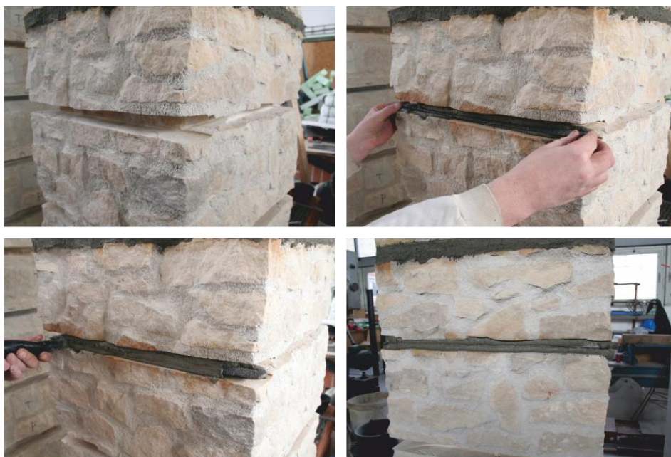
Obrázek 28: Provedení NSM v případě kamenného pilíře P_K 13.
