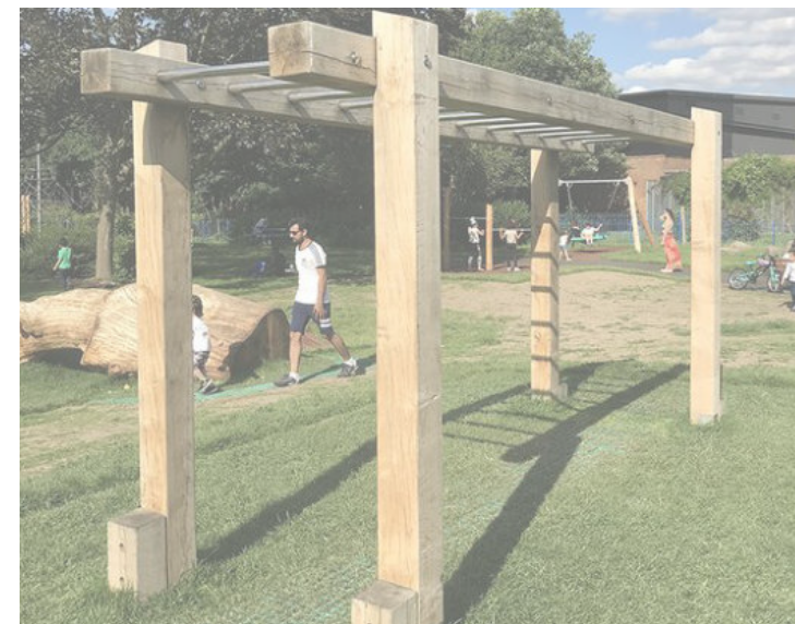
7. Ručkovadlo, OPO4 Floraservis, dřevěná konstrukce
