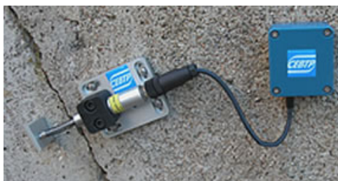
Obrázek 2.7: Monitorování trhliny pomocí senzoru a dataloggeru[7]
