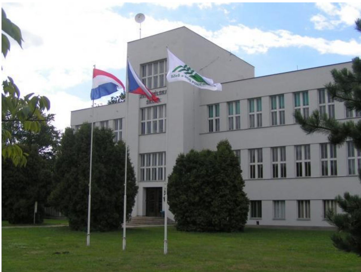
Obrázek 1 - Hlavní budova SZŠ a SOŠ [5]
