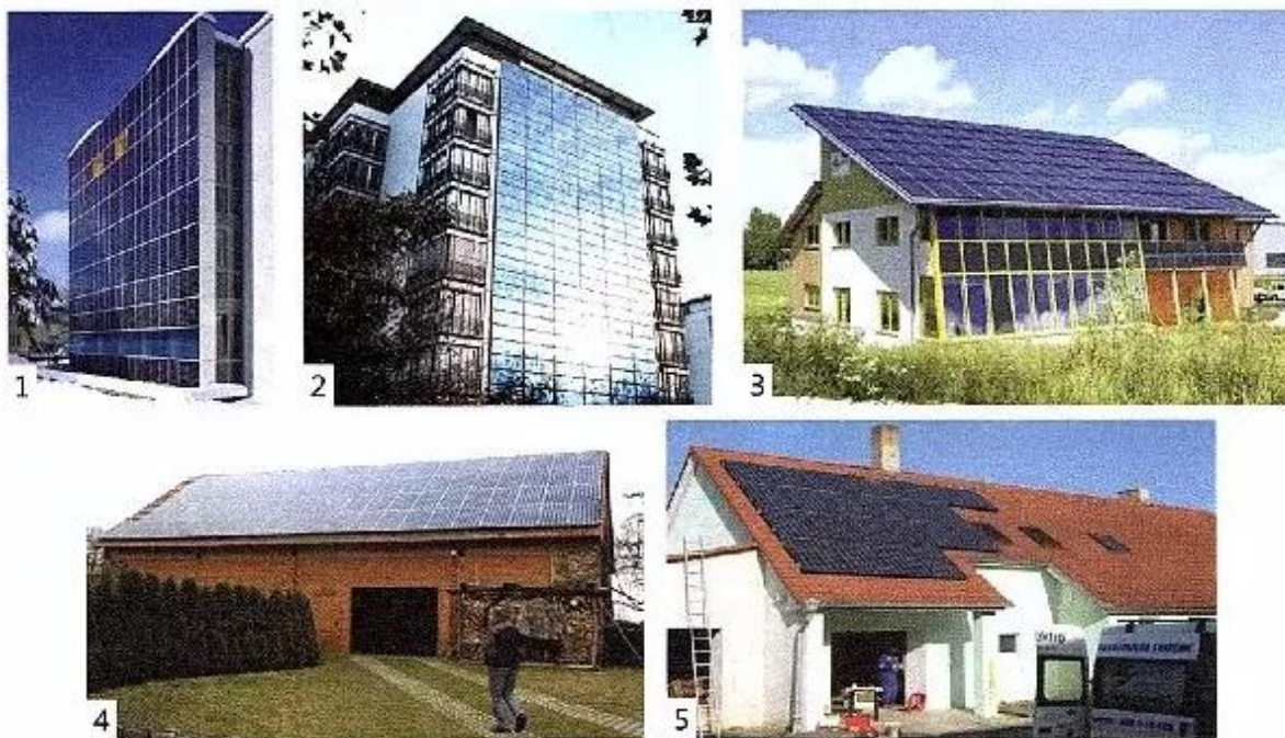
Obrázek 27 - Příklady využití fotovoltaických polí s větranou dutinou [11]
