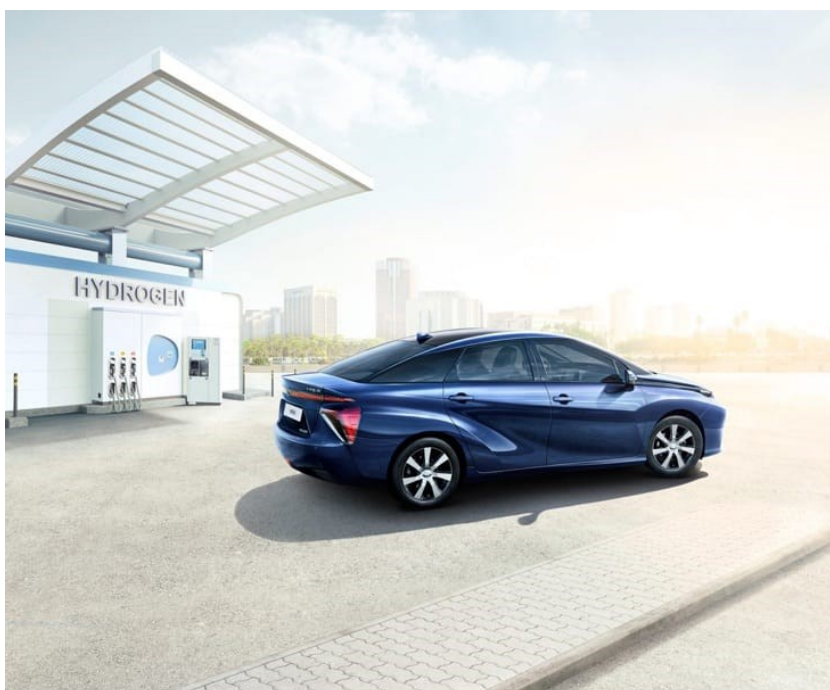
Obr. 34 - Vodíková čerpací stanice [50]
