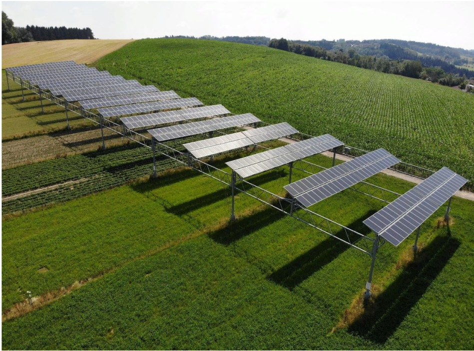
Obr. 20 -FVE na konstrukce - AVP Resola [21]
