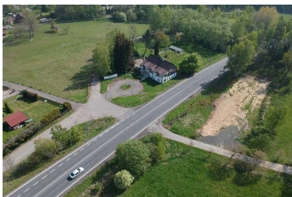
Obrázek 10 - Nevhodně umístěné sjezdy na silnici I/13 (zdroj: vlastní fotodokumentace)
