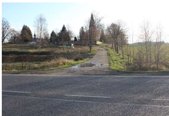
Obrázek 11 - Sjezd ke hřbitovu (zdroj: vlastní fotodokumentace)
