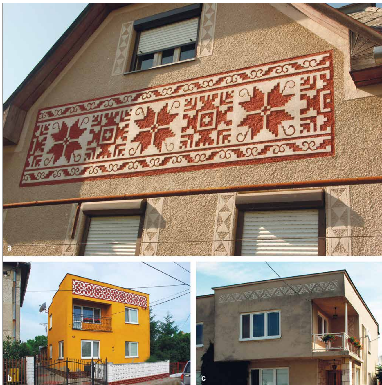
Obr. 21. Vlysy s motívom ľudovej výšivky: a – Brehov (okr. Trebišov), č. 81, starší dom s fasádou upravovanou okolo roku 1980 (foto autor 2019); b – Malé Raškovce (okr. Michalovce), č. 47 (foto autor 2018); c – Zemplínska Nová Ves-Úpor (okr. Trebišov), č. 173 (foto autor 2015).
