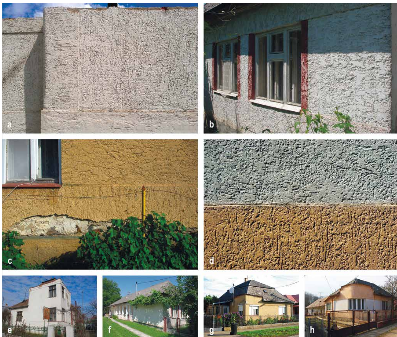
Obr. 4. Prihľadovaná omietka s ťahaným štrkovým zrnom: a, e – Michalovce, ul. A. Kmeťa č. 7/2082, vilka z 30. rokov (foto autor 2018, celkový záber 2013); b, f – Záhор (okr. Sobrance), č. 42, dom z r. 1948, uličná a dvorová fasáda (foto autor 2017); c, g – Oborín (okr. Michalovce), č. 42, dom z r. 1961 – 1962 (foto autor 2017); d, h – Ižkovce (okr. Michalovce), č. 30, dom pribl. z r. 1960 (foto autor 2016, celkový záber 2018);
