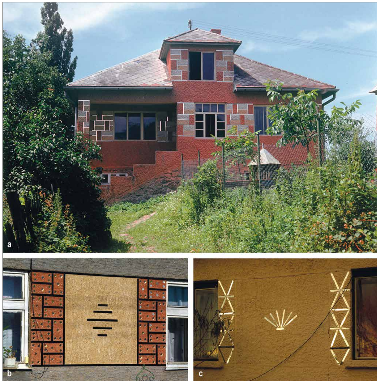
Obr. 11. Medziokenné pásy zdobené kúskami rezaného i črepového zrkadla: a – Zámutov (okr. Vranov n/Topľou), dvojtraktový dom, „štvorec“ stavaný okolo r. 1970 (foto J. Ušiak 1973, archív ÚEt SAV Bratislava, č. diapozitívu AD017941); b – Strážne (okr. Trebišov), č. 131 (foto autor 2018); c – Vyšný Hrušov (okr. Humenné), č. 50 (foto autor 2018); d, e, f – Falkušovce (okr. Michalovce), č. 154, detail okennej šambrány, výklenku v priečelí a lem horizontálnych pásov na dome stavanom v r. 1965 – 1966 (foto autor 2018); g, h – Lekárovce (okr. Sobrance), č. 377, šambrány zádveria a okna (foto autor 2018), i – Veľké Raškovce (okr. Michalovce), č. 23, uličná fasáda zo začiatku 70. rokov (foto autor 2016).
