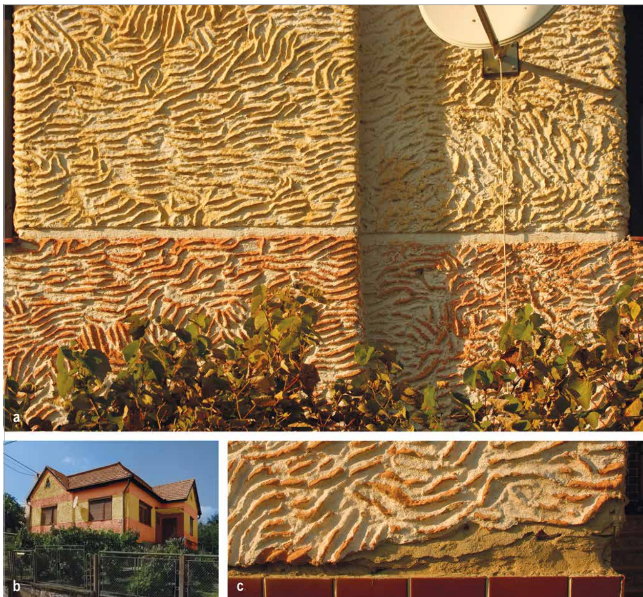
Obr. 7. Slivník (okr. Trebišov), č. 29, dom stavaný okolo r. 1956 zo zmiešaného muriva (kameň, tehla, škarabetónové tvarovky). Stavebník a svojpomocný staviteľ v jednej osobe Jozef Stančík (*1929), povoláním železničiar, vytvoril štruktúru omietky vlastnými prstami (foto autor 2019, celkový záber s rekonštrukciou farebnosti 2015).
