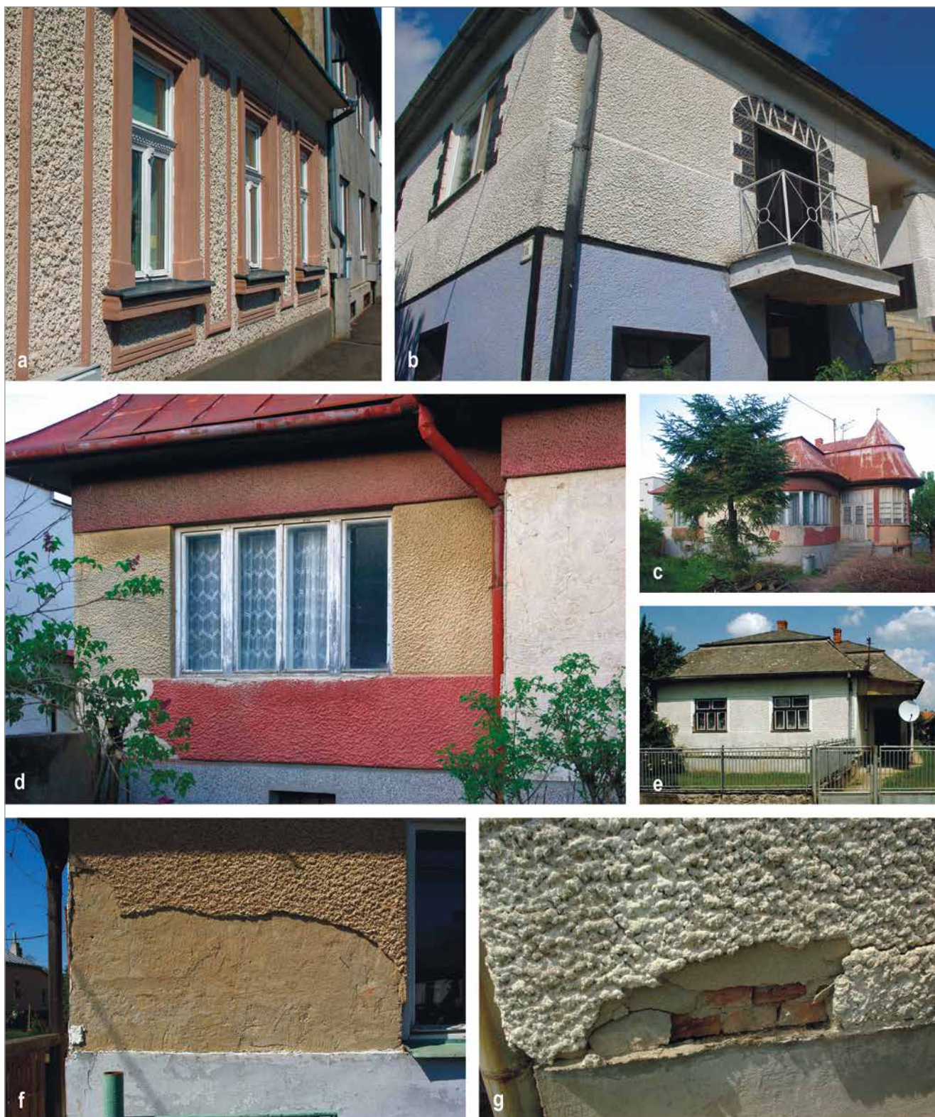
Obr. 6. Metlou kropená omietka, tzv. „baránok“: a – Michalovce, ul. Duklianska č. 1926/18, plastická uličná fasáda vlastného domu staviteľa Alexandra Zbojana pribl. z r. 1920, kombinácia omietok (foto autor 2019); b – Staré (okr. Michalovce), č. 116, dom z r. 1959 – 1962, nárožie uličnej a dvorovej fasády (foto autor 2018); c, d – Veľký Kamenec (okr. Trebišov), č. 126, dom datovaný na plechovej vľajke na streche r. 1960 (foto autor 2018); e, g – Záhор (okr. Sobrance), č. 172, omietka domu zo 60. rokov (foto autor 2016); f – Veľký Horeš (okr. Trebišov), č. 46, baránok a jeho jadrový podklad (foto autor 2018).
