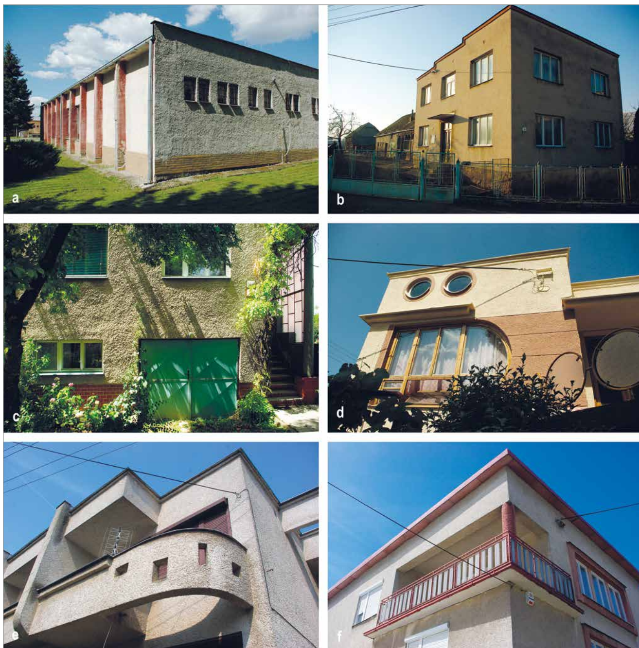
Obr. 22. Škrabaná vápenno-cementová omietka, „brizolit“ 60. až 80. rokov: a – Kladzany (okr. Vranov n/Topľou), zadné nárožie kultúrneho domu stavaného v 70. rokoch (foto autor 2016); b – Oborín (okr. Michalovce), č. 96 (foto autor 2016); c – Trebišov, ul. Záhradná č. 2098/17, uličná fasáda domu (foto autor 2016); d – Vranov n/Topľou-Dlhé, č. 742, dvorová strana nárožia domu z r. 1968 (foto autor 2016); e – Zemplín (okr. Trebišov), č. 63, detail uličnej fasády domu z r. 1980 (foto autor 2018); f – Pavlovce n/Uhom (okr. Michalovce), č. 786, nárožie poschodia (foto autor 2018).
