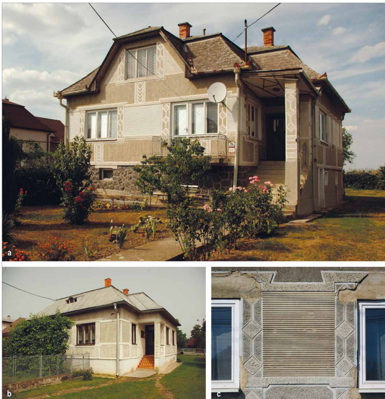
Obr. 14. Omietkové zostavy s motívom kosých štvorcov a drobnopisnou pásovou bosážou (á la pracia rumpľa): a – Nižný Žipov (okr. Trebišov), č. 288, dvojtraktový dom so suterénom a manzardkou z r. 1968 (foto autor 2015); b – Dúbravka (okr. Michalovce), č. 177 (foto autor 2016); c – Falkušovce (okr. Michalovce), č. 177, detail uličnej fasády (foto autor 2018).
