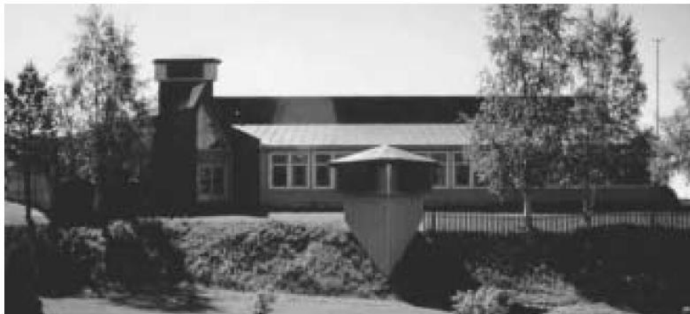
2.17 Pohled na přívodní (v popředí) a odvodní větrnou větrací věž základní školy Media v Grongu, Norsko - (Kleiven, 2003)
