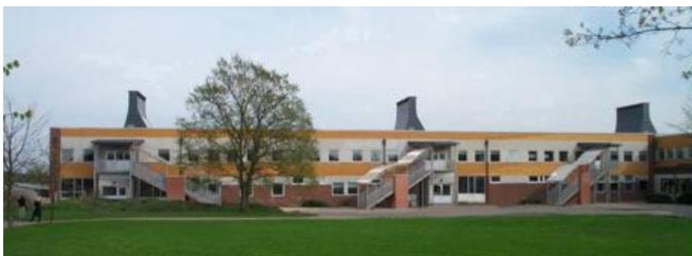
2.12 Obr. Pohled na budovu školy Tanga se solárními komíny - (MÜLLER, 2006 -3)
