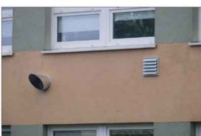
2.28 Obr. Nucené větrání – odvod vzduchu a větrací jednotka v učebně – detail řešení přívodních a odvodních prvků na fasádě - (Begeni, a další, 2014)
