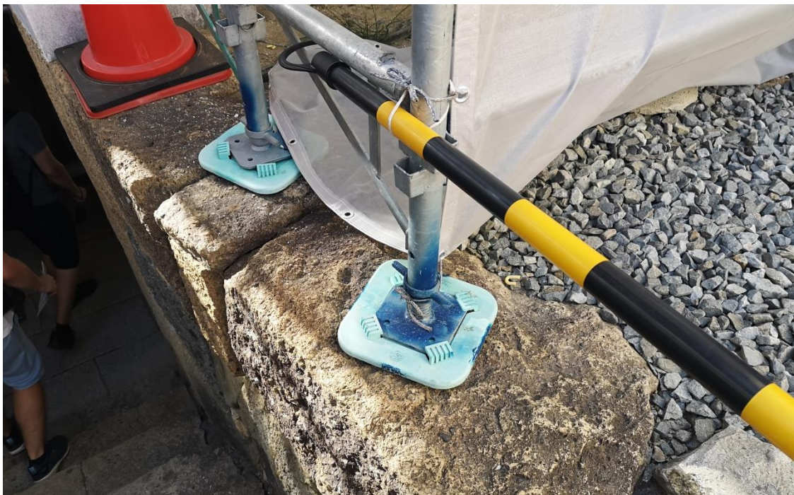
Obrázek 23: Systémové řešení protiskluzného opatření [archiv autora]
