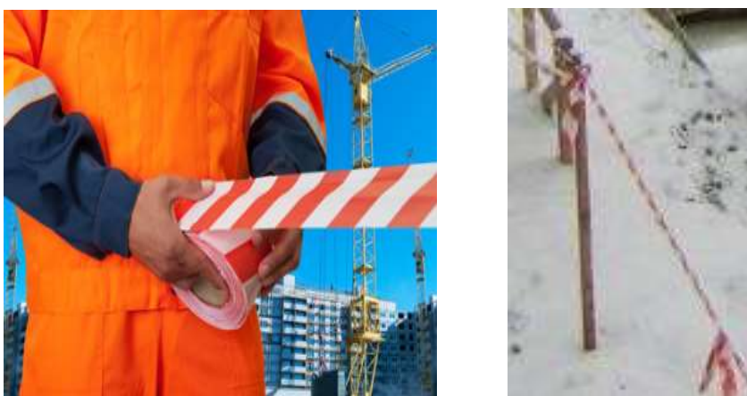
Obrázek 17 - PVC páska ohraničující výkop [20,21]
