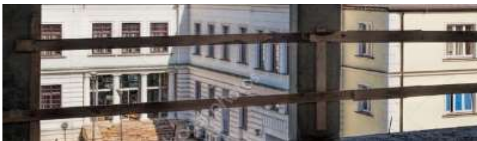
Obrázek 24 - Dřevěné pomocné zábradlí [24]
