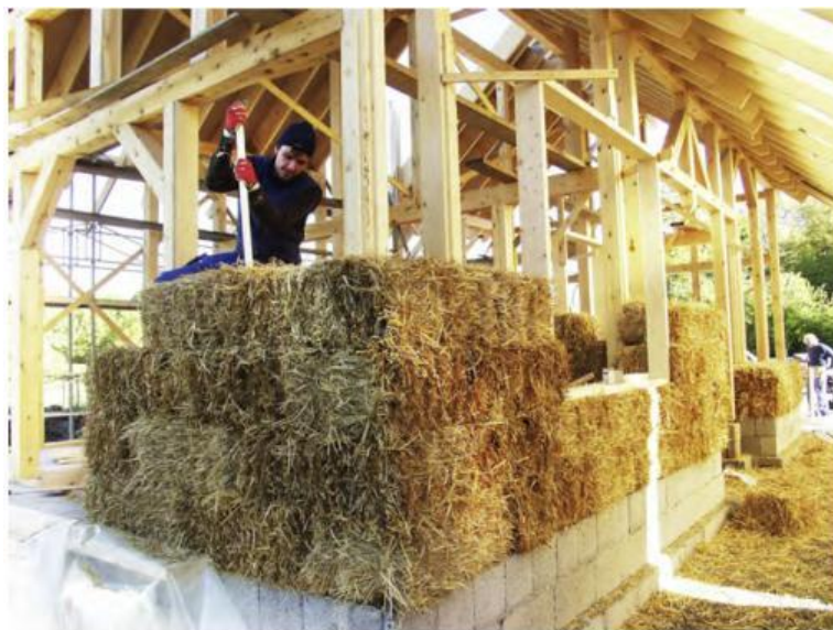
Obr. 1: Realizace obvodových stěn ze slámy [2]
