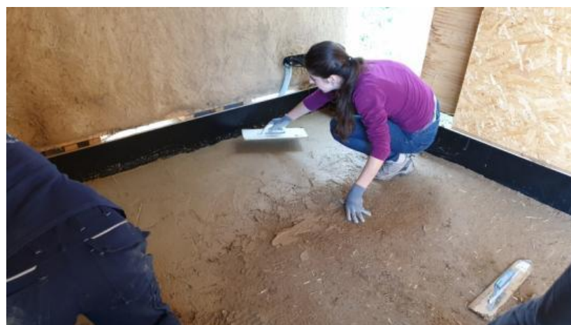
Obr. 27: Finální vyrovnávací stěrka
