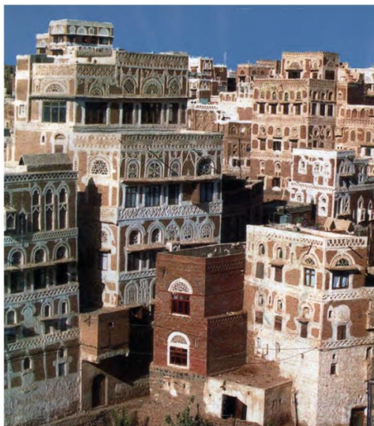
Obr. 13: Tradiční stavba z jílové směsi – Jemen [3]
