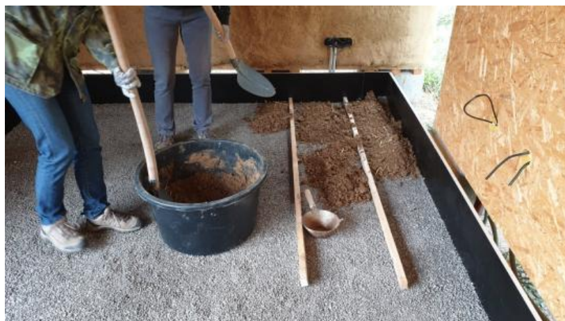
Obr. 29: Rozložení vodících latí
