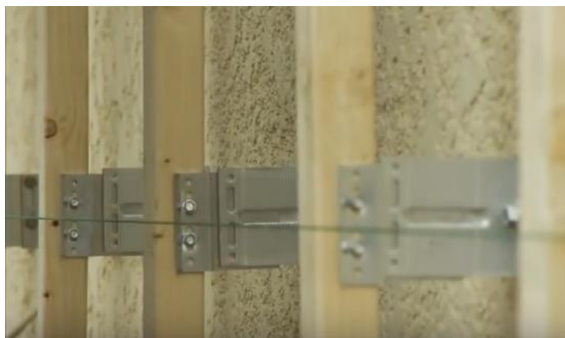
Obr. 41: připevnění latí [26]
