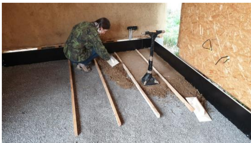
Obr. 28: Proces dusání směsi
