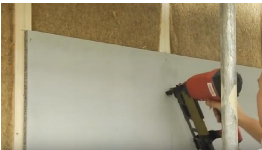
Obr. 43: Příprava SDK povrchu k nanesení omítky [26]
