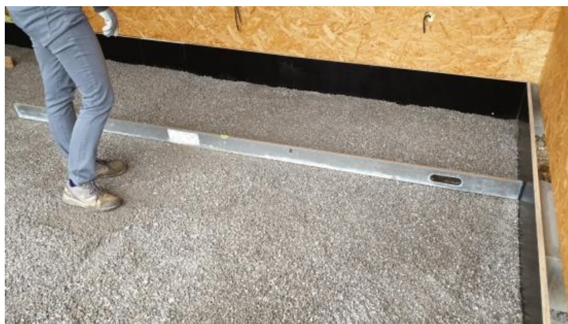
Obr. 24: Kontrola rovinnosti podkladu pomocí libely
