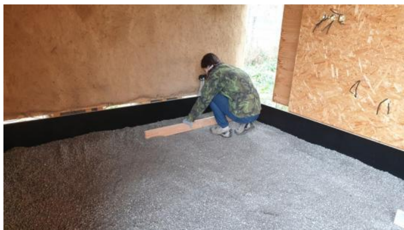
Obr. 25: Příprava povrchu za pomoci latě
