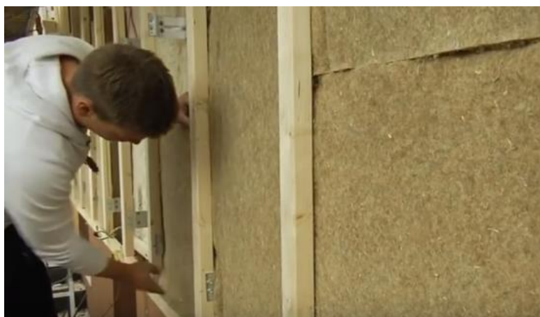
Obr. 42: Kladení druhé vrstvy izolace mezi latě [26]
