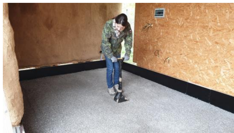
Obr. 23: Dusání štěrku pomocí dusadla
