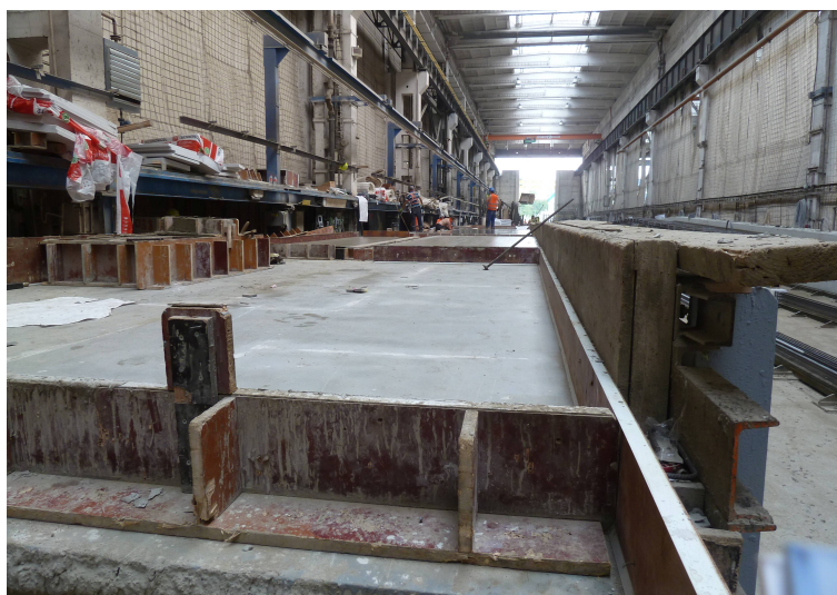
Obrázek 1.3: Bednicí plocha z voděodolné překližky, truhlářsky prováděné bočnice
