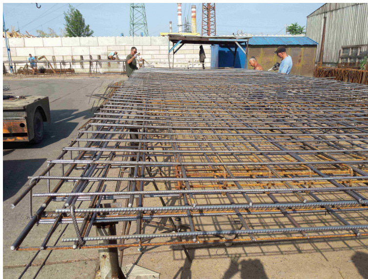
Obrázek 4.2: Vyvazování armatury stěny
