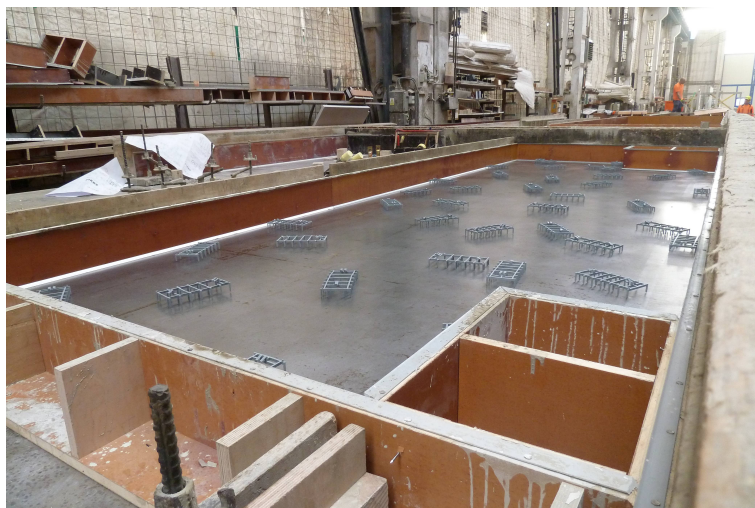
Obrázek 1.5: Plocha připravená pro uložení výztuže
