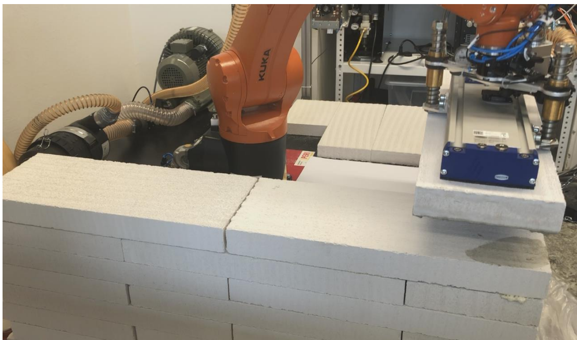
Obr. 73 Namočená cihla do maltové směsi ukládána do konstrukce rohu, převzato z [26]
