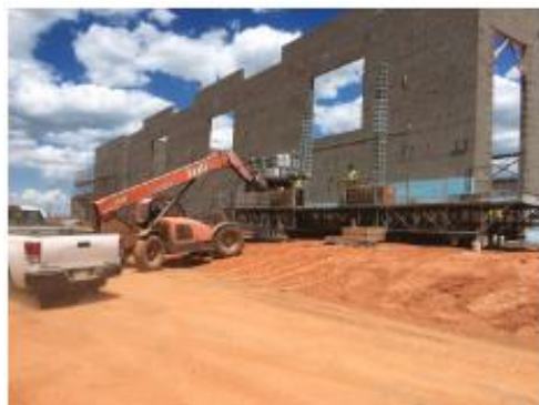
Obr. 13 Hlavní modul umístěn na zvedací plošině, převzato z [21]
