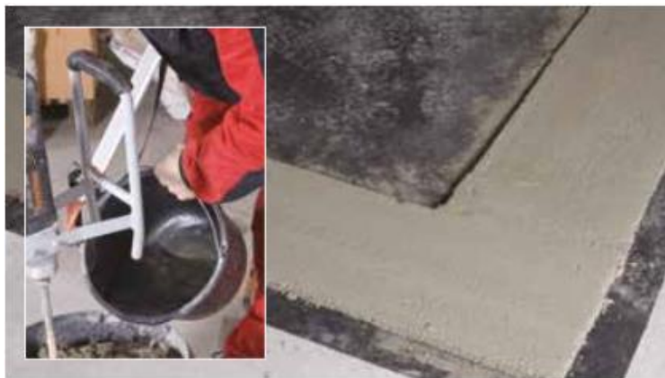
Obr. 14 Příprava maltového lože na položení první vrstvy cihel, převzato z [15]
