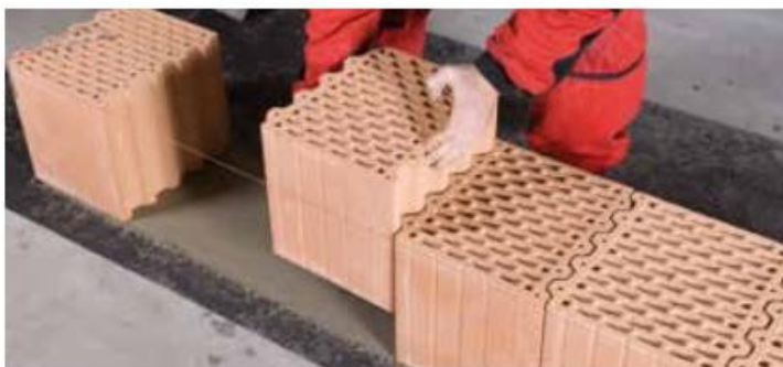
Obr. 16 Osazení první vrstvy cihel, převzato z [15]
