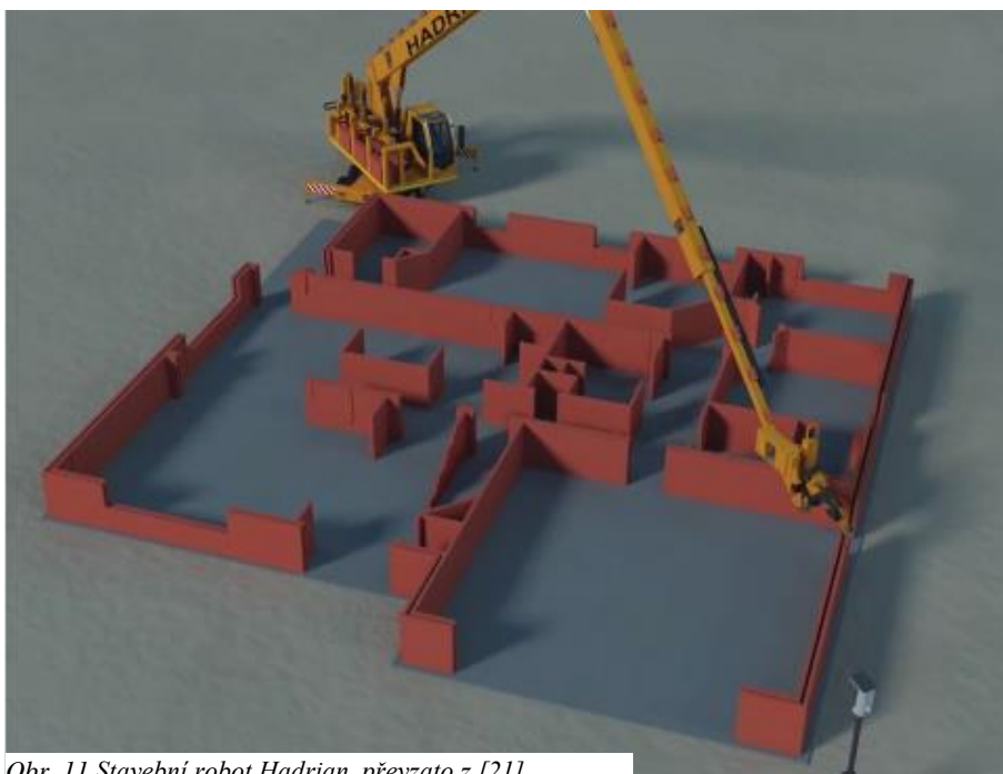
Obr. 11 Stavební robot Hadrian, převzato z [21]
