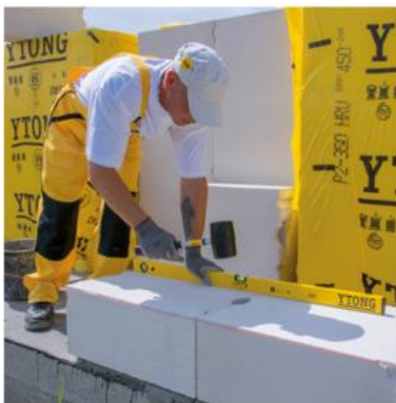
Obr. 22 Pokládání první řady tvárnic, převzato z [16]
