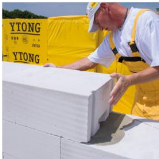
Obr. 23 Přesah tvárnice o 100 mm, převzato z [16]
