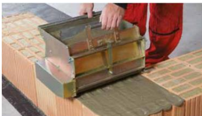
Obr. 18 Nanášení malty pomocí maltovacího vozíku, převzato z [15]
