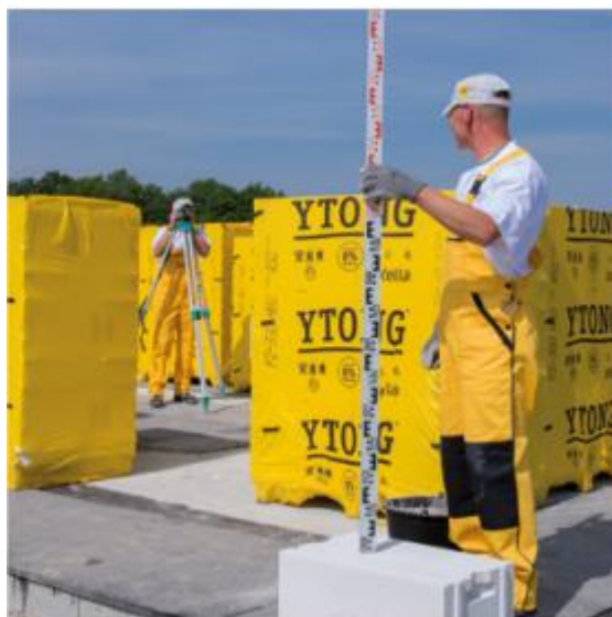
Obr. 21 Výšková kontrola rohových tvárnic, převzato z [16]
