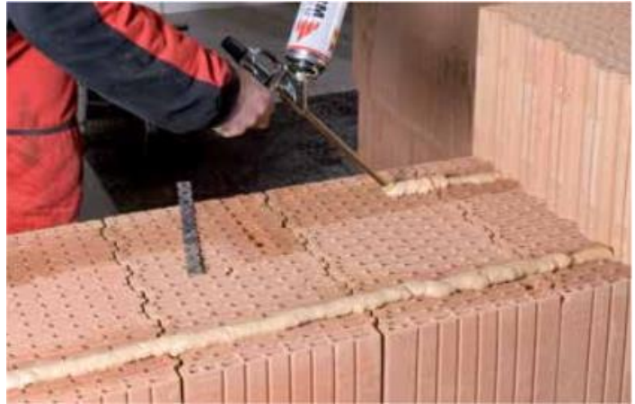
Obr. 19 Nanášení zdící pěny, převzato z [15]
