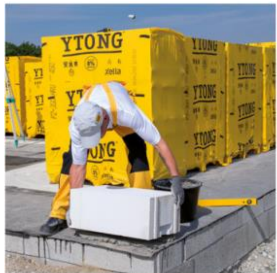
Obr. 20 Ukládání rohové cihly do maltového lože, převzato z [16]
