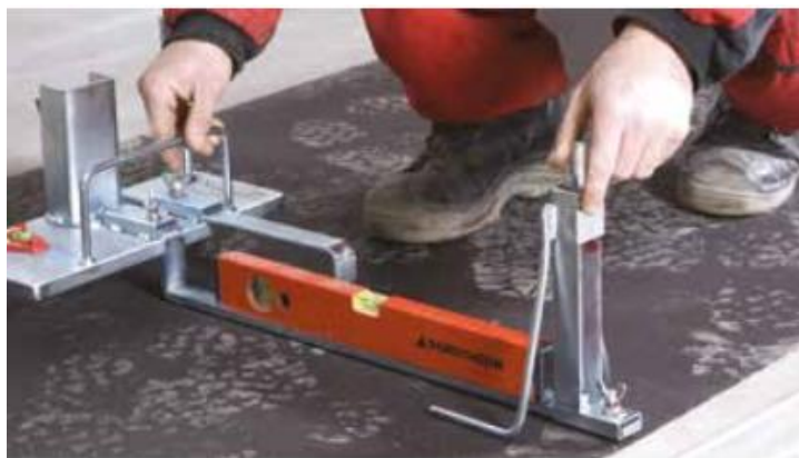
Obr. 15 Nastavení přípravku vyrovnávací vrstvy, převzato z [15]
