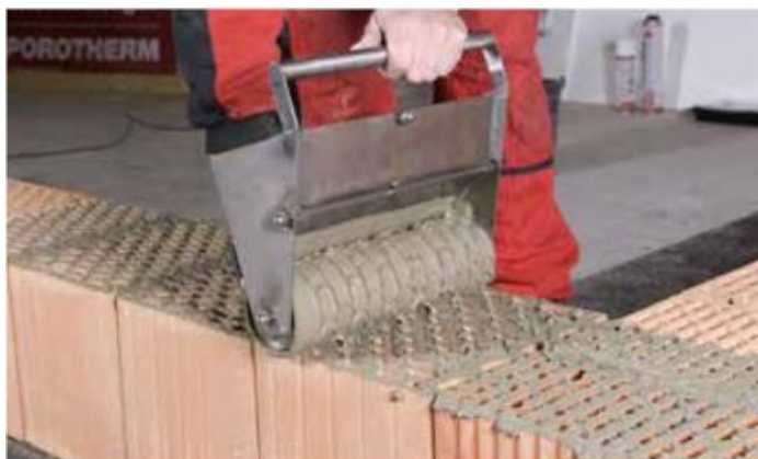
Obr. 17 Nanášení malty pro další vrstvy pomocí nanášecího válce, převzato z [15]
