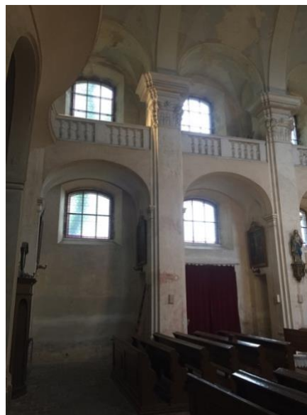
obr. 2.6 Valená klenba mezi pilíři
