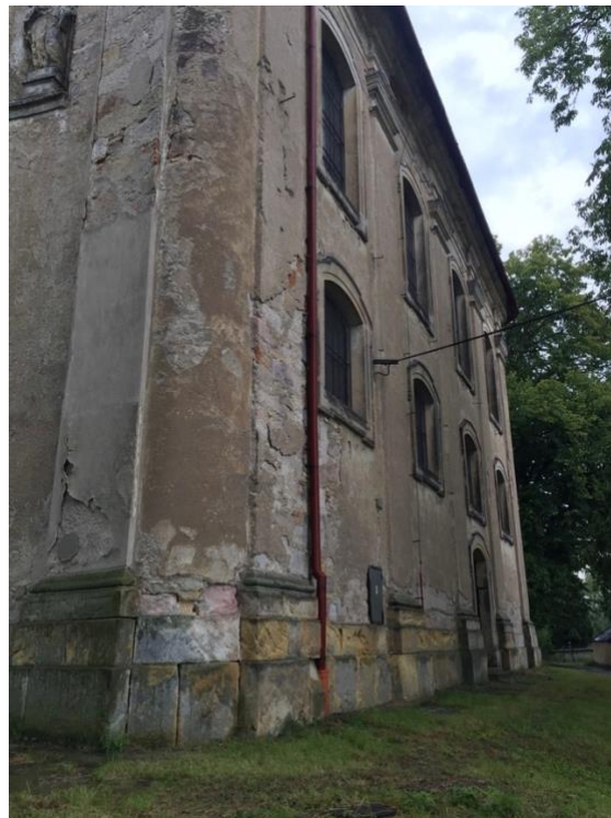
obr. 2.3 Sokl z kamenných kvádrů
