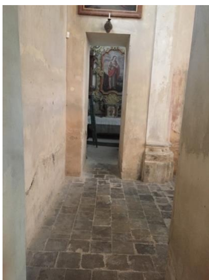
obr. 2.12 Kamenné dlaždice a litá podlaha
