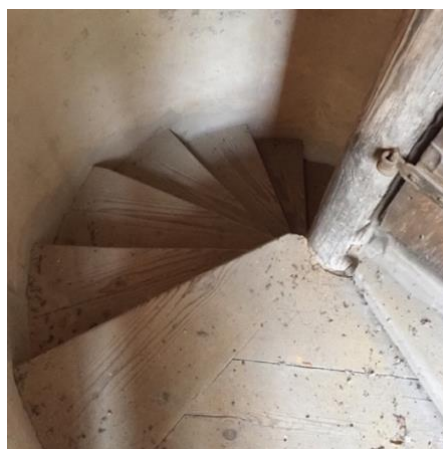
obr. 2.4 Vnitřní vřetenová schodiště
