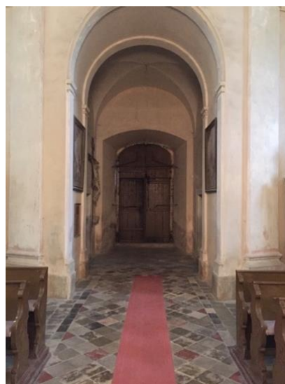
obr. 2.13 Kamenná dlažba a keramické dlaždice
