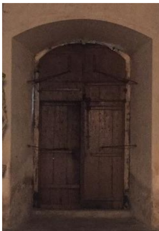
obr. 2.15 Hlavní dřevěné dveře
