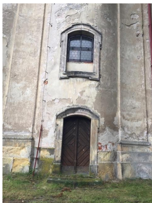
obr. 2.18 Jednoduché portály a šambrány
