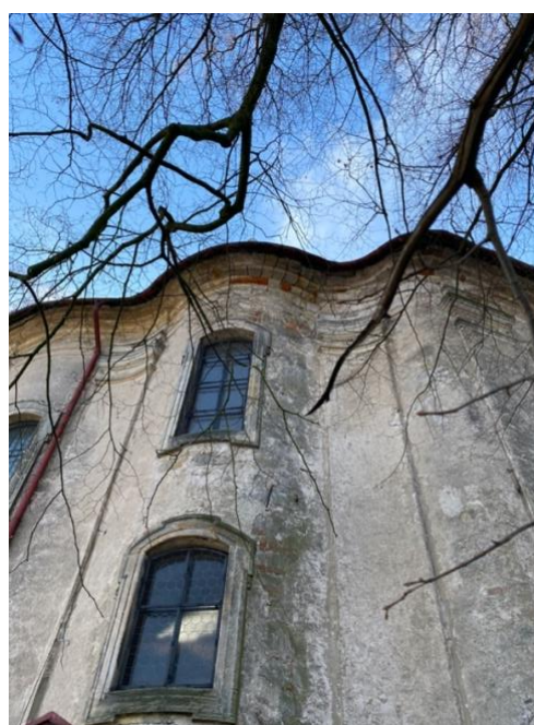
obr. 2.9 degradovaná římsa
