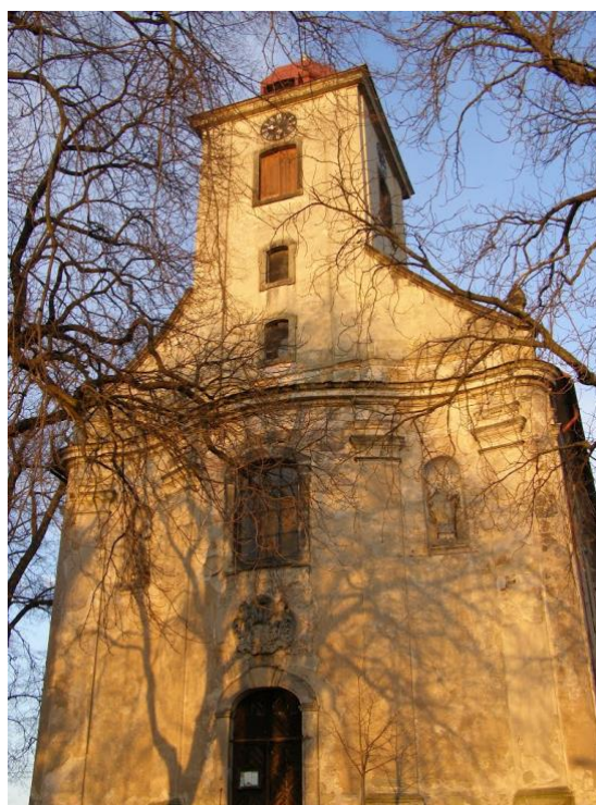
obr. 1.5 Pohled východní fasáda
