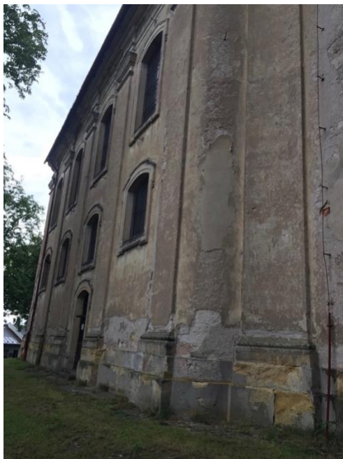
obr. 2.16 Ztužující pilíře a římsy
