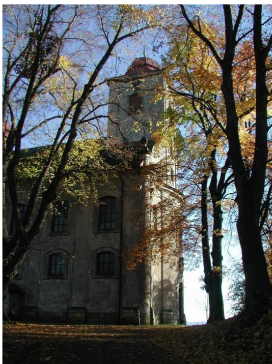
obr. 1.4 Pohled severní fasáda
