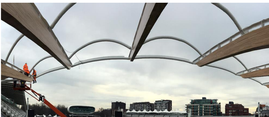
Obrázek 49 – Lord's Cricket Ground – pohled na odkrytou konstrukci [32]
