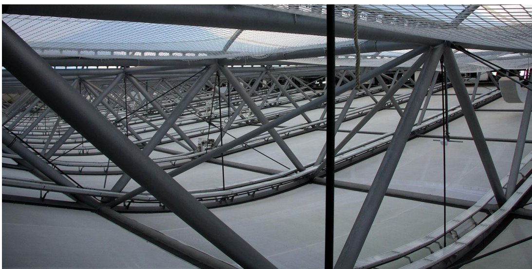
Obrázek 45 – Olympijský stadion – foto – pohled do vnitřku ocelové konstrukce [27]
