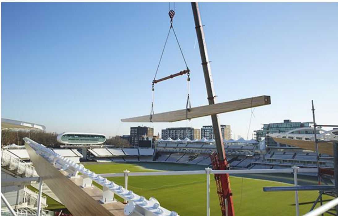
Obrázek 48 – Lord's Cricket Ground – instalace vazníků [31]
