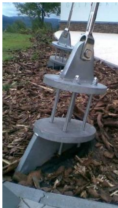
Obrázek 33 – Napojení lana k patce přes koncovku [23]
