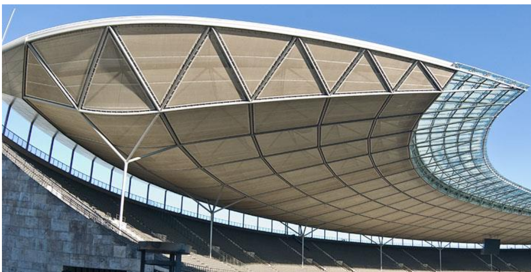
Obrázek 44 – Olympijský stadion – výsledná podoba ocelové konstrukce [29]
