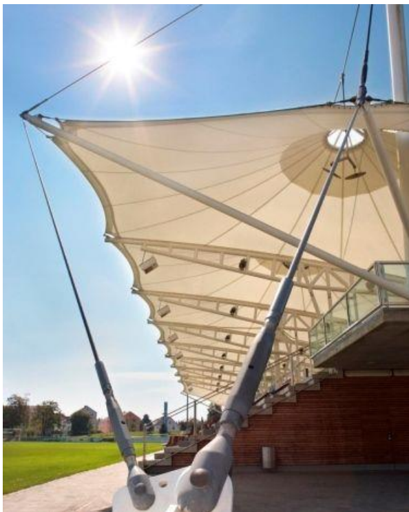
Obrázek 55 – Abenstein Arena – foto - detail ukotvení lan do základů [37]
