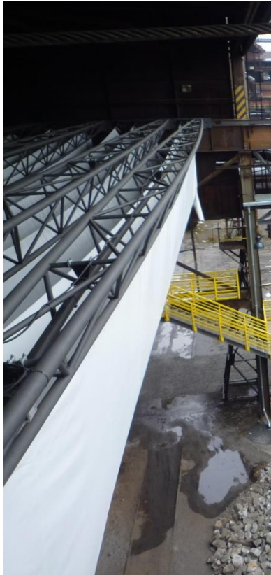
Obrázek 36 – Vysoká pec č.1 – foto – nosníky [25]
