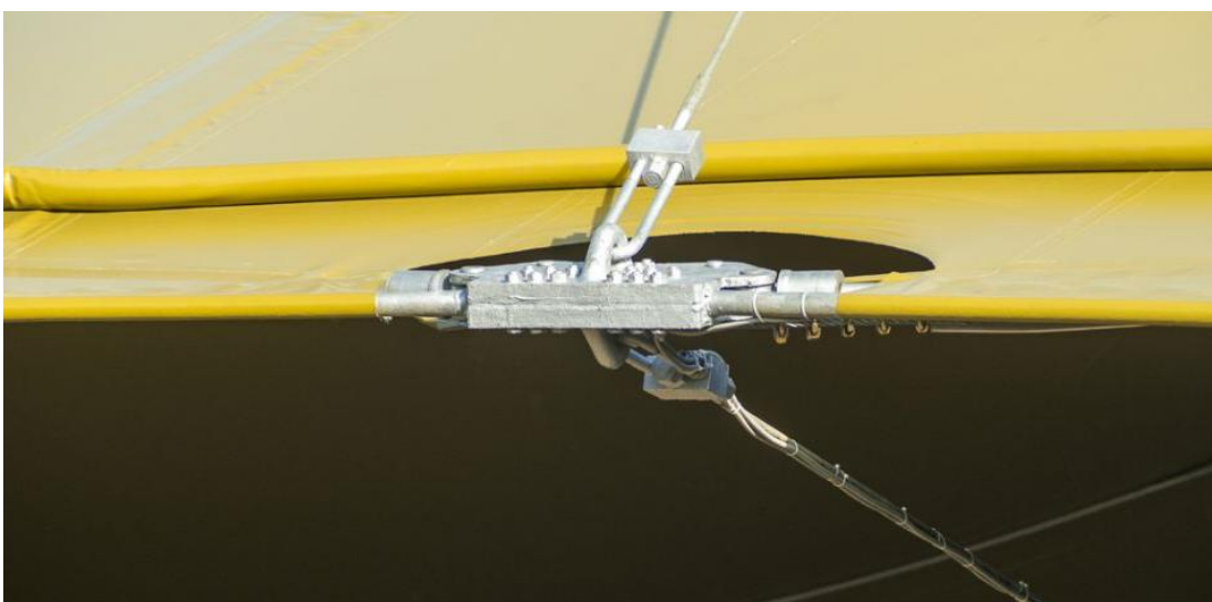
Obrázek 61 – Elspe Grandstand – foto – detail spoje kotevnicích lan s okrajovými lany membrány [38]
