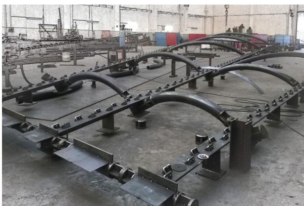
Obrázek 50 – Lord's Cricket Ground – ocelová konstrukce oblouků [33]
