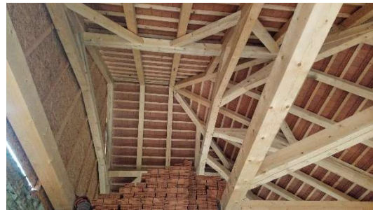
Obrázek 31 - nová provizorní střecha z roku 2007 [autor]
