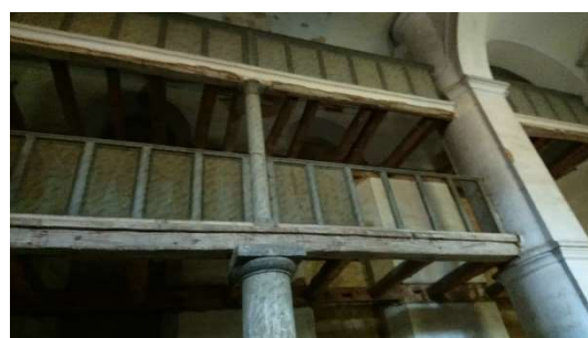
Obrázek 53 - nosná konstrukce galerií [autor]
