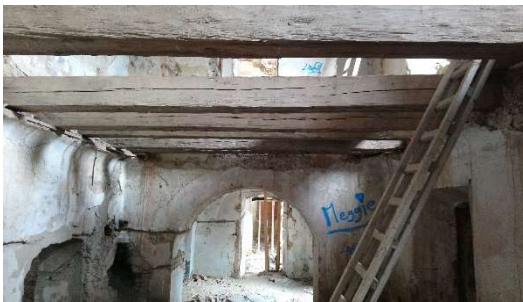
Obrázek 25 - trámový strop v 1.NP v přístavbě [autor]
