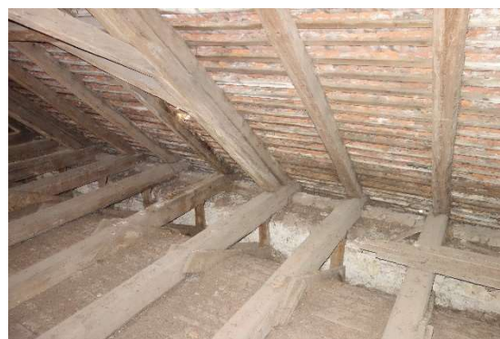
Obrázek 59 - zavěšení nepravé klenby na vazné trámy [autor]
