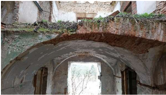
Obrázek 22 - valená klenba ve vstupní hale [autor]
