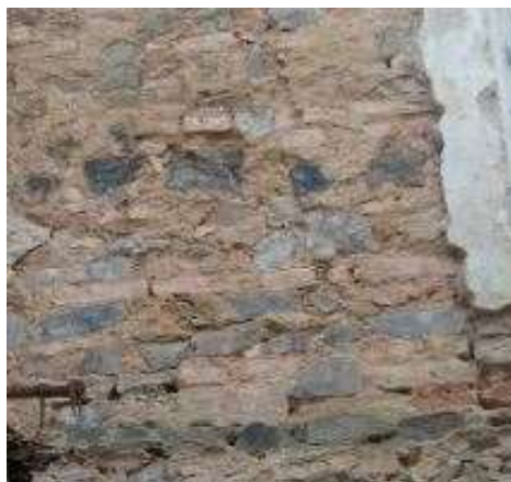
Obrázek 37 - ukázka skladby zdiva, Brnky [autor]
