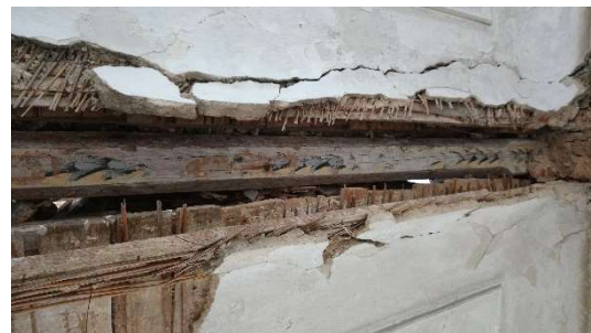
Obrázek 24 - výtvarně zdobený stropní trám [autor]
