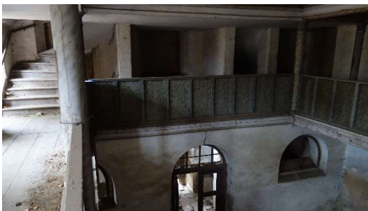
Obrázek 57 - vřetenové schodiště v 2.NP [autor]
