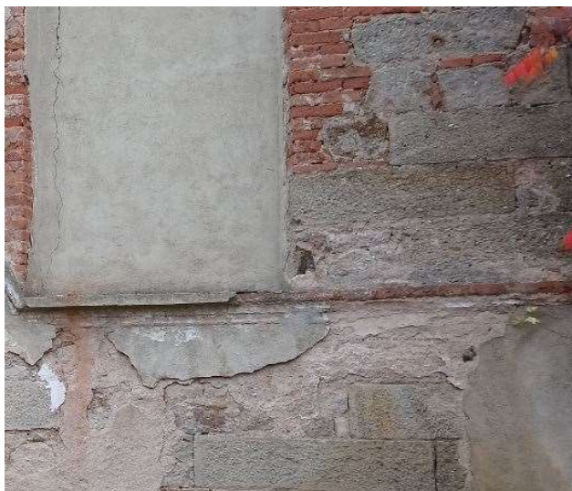
Obrázek 67 - ukázka skladby zdiva u synagogy [autor]
