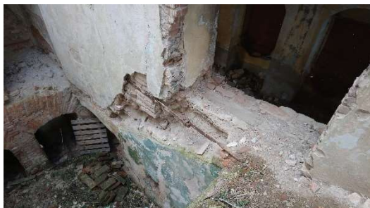
Obrázek 20 - železná spona ve zdivu [autor]
