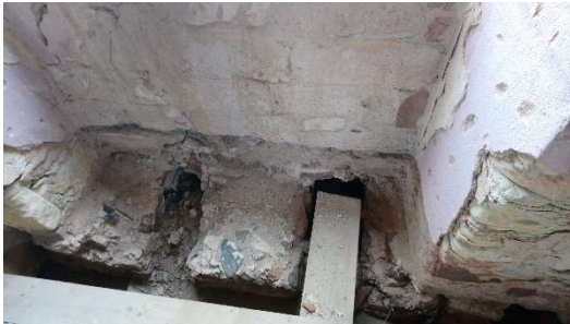
Obrázek 27 - uložení trámových stropů [autor]
