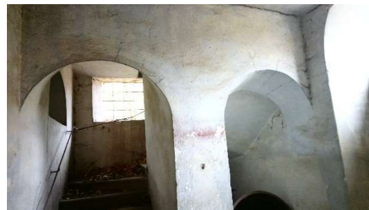
Obrázek 56 - nosná konstrukce tvořená valenými klenbami [autor]
