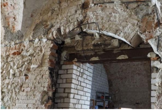
Obr.31: Dodatečné provedení překladu
