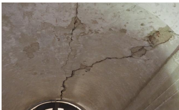
Obr:39 a 40: Trhliny v segmentovém klenutí schodiště
