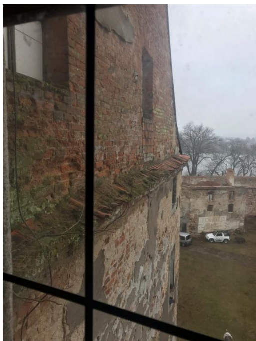
Obr.37: Degradace korunní římsy
