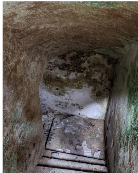
Obr.28: Schodiště vedoucí do zachovalého sklepa
