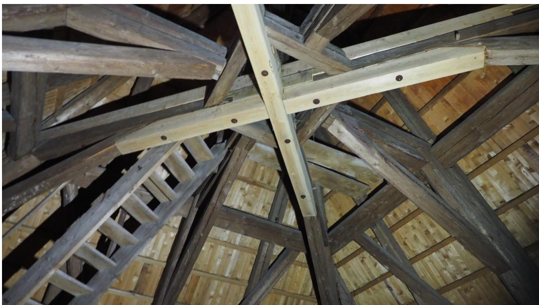
Obr.12: Konstrukce vaznicového krovu věže
