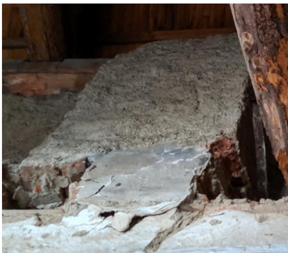
Obr:52: Uložení pozednice na pilíře
