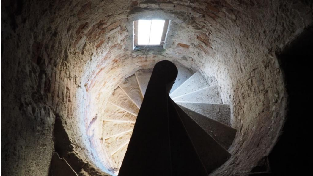
Obr.11: Vřetenové schodiště věže
