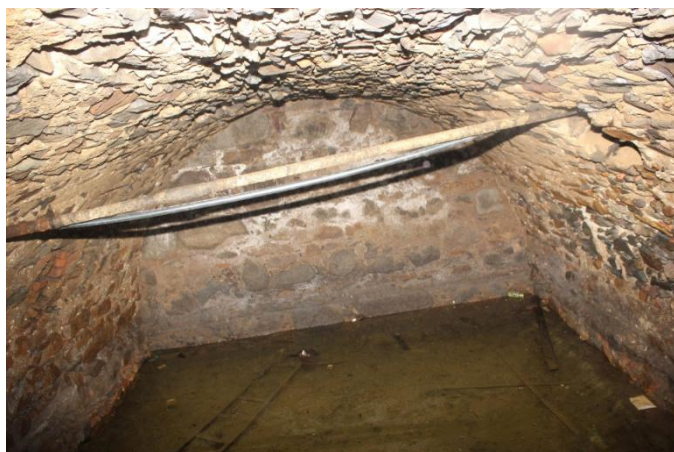
Obr.8: sklepní prostory bývalé hladomorny
