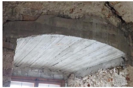
Obr.32: Betonové nadpraží
