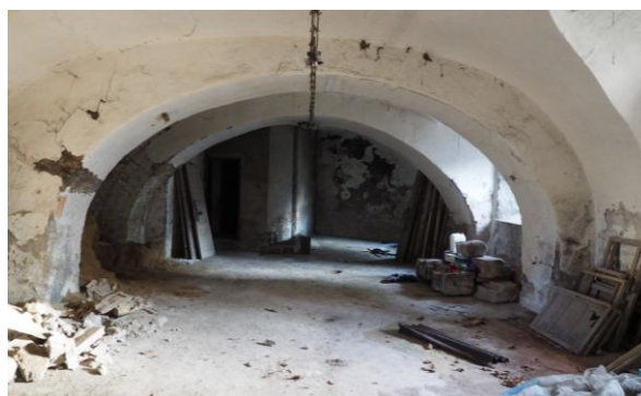
Obr.25: přízemní místnost s valenou klenbou ztuženou masivními valenými pásy
