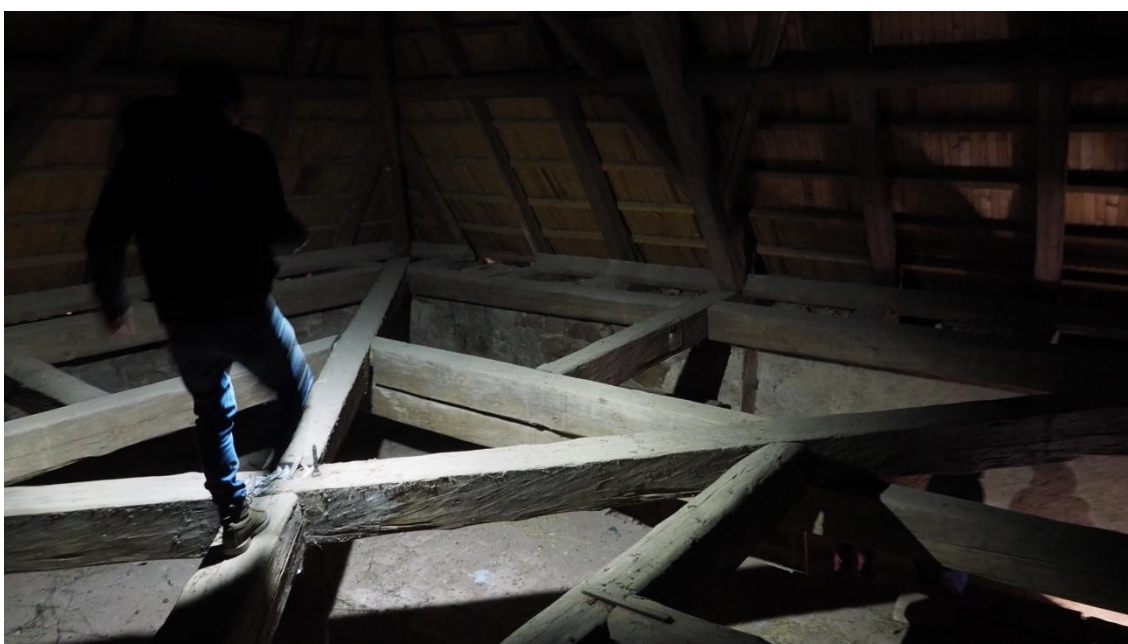
Obr.13: Napojení vazných trámů
