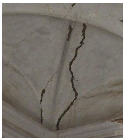
Obr:42-45: Porušení trhlínami třetího a čtvrtého nadzemního podlaží
