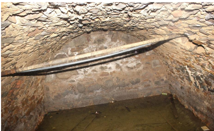
Obr:41: Vodní hladina se v průběhu roka mění (viditelné na stěně v pozadí)
