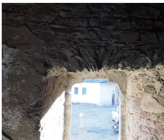
Obr.25: Kamenné gotické ostění s gotickým sedlovým portálem osazeným na vnější straně
