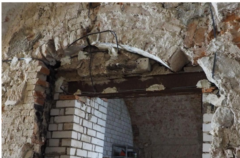
Obr.75: Současný stav nadpraží dveřních otvorů
