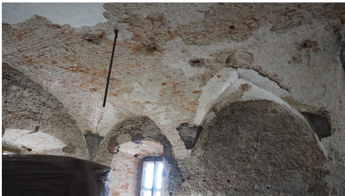
Obr.16: Přízemní klenba s pozůstatky původních gotických konzol
