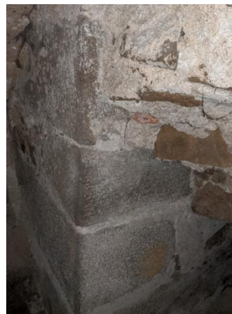
Obr.9: kamenné armatury v nároží
