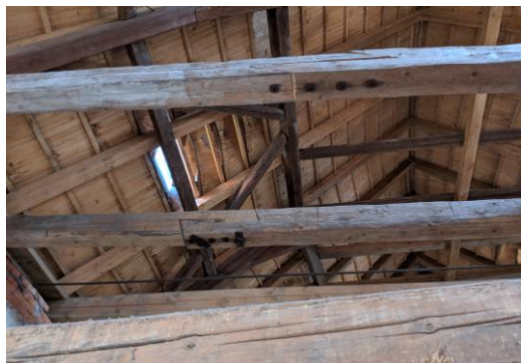
Obr.24: Opravený krov správního křídla
