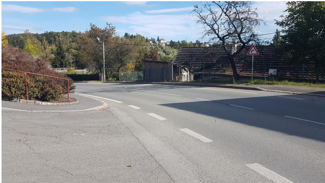
Obrázek 55: Současný stav nároží křižovatky silnice I/19 a ulice k č.p. 304 směr Tábor (nedostatečný rozhled)
