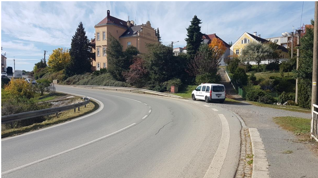
Obrázek 61:Směrový oblouk silnice I/19 s napojením místní komunikace k č.p. 26 směr Plzeň
