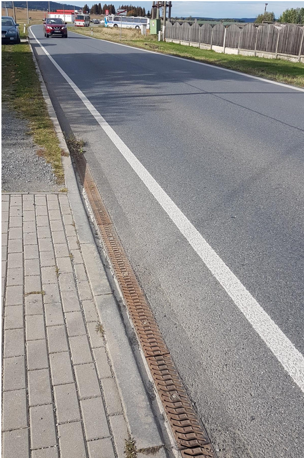
Obrázek 8: Stávající kryt vozovky s detailem na způsob odvodnění dešťové vody před vjezdem na pozemek
