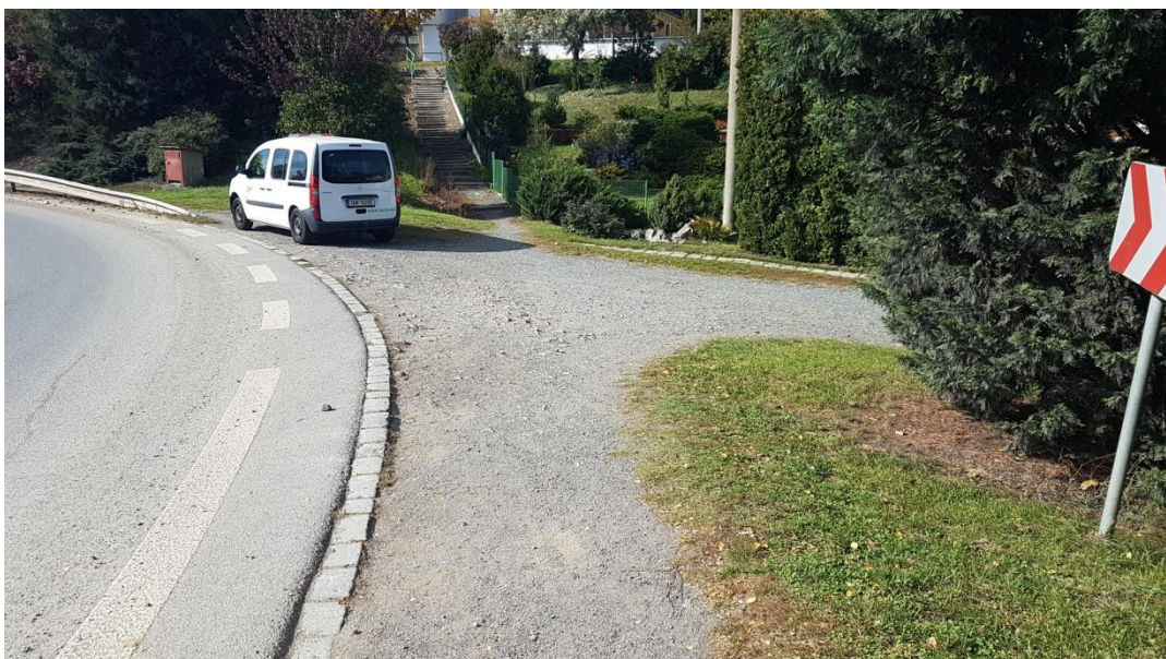
Obrázek 60: Stávající stav chodníků a vozovky místní komunikace k č.p. 26 směr Plzeň
