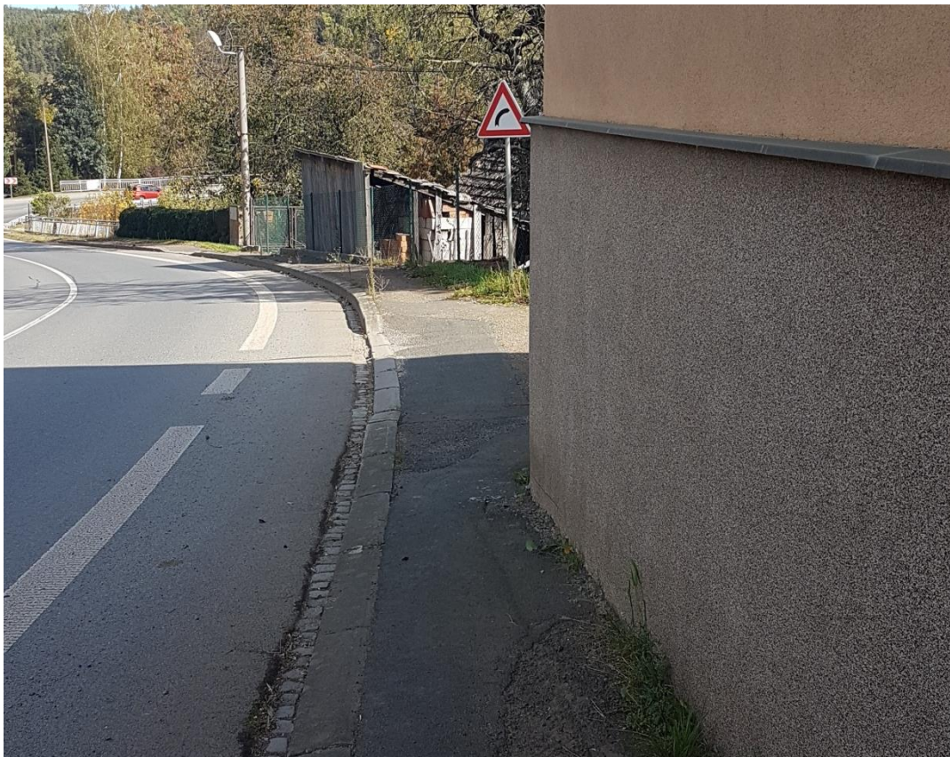
Obrázek 52: Šířkové uspořádání PMK s detailem na šířku chodníku u č.p. 23 směr Tábor
