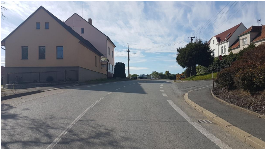
Obrázek 56: Směrový oblouk silnice I/19 v křižovatce s místní komunikací k obecnímu úřadu směr Plzeň
