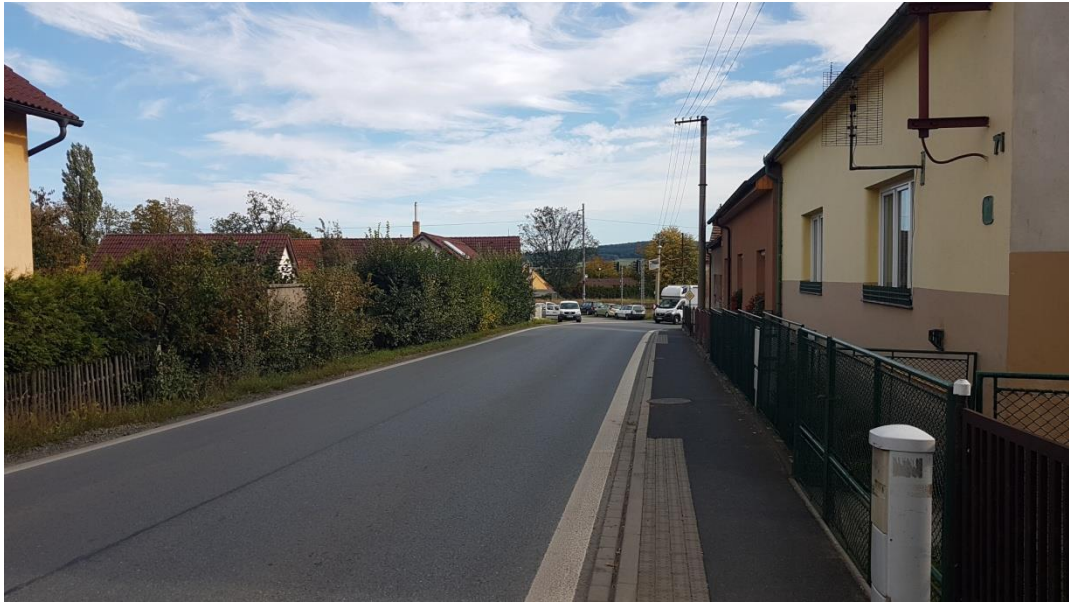
Obrázek 19: Přímý úsek silnice I/19 směr Tábor před směrovým obloukem u č.p. 70
