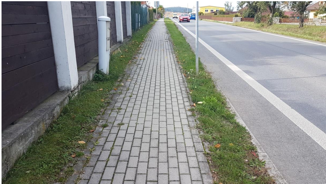
Obrázek 13: Stávající stav chodníku z betonové dlažby směr Plzeň
