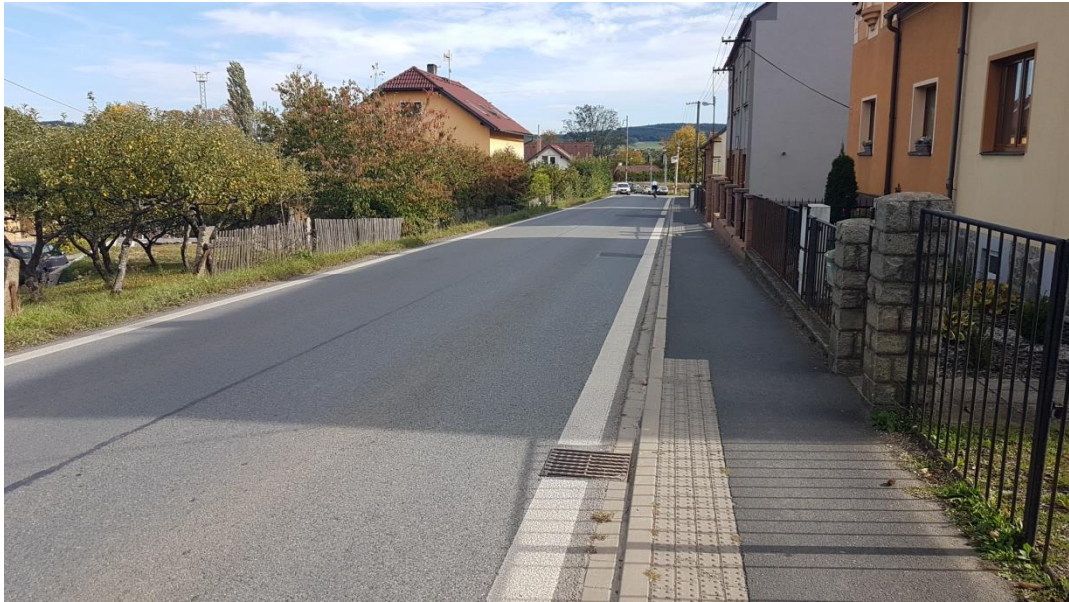
Obrázek 17: Stávající stav chodníku a silnice I/19 směr Tábor
