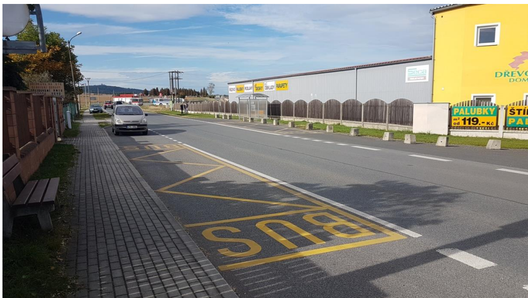
Obrázek 10: Stávající autobusové zastávky v zálivech – „Nezvěstice - garáž ČSAD“ směr Plzeň
