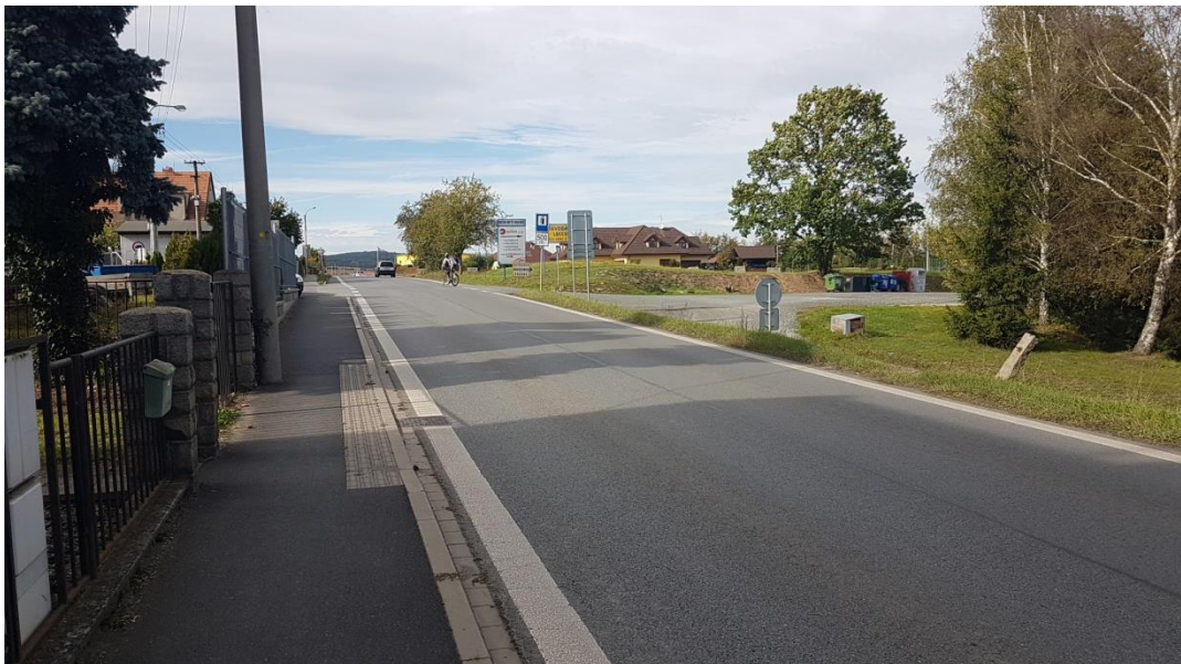
Obrázek 18: Stávající stav chodníku a silnice I/19 před průsečnou křižovatkou směr Plzeň
