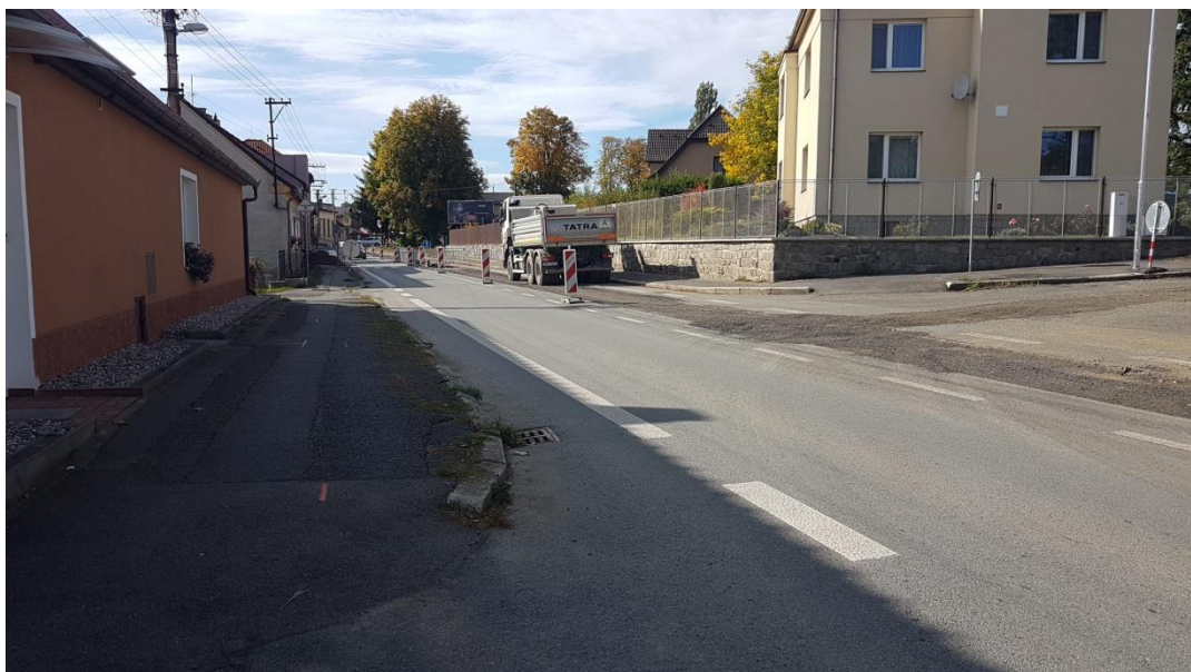
Obrázek 32: Současný stav chodníků a silnice I/19 směr Plzeň
