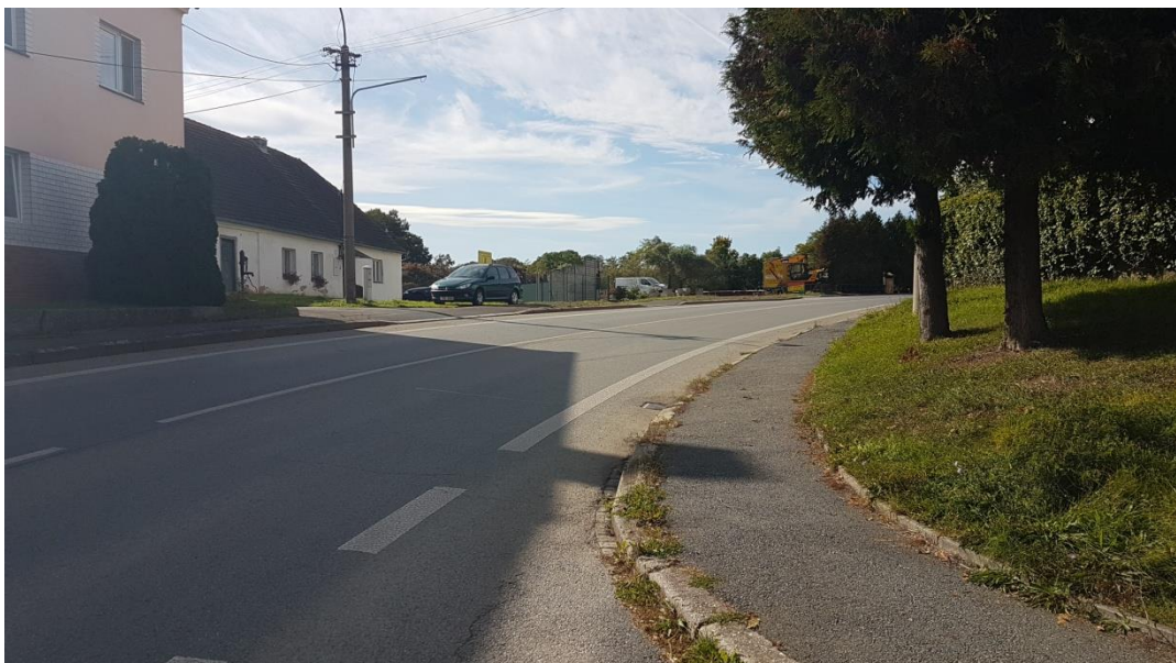
Obrázek 54: Současný stav nároží křižovatky komunikací I/19 a ulice k č.p. 304 směr Plzeň
