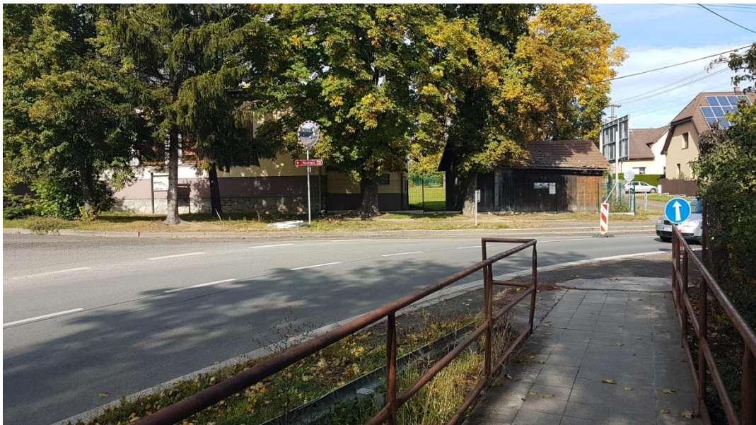
Obrázek 26: Směrový oblouk silnice I/19 směr Tábor s pohledem na dopravní zrcadlo a sokolovnu
