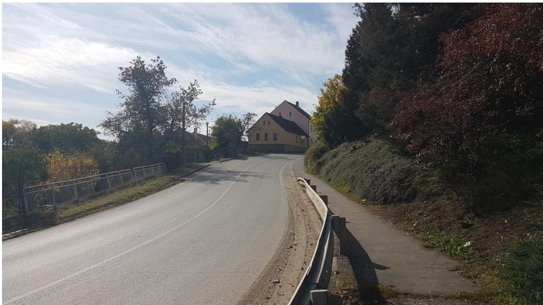
Obrázek 58: Stávající silniční svodidlo z důvodu geometrických proporcí směrového oblouku směr Plzeň
