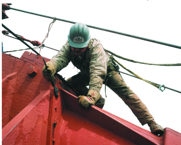
Obrázek 25 - Natírání ocelové konstrukce [19]
