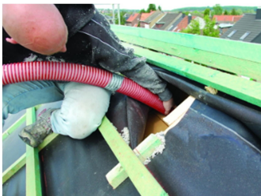
Obrázek 38 Realizace foukané izolace [39]
