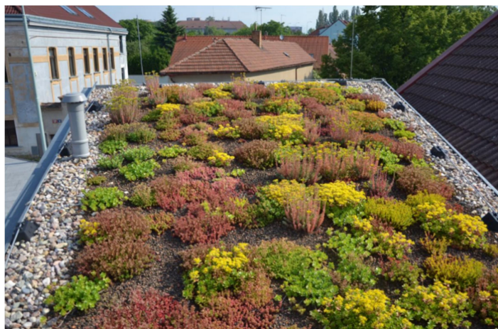
Obrázek 27 Extenzivní zelená střecha [40]
