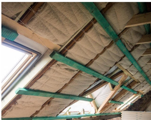
Obrázek 32 Realizace zateplení z ovčí vlny [21]
